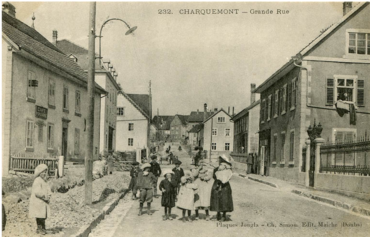
232. Charquemont - Grande Rue [au niveau des n° 54 à gauche et 45 à droite], 1er quart 20e siècle (juillet 1904 ?). 25, Charquemont, 45 et 47 Grande Rue
