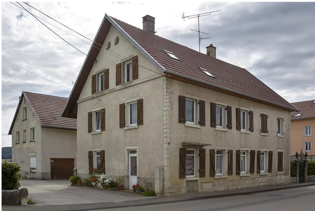
Maison au n° 45 : façades antérieure et latérale gauche.
