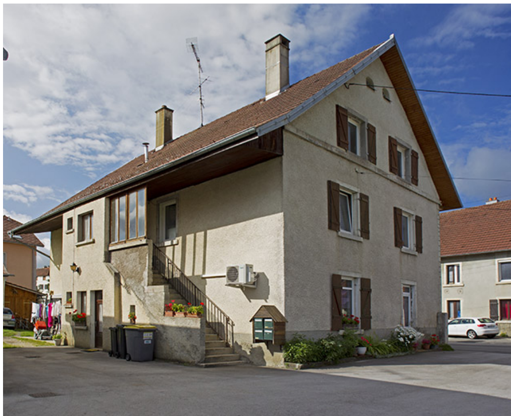
Maison au n° 45 : façades postérieure et latérale gauche.
