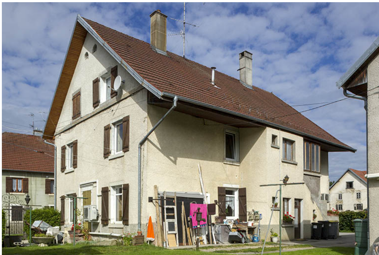
Maison au n° 45 : façades postérieure et latérale droite.
