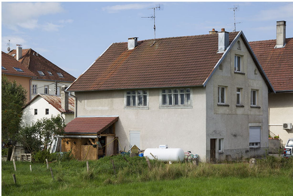
Maison au n° 47 : façades postérieure et latérale gauche.
