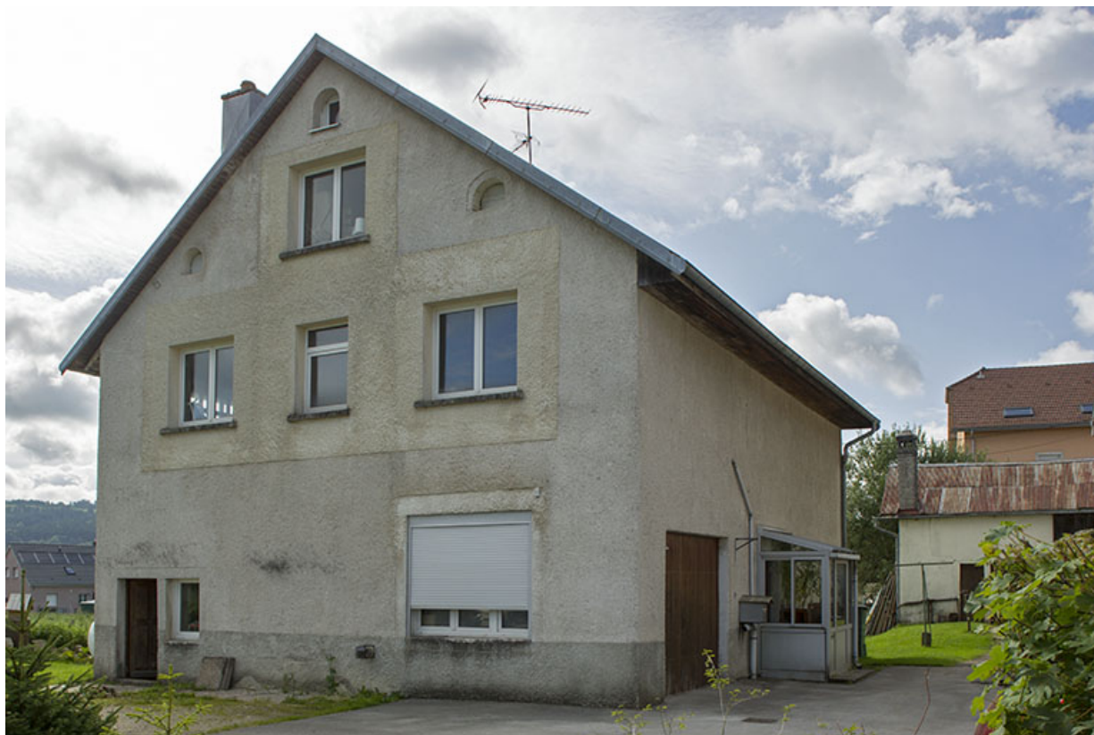
Maison au n° 47 : façades antérieure et latérale gauche.
