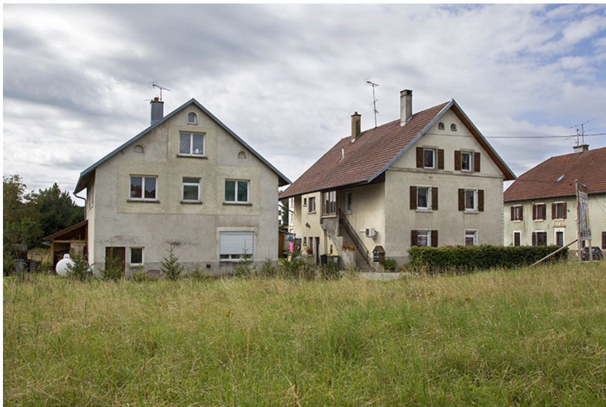
Vue d'ensemble, depuis le nord. Maison au n° 47 à gauche, au n° 45 à droite. 25, Charquemont, 45 et 47 Grande Rue
