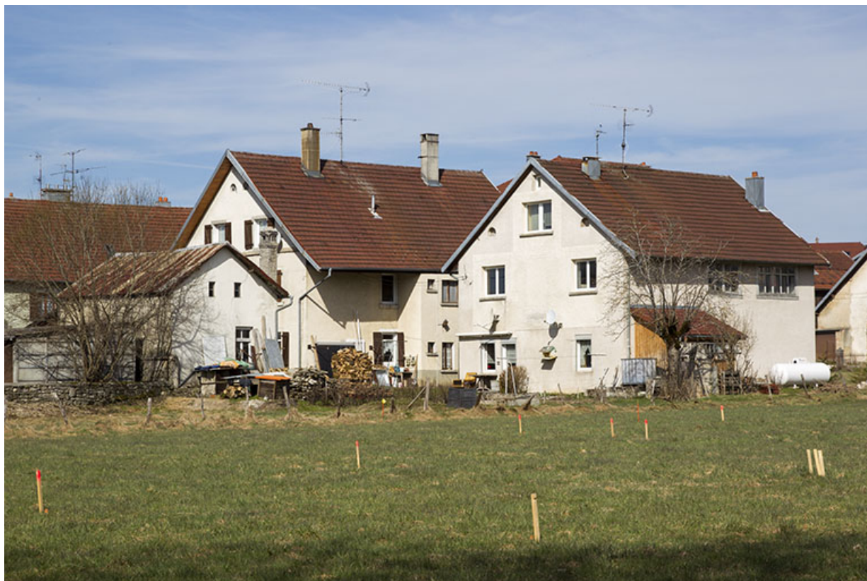
Vue d'ensemble, depuis le sud-ouest. Maison au n° 45 à gauche, au n° 47 à droite. 25, Charquemont, 45 et 47 Grande Rue
