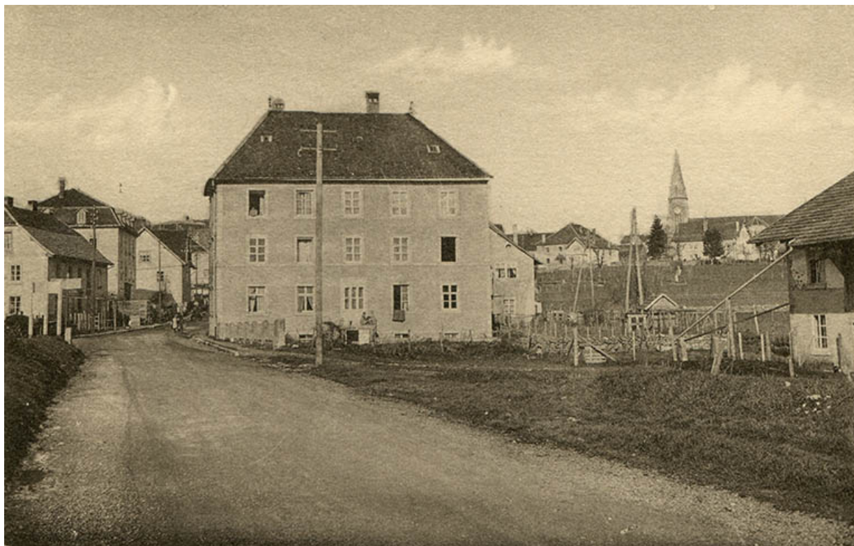
Charquemont (Doubs) - Vue générale [l'immeuble vu du sud], milieu 20e siècle. 25, Charquemont, 49 Grande Rue
