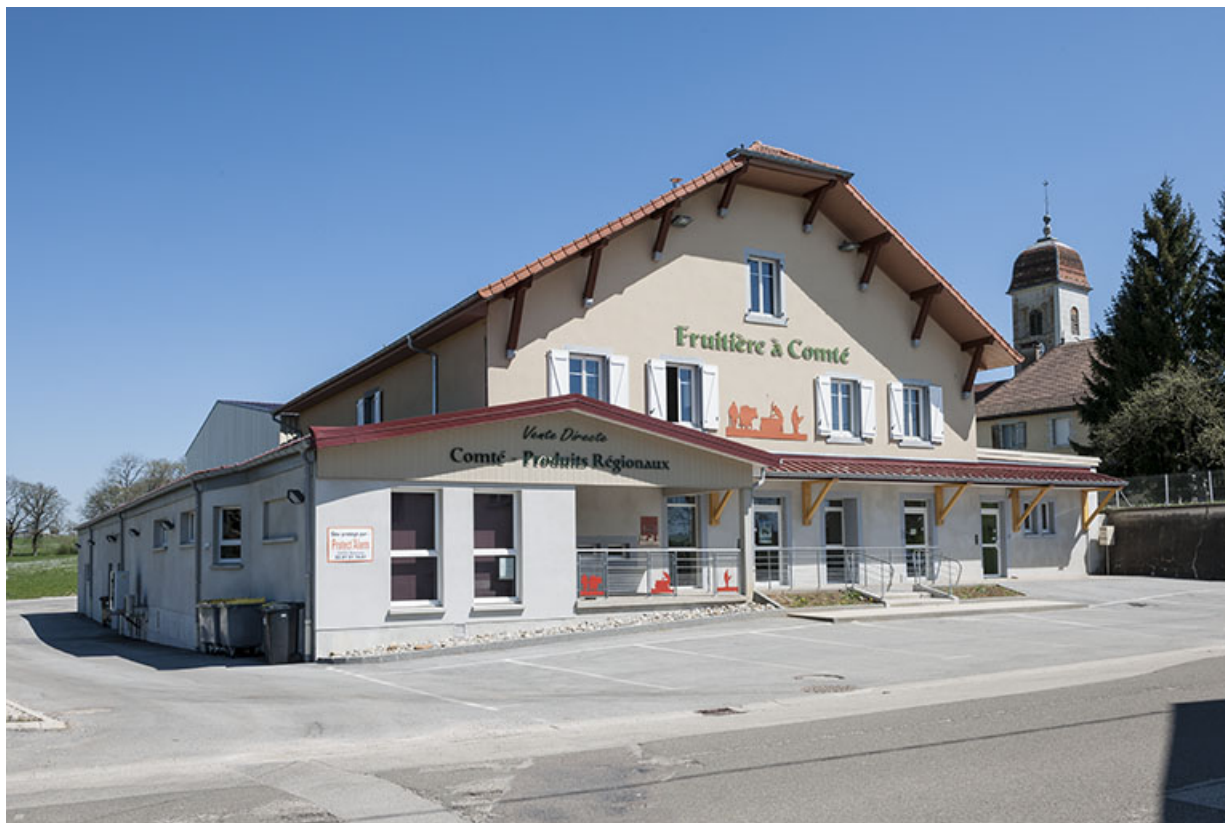
Vue de trois quarts gauche. 25, Étalans, 41 Grande Rue
