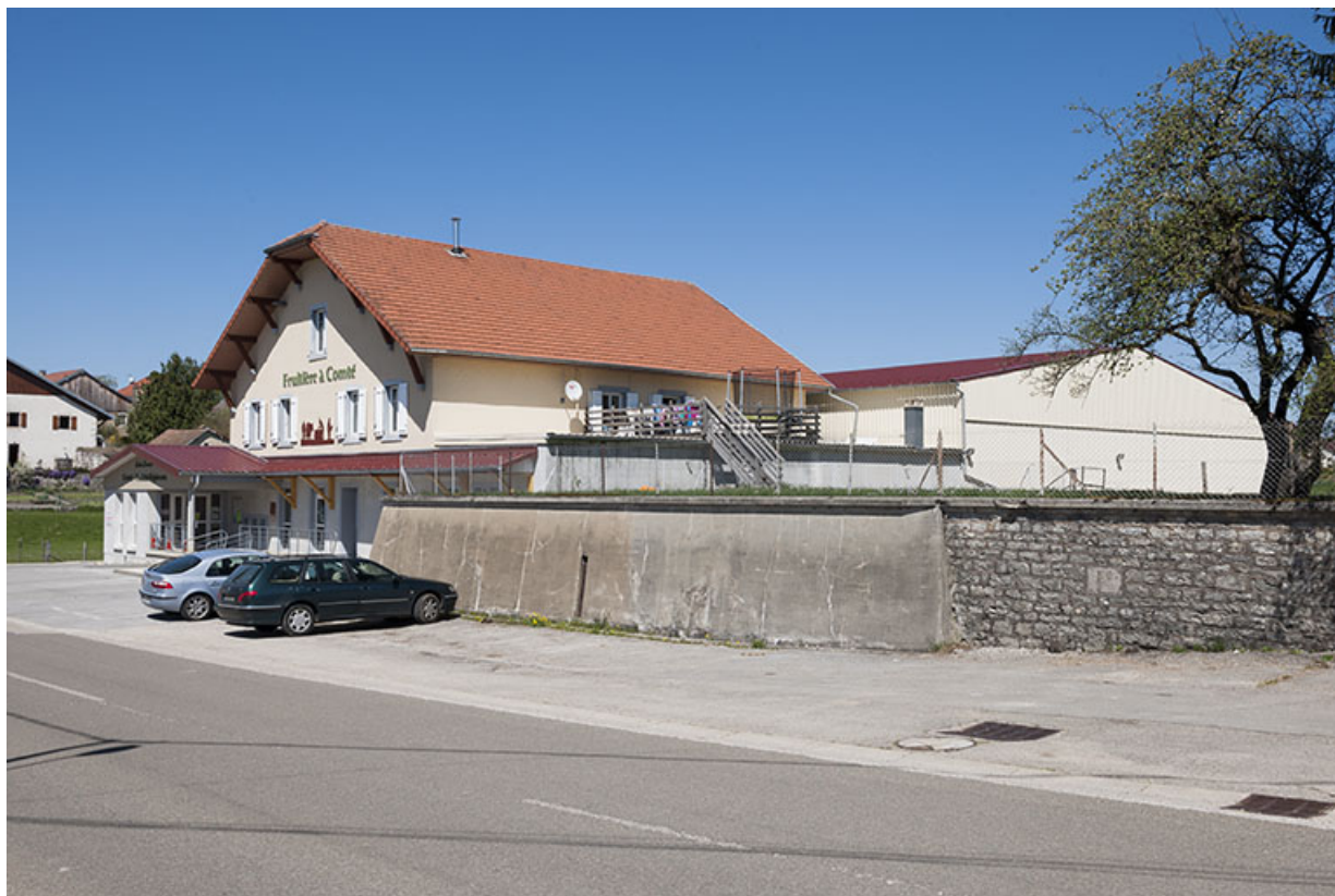
Vue d'ensemble depuis le sud.
