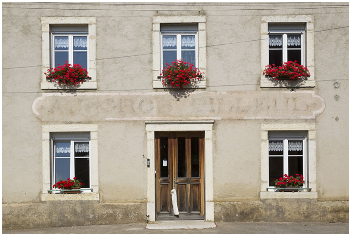
Façade antérieure : enseigne et baies des trois travées centrales.
