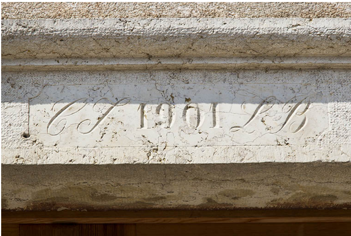
Façade antérieure : linteau daté.
