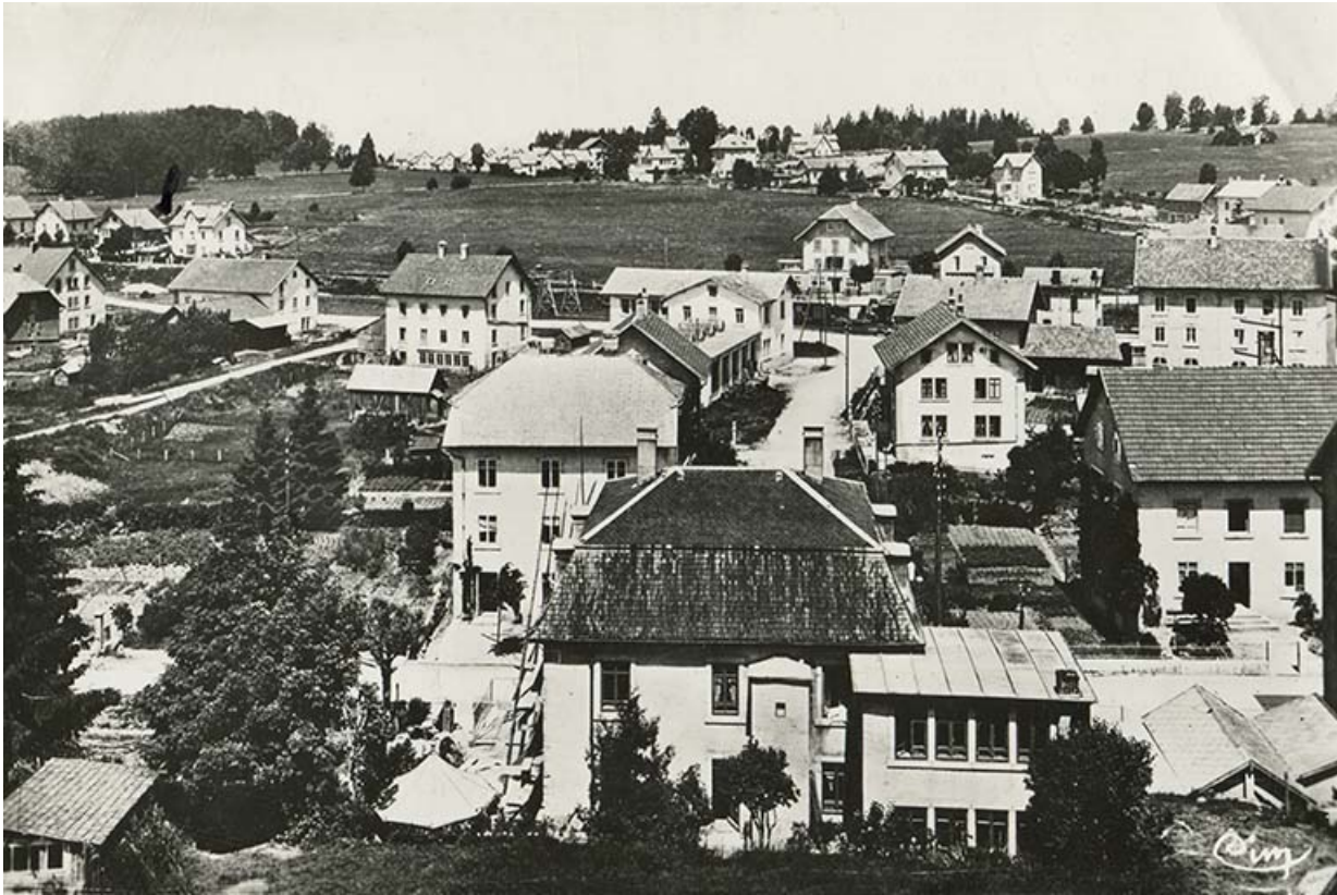
Charquemont (Doubs). Quartier de la Gare et les Cités [vus depuis l'arrière de l'usine Wasner], 2e quart 20e siècle 25, Charquemont, 13 rue de la Gare
