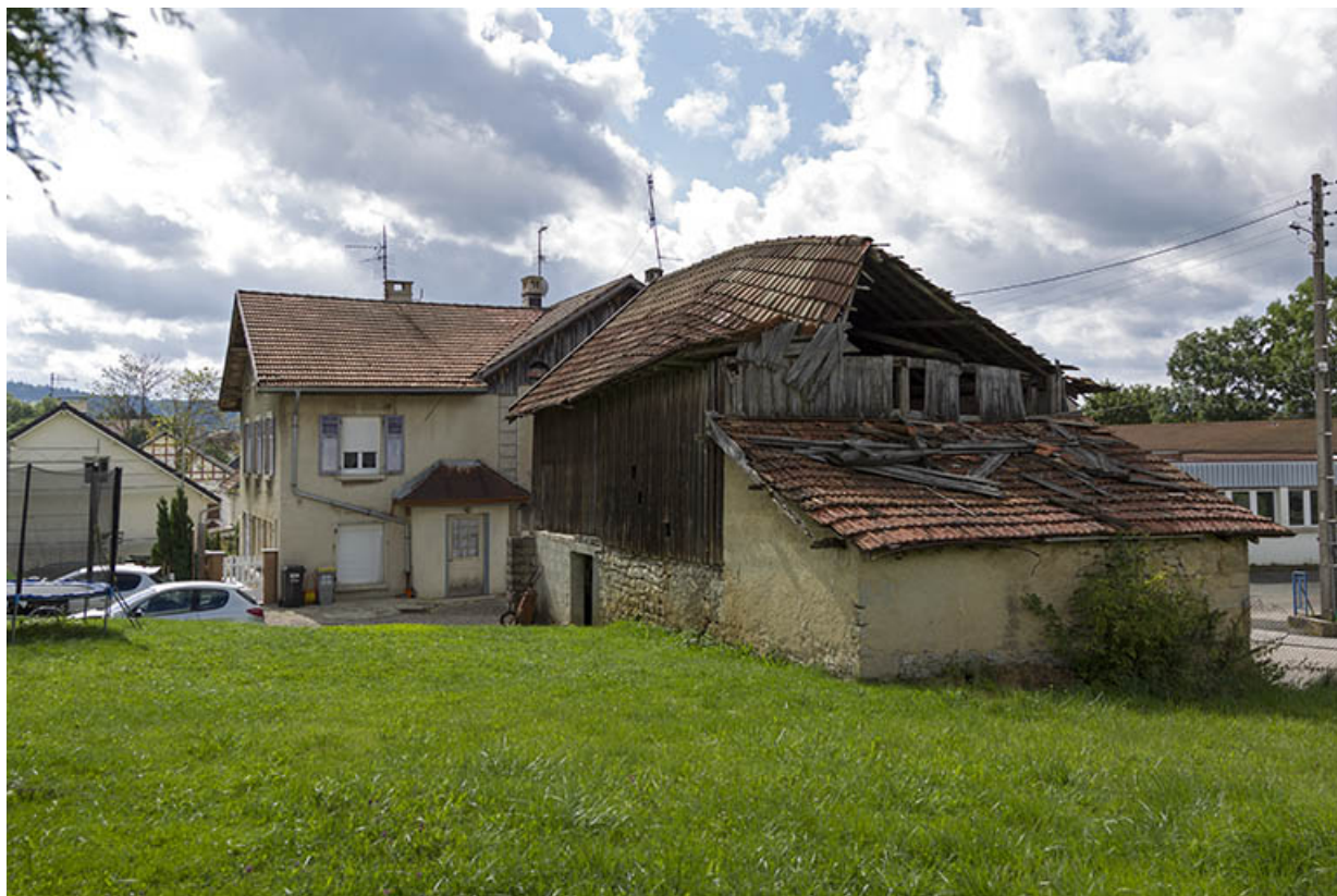
Remise et logement patronal (façade latérale gauche).
