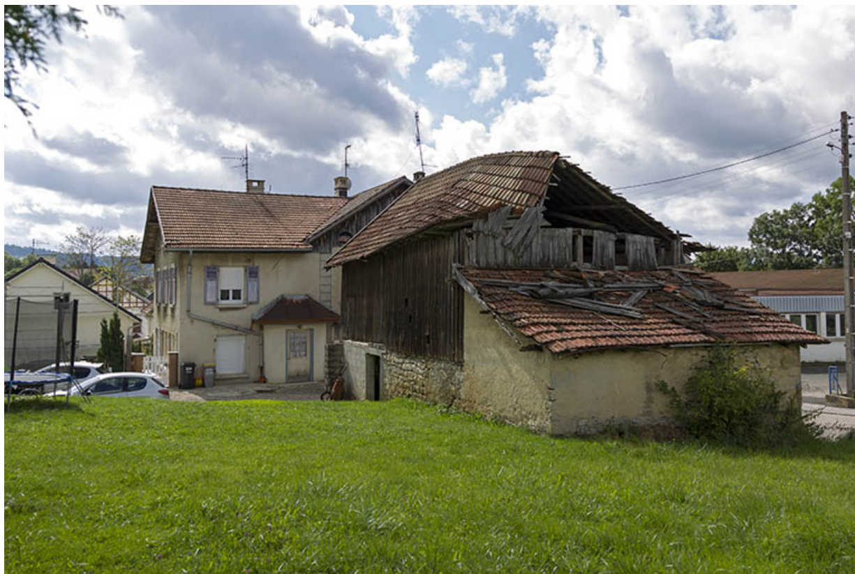
Remise et logement patronal (façade latérale gauche).
