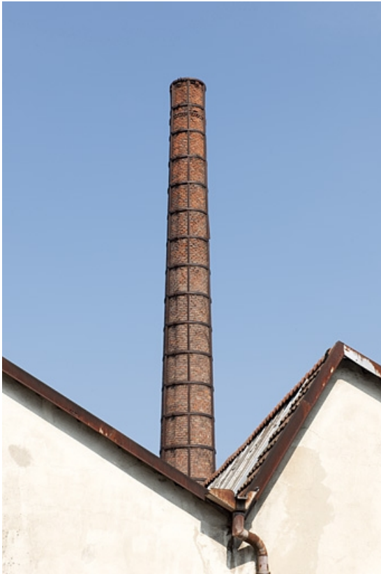
Sheds et cheminée de l'atelier de laitonnerie.
