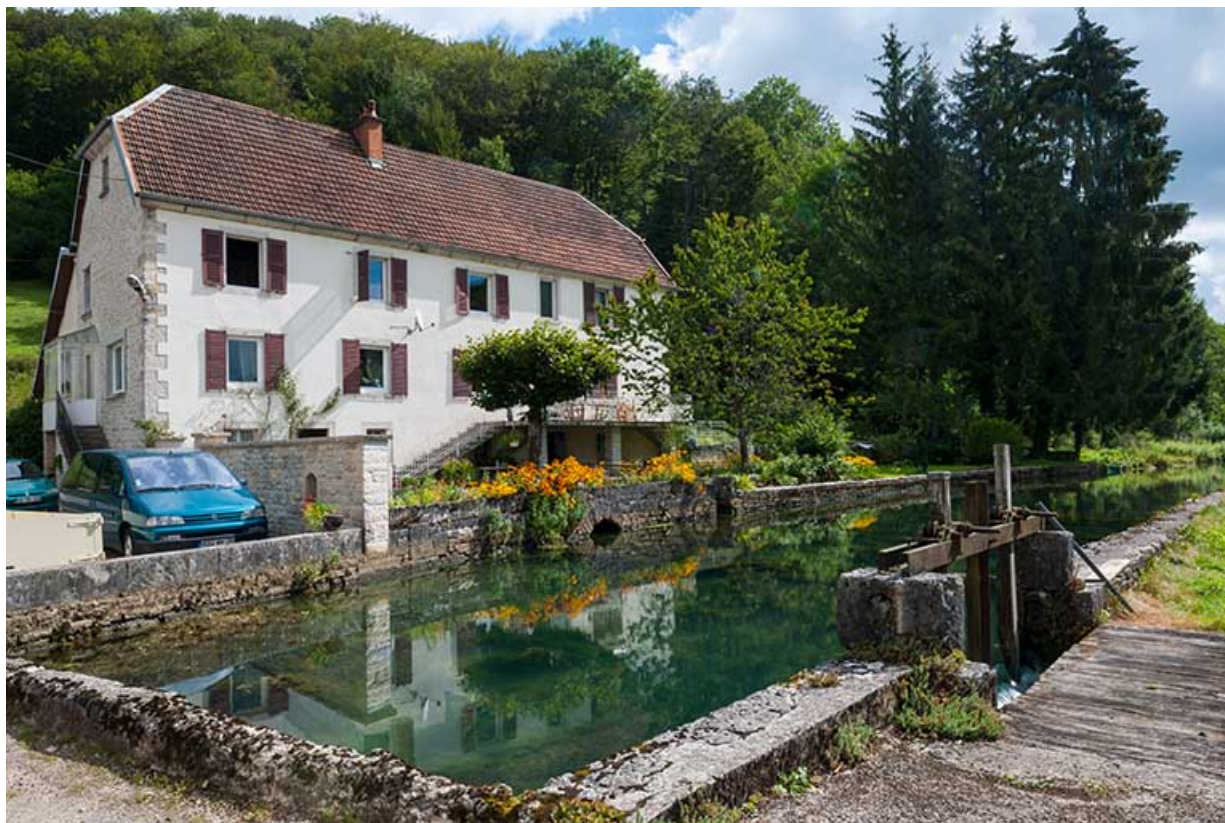
Le logement (moulin primitif) et le bief d'amenée.
