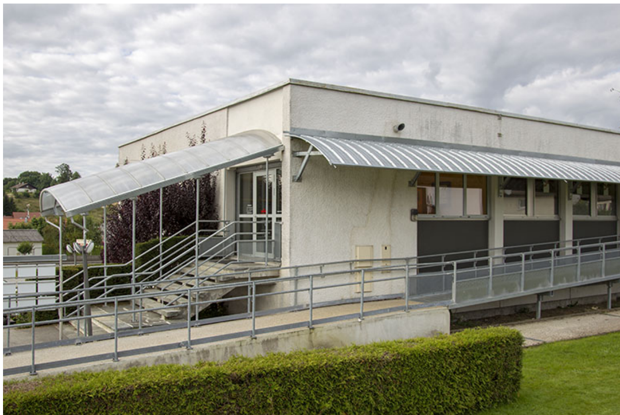
Façade latérale droite : escalier. A gauche la rampe d'accès récente. 25, Charquemont, 2 rue des Armaillis
