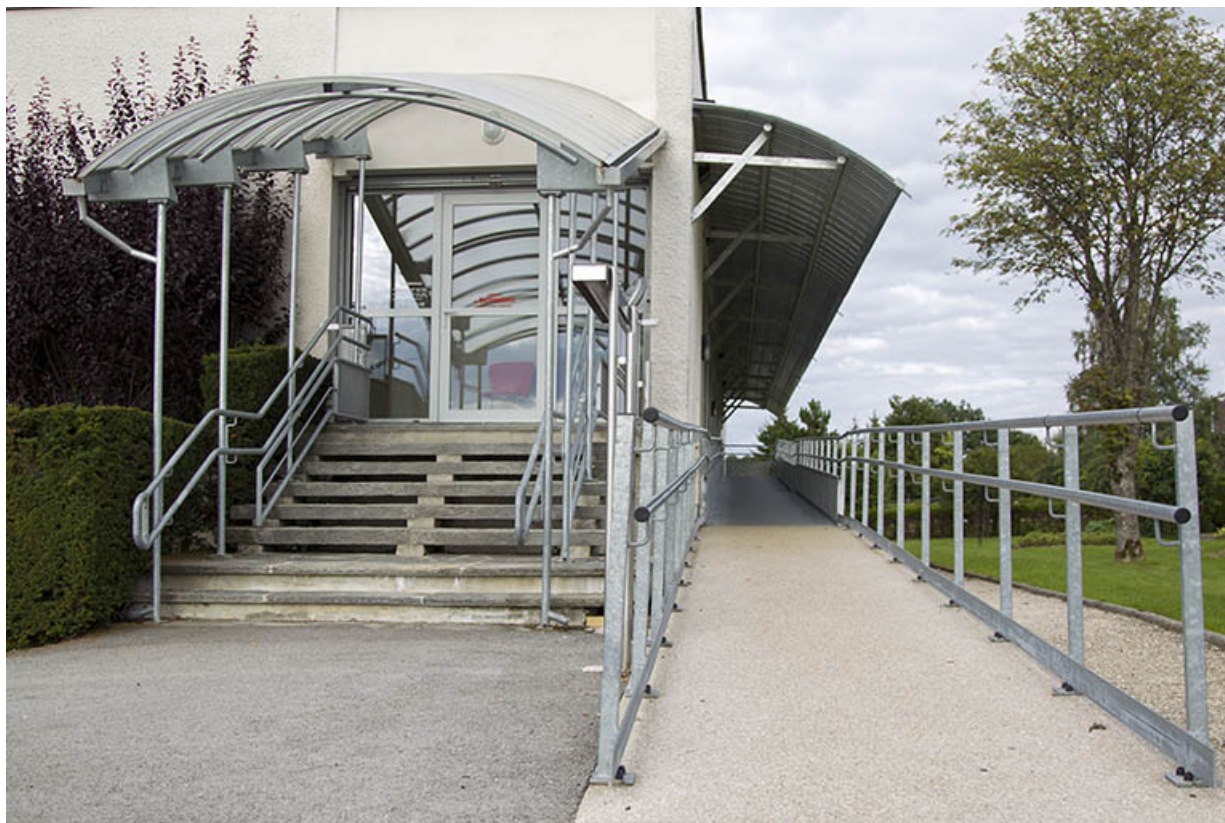
Façade latérale droite : escalier et rampe d'accès.
