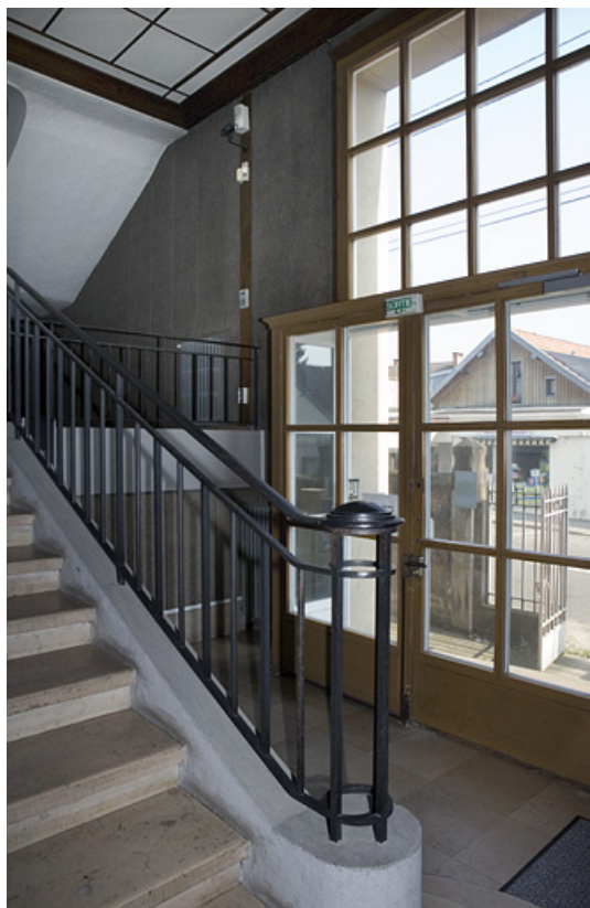
Corps d'entrée : hall et départ de la première volée de marches de l'escalier. 25, Besançon, 5 et 7 avenue de Montrapon
