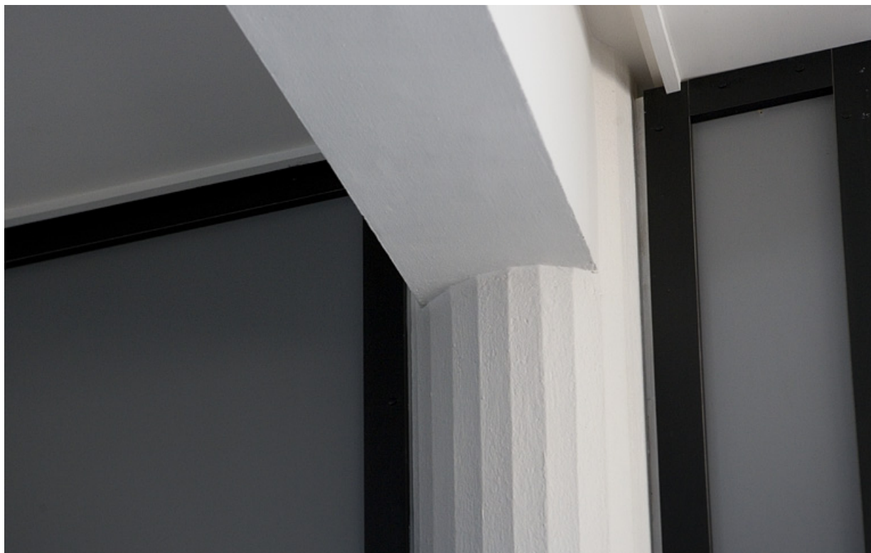
Deuxième étage : détail de la jonction d'un pilier et d'une poutre.
