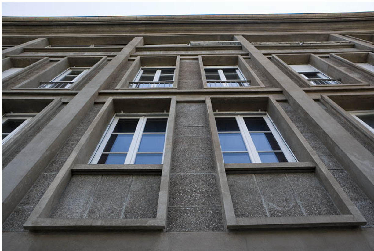
Face latérale droite : fenêtres vues en contre-plongée.
