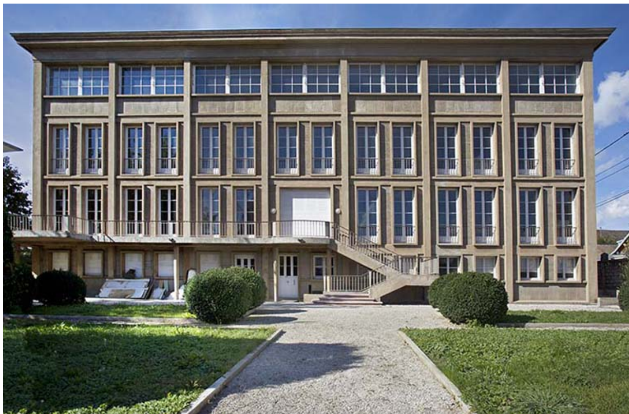
Face latérale gauche (vue rapprochée). 25, Besançon
