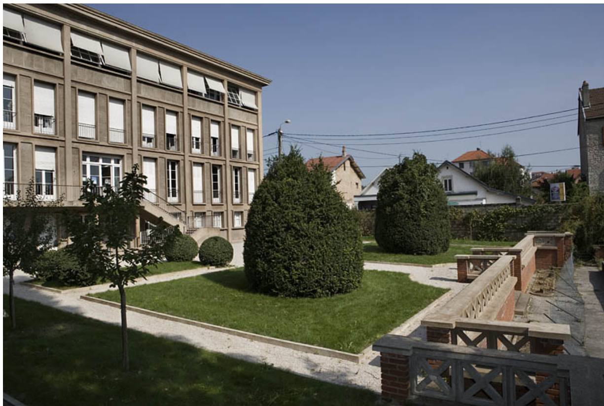
Jardin et face latérale gauche de l'usine. 25, Besançon, 5 et 7 avenue de Montrapon
