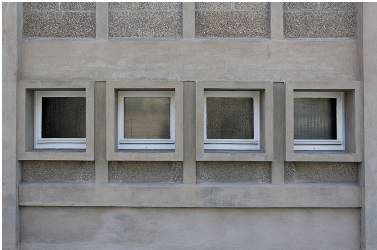
Corps d'entrée : fenêtres carrées sur la face latérale droite.
