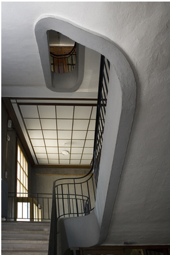
Corps d'entrée : vue d'ensemble du hall et de l'escalier, depuis la volée de marches inférieure. 25, Besançon, 5 et 7 avenue de Montrapon
