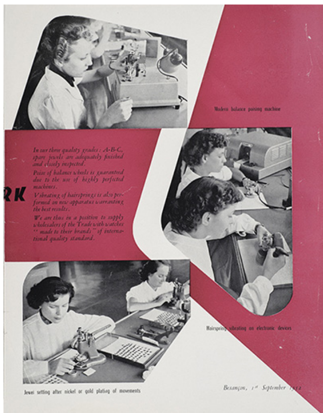
[Montage et contrôle des montres], 1952 25, Besançon, 5 et 7 avenue de Montrapon
