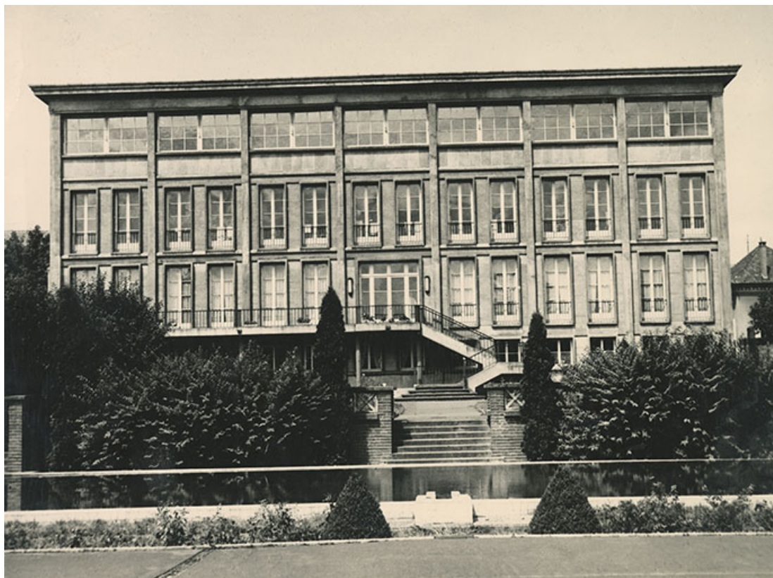
Façade sud, s.d. [années 1950].
