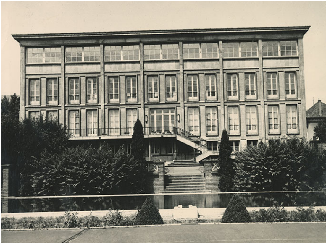
Façade sud, s.d. [années 1950].
