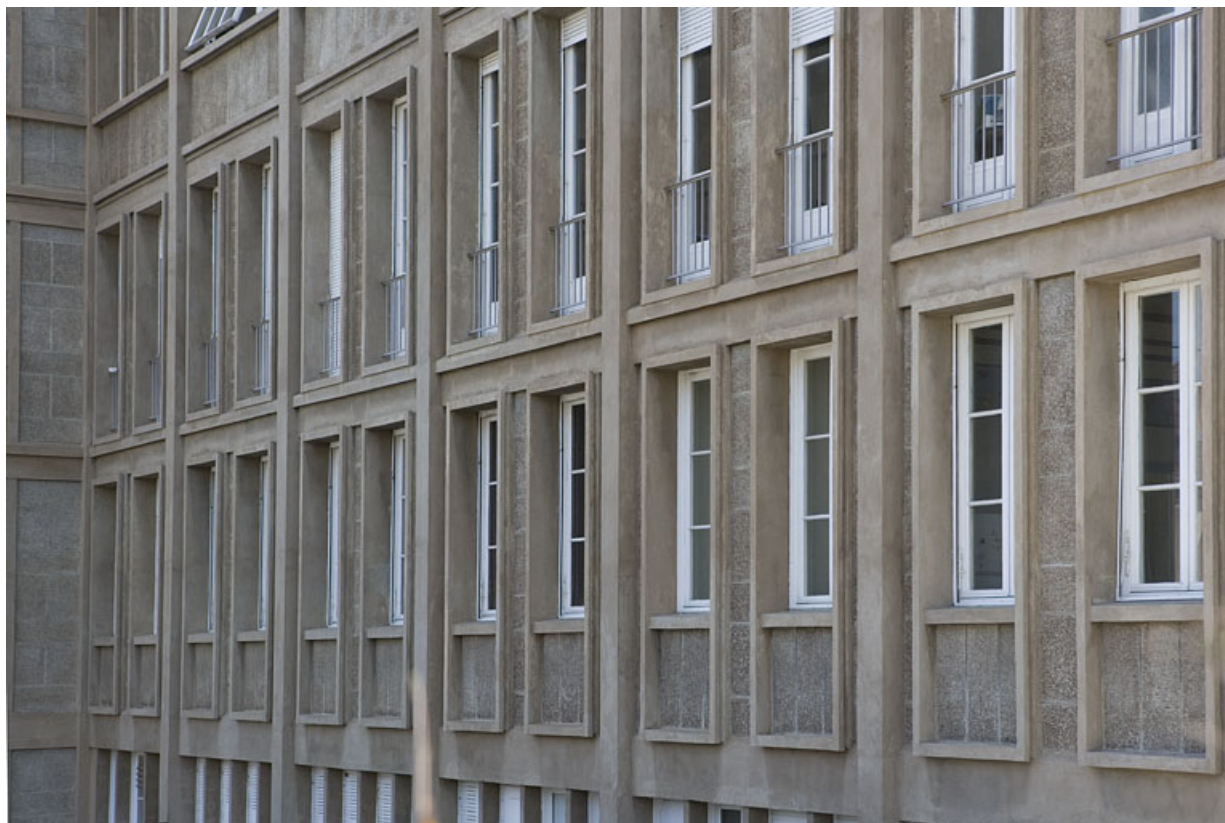
Face latérale droite : fenêtres vues en enfilade.
