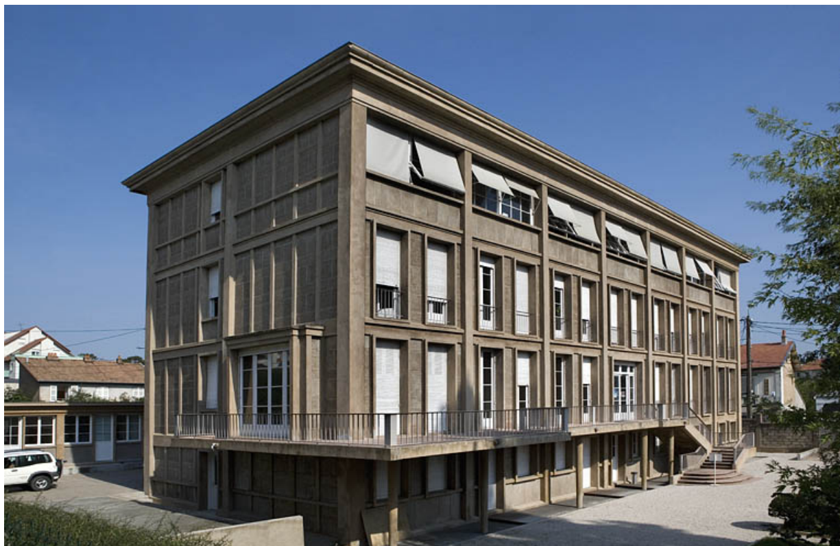
Façades postérieure et latérale gauche.
