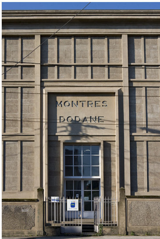
Corps d'entrée : travée centrale de la façade antérieure.
