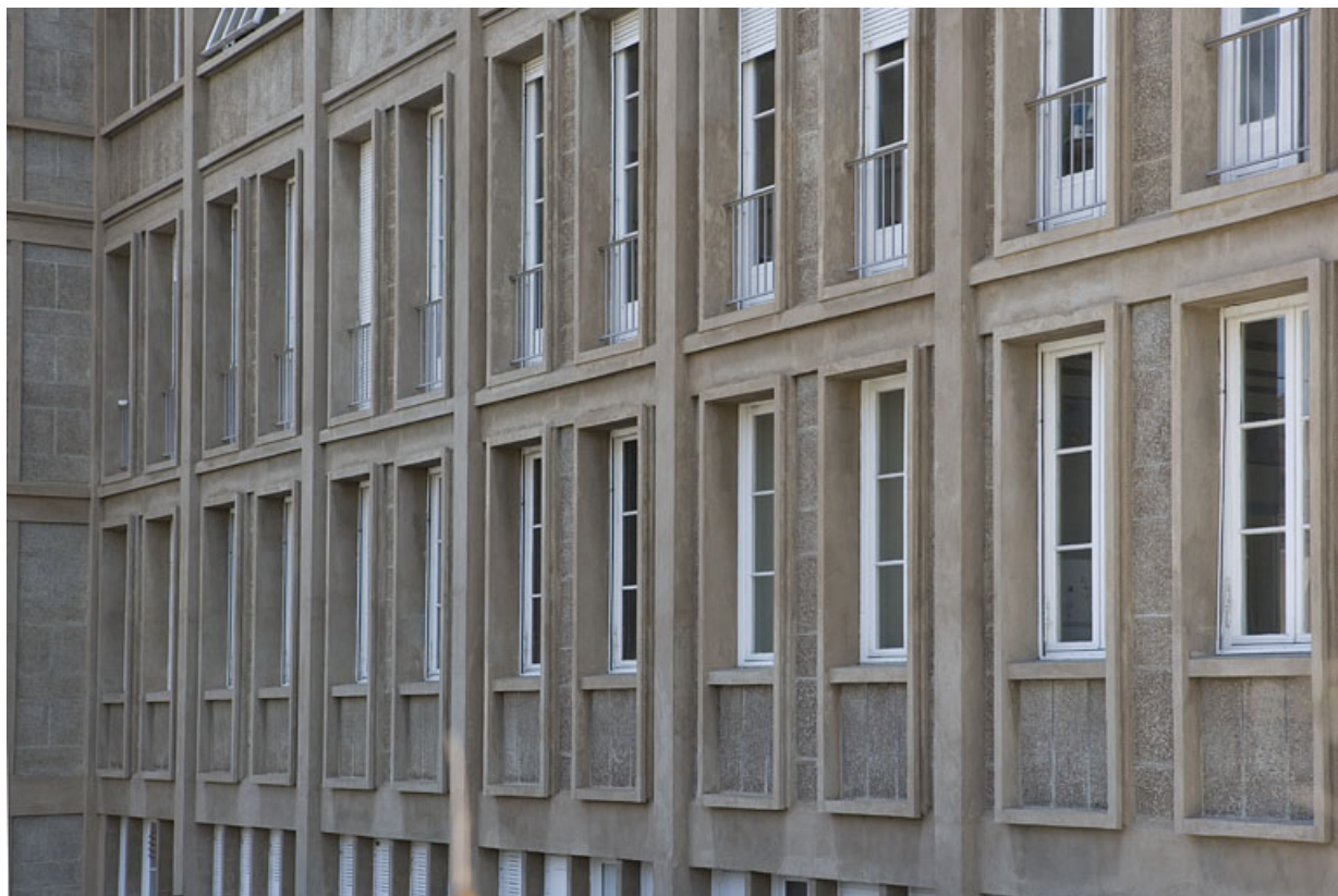
Face latérale droite : fenêtres vues en enfilade.
