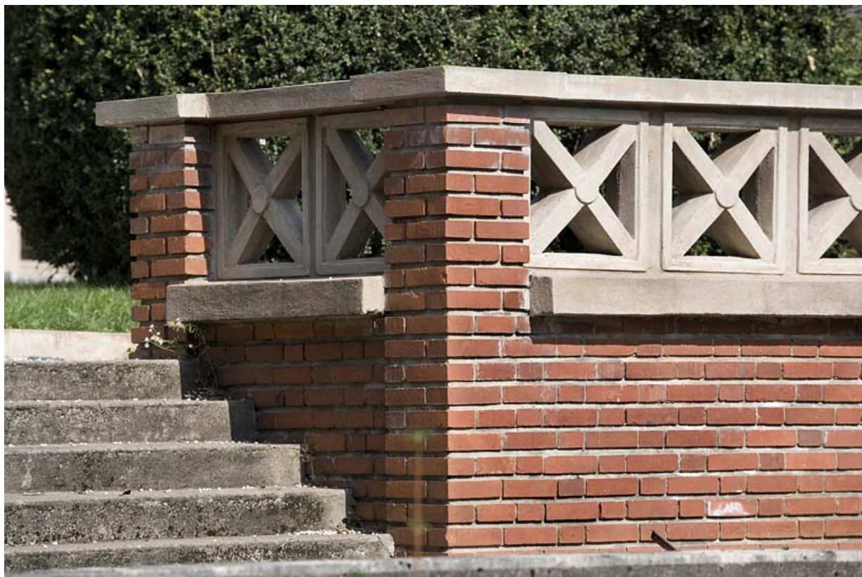
Jardin : détail du mur de soutènement et du garde-corps, côté piscine.
