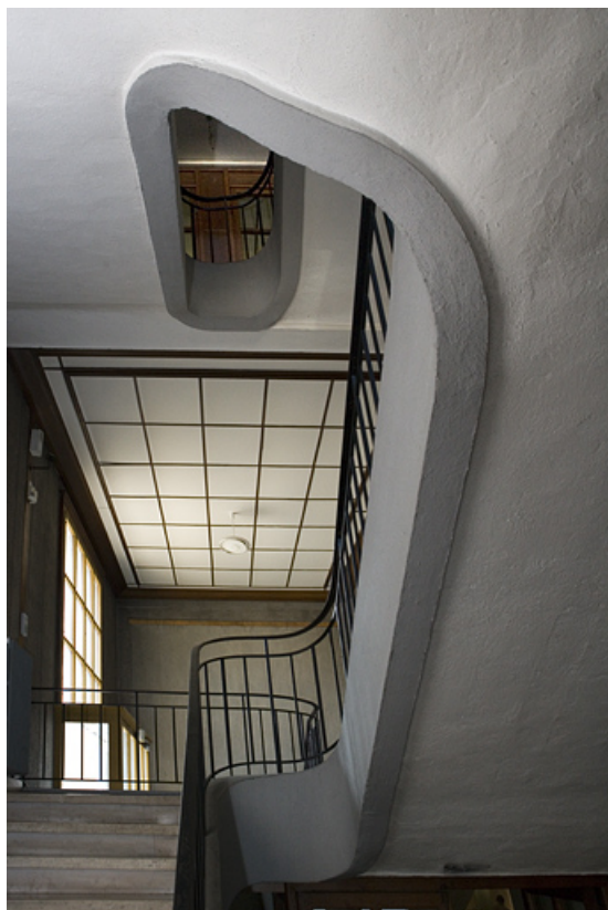
Corps d'entrée : vue d'ensemble du hall et de l'escalier, depuis la volée de marches inférieure. 25, Besançon, 5 et 7 avenue de Montrapon
