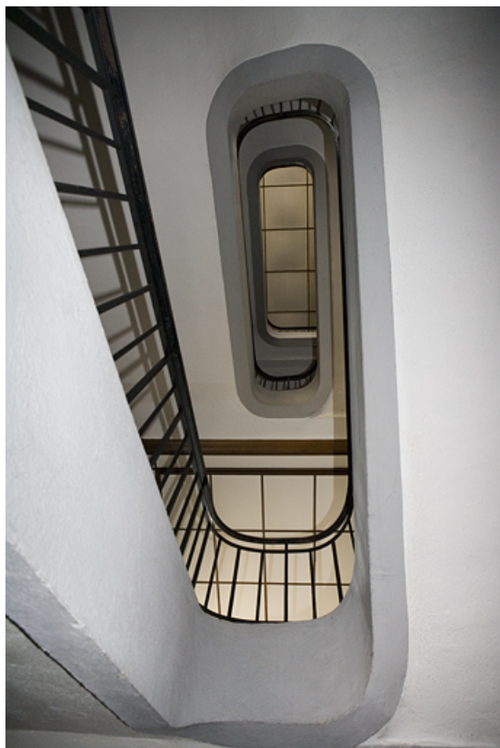
Corps d'entrée : escalier vu en contre-plongée.
