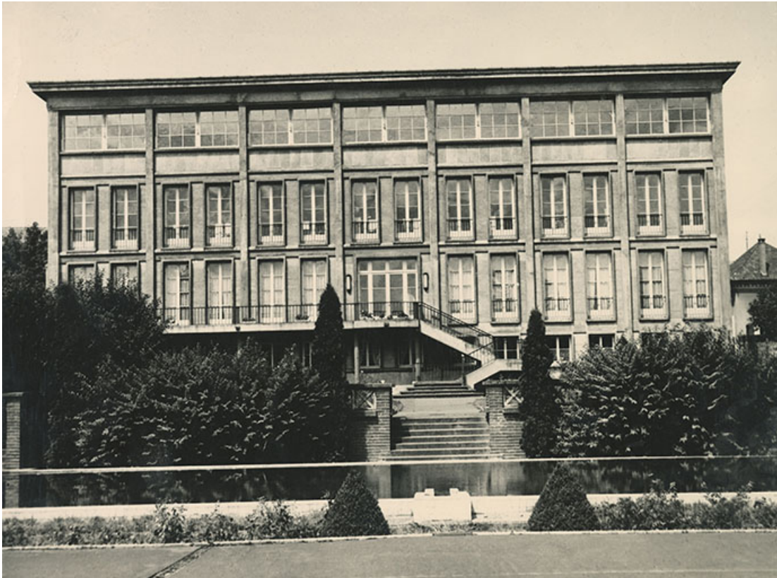
Façade sud, s.d. [années 1950].
