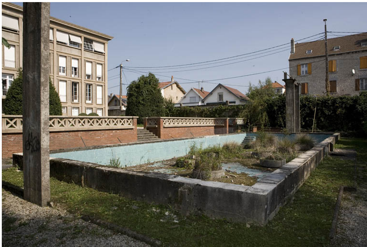
Piscine : vue de trois quarts.
