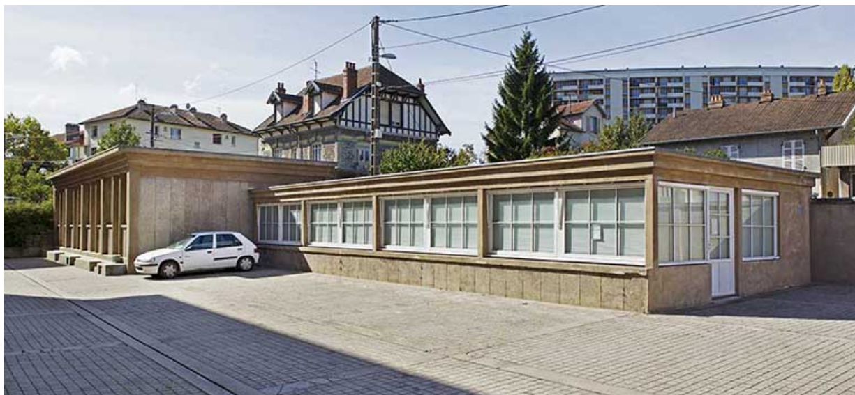
Garages : façades antérieure et latérale droite.
