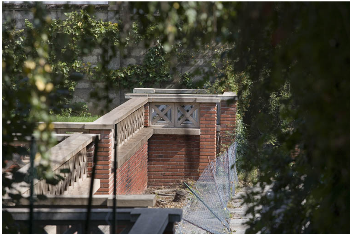
Jardin : mur de soutènement et garde-corps, vus en enfilade côté piscine.
