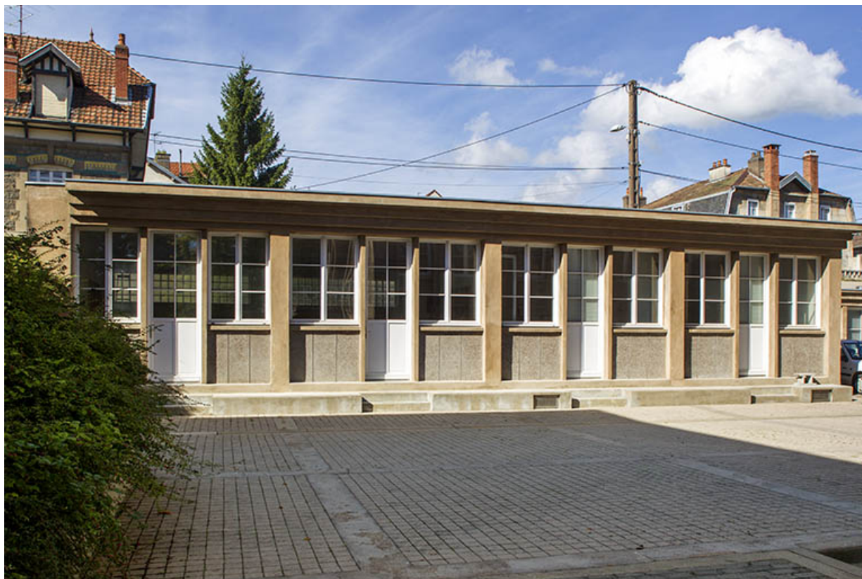
Garages : façade antérieure du corps de bâtiment au sud-ouest.
