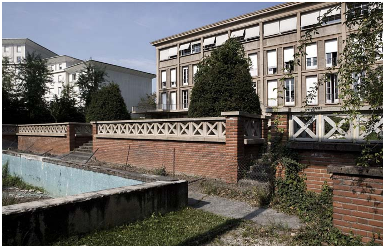
Jardin : mur de soutènement et garde-corps, depuis la piscine.
