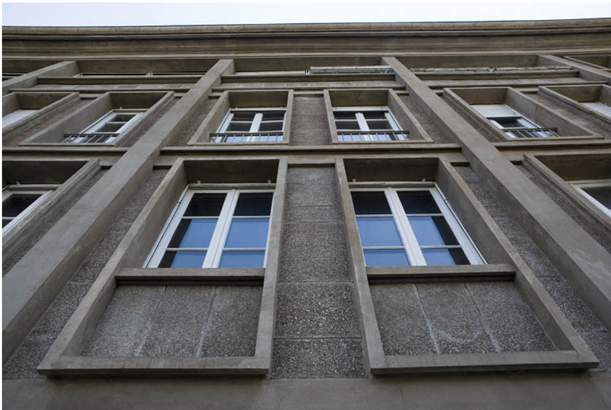
Face latérale droite : fenêtres vues en contre-plongée.
