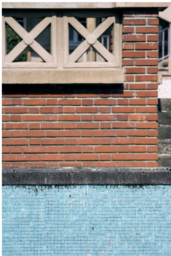
Jardin : détail du mur de soutènement et du garde-corps, côté piscine.
