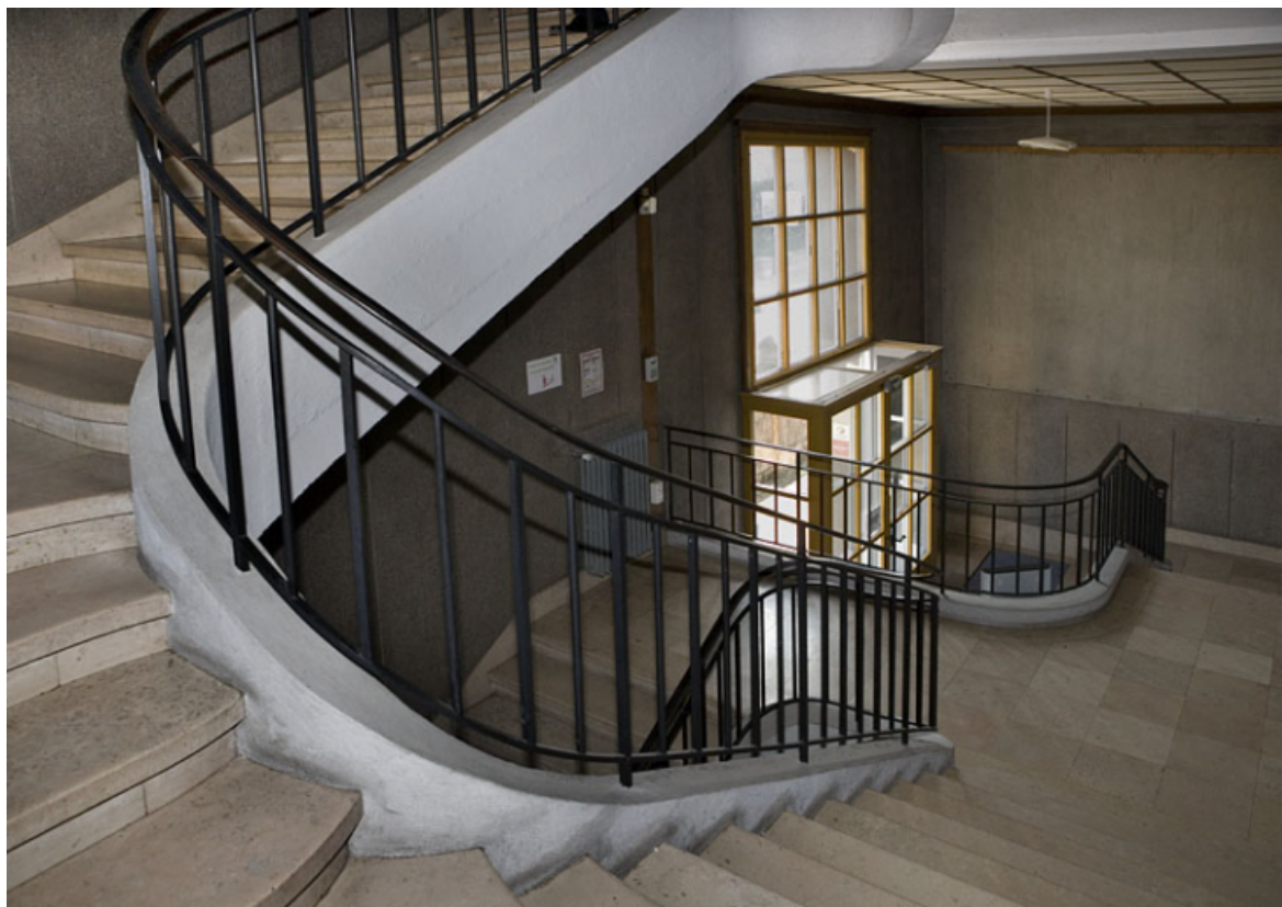
Corps d'entrée : vue d'ensemble du hall et de l'escalier, depuis la deuxième volée de marches. 25, Besançon, 5 et 7 avenue de Montrapon
