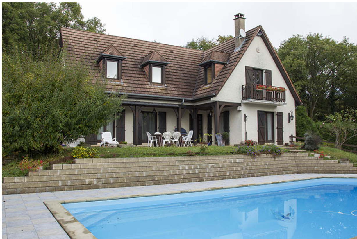
Vue d'ensemble, de trois quarts gauche. 25, Châillon-le-Duc, 2 chemin des Barbizets
