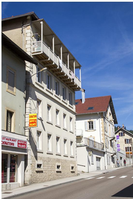
Usine : façade antérieure, vue en enfilade.
