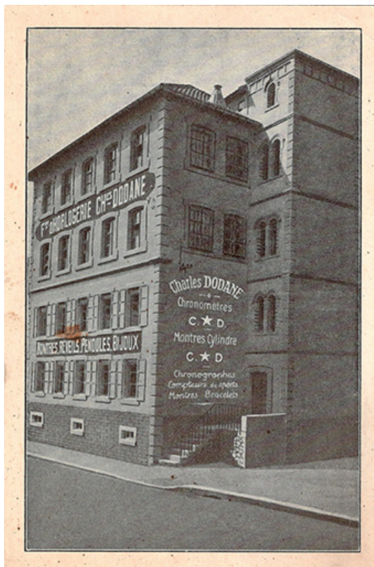
[Façade antérieure de l'usine, de trois quarts droite], années 1920. 25, Morteau, 15 rue de la Louhière
