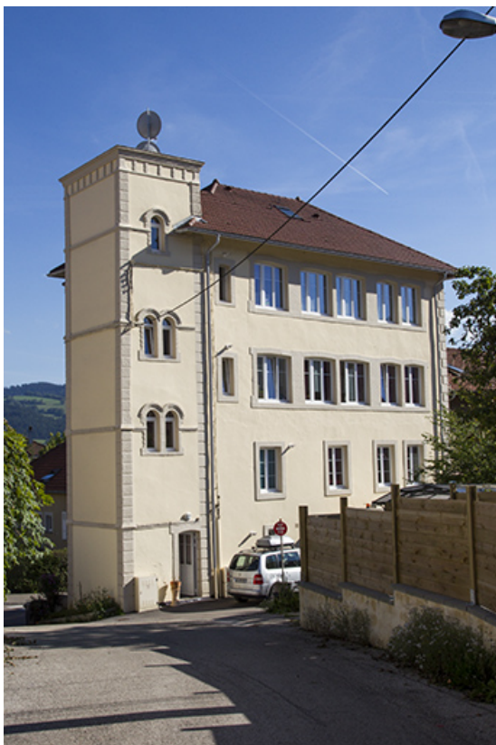
Usine : façade postérieure, de trois quarts gauche. 25, Morteau, 15 rue de la Louhière
