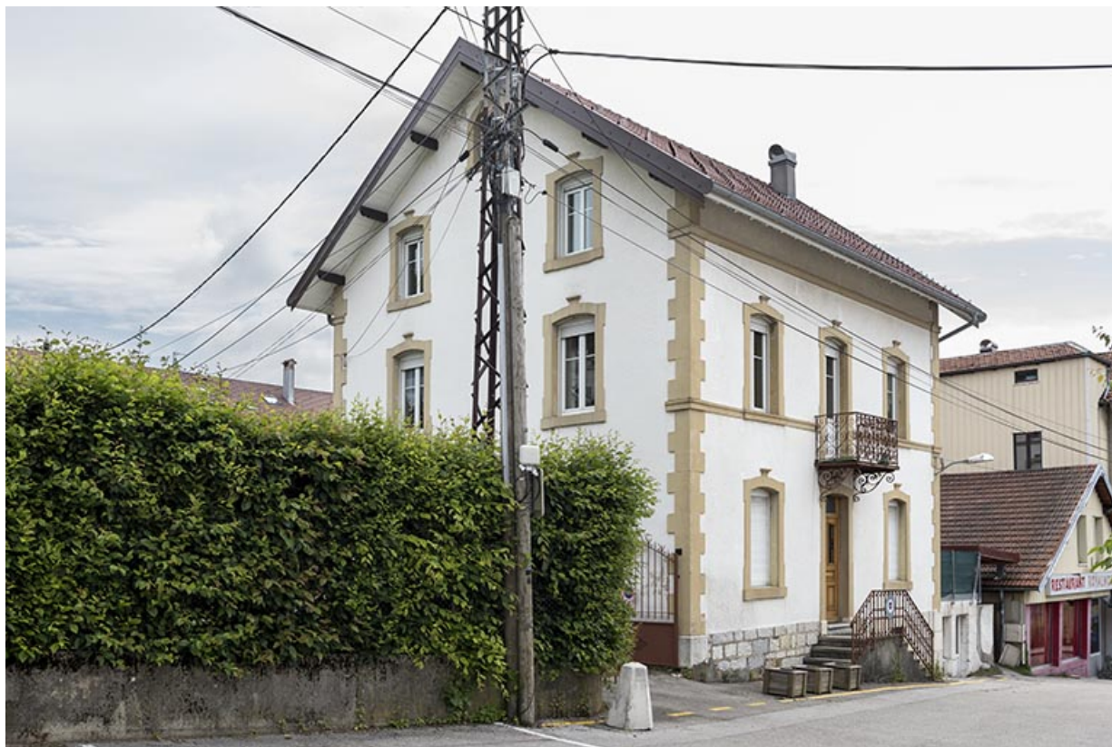
Maison chemin des Acacias : façades antérieure et latérale gauche. 25, Morteau, 15 rue de la Louhière
