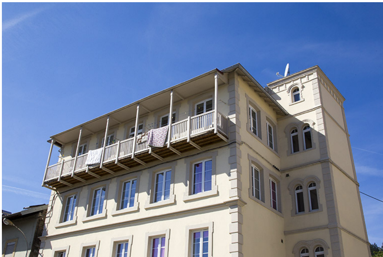
Usine, façade antérieure : étages et balcon.
