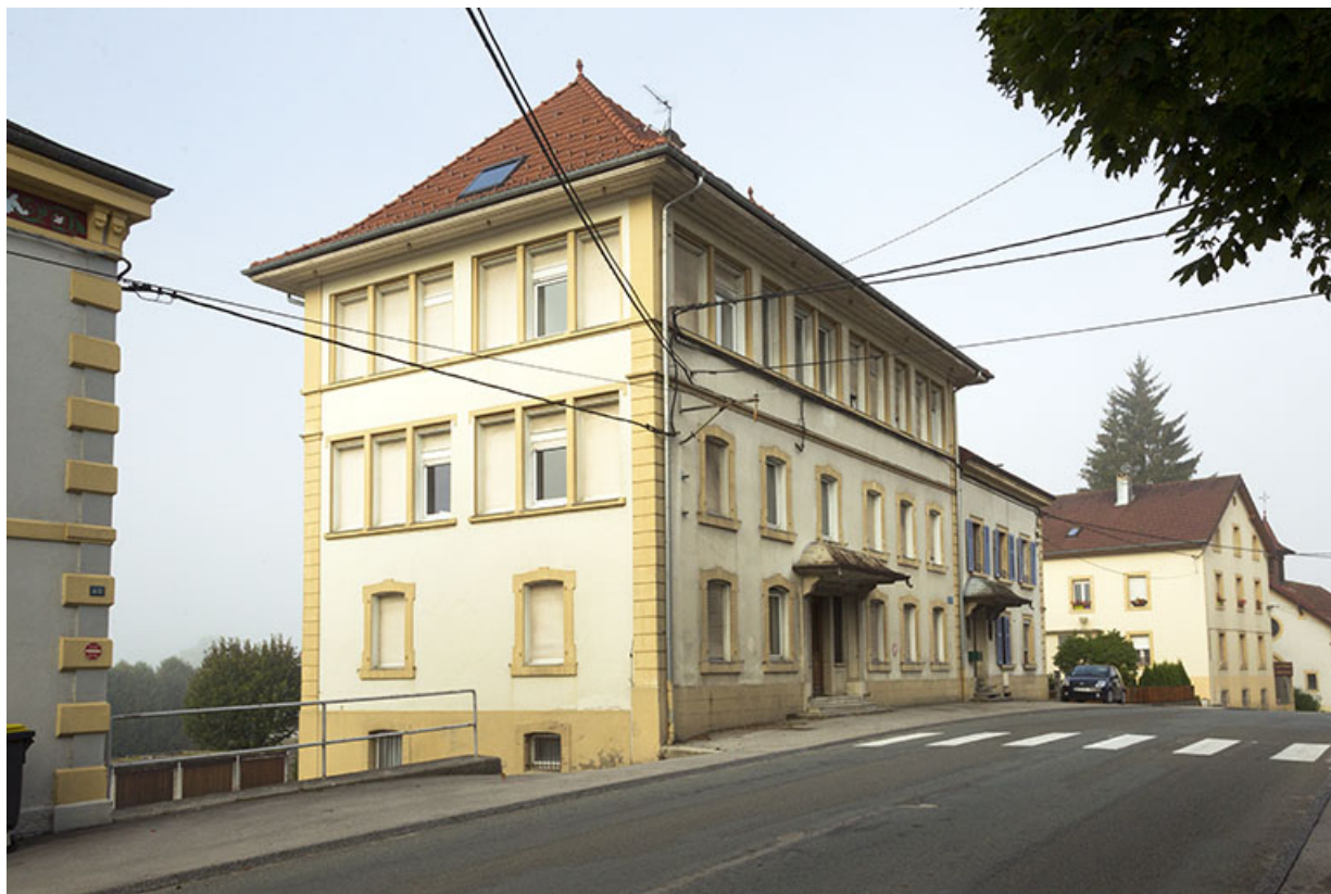
Vue d'ensemble depuis l'est (façade antérieure).
