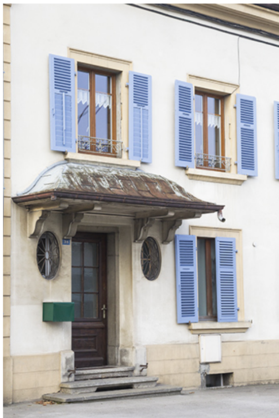
Façade antérieure : entrée du logement patronal.
