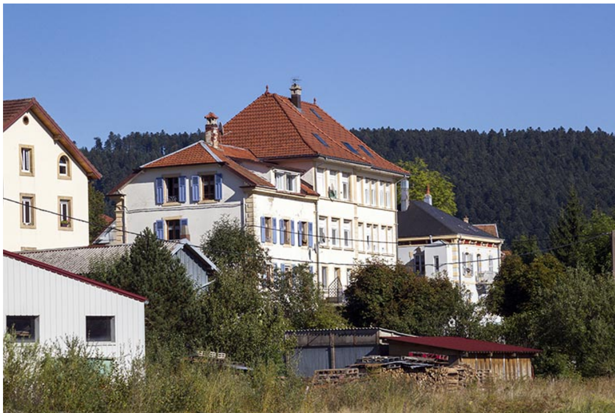
Vue d'ensemble depuis l'ouest (façade postérieure).
