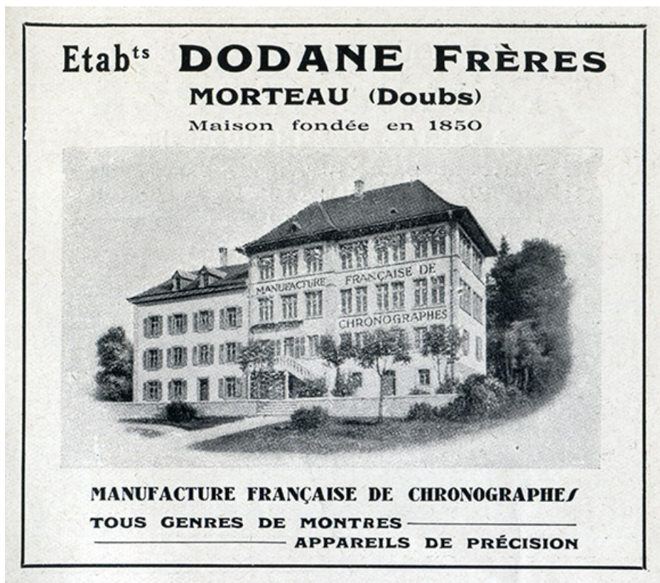
Etab[lissem]ts Dodane Frères. Morteau (Doubs) [façade postérieure de la maison et de l'usine], 1943. 25, Morteau, 36 et 38 rue de l' Helvétie
