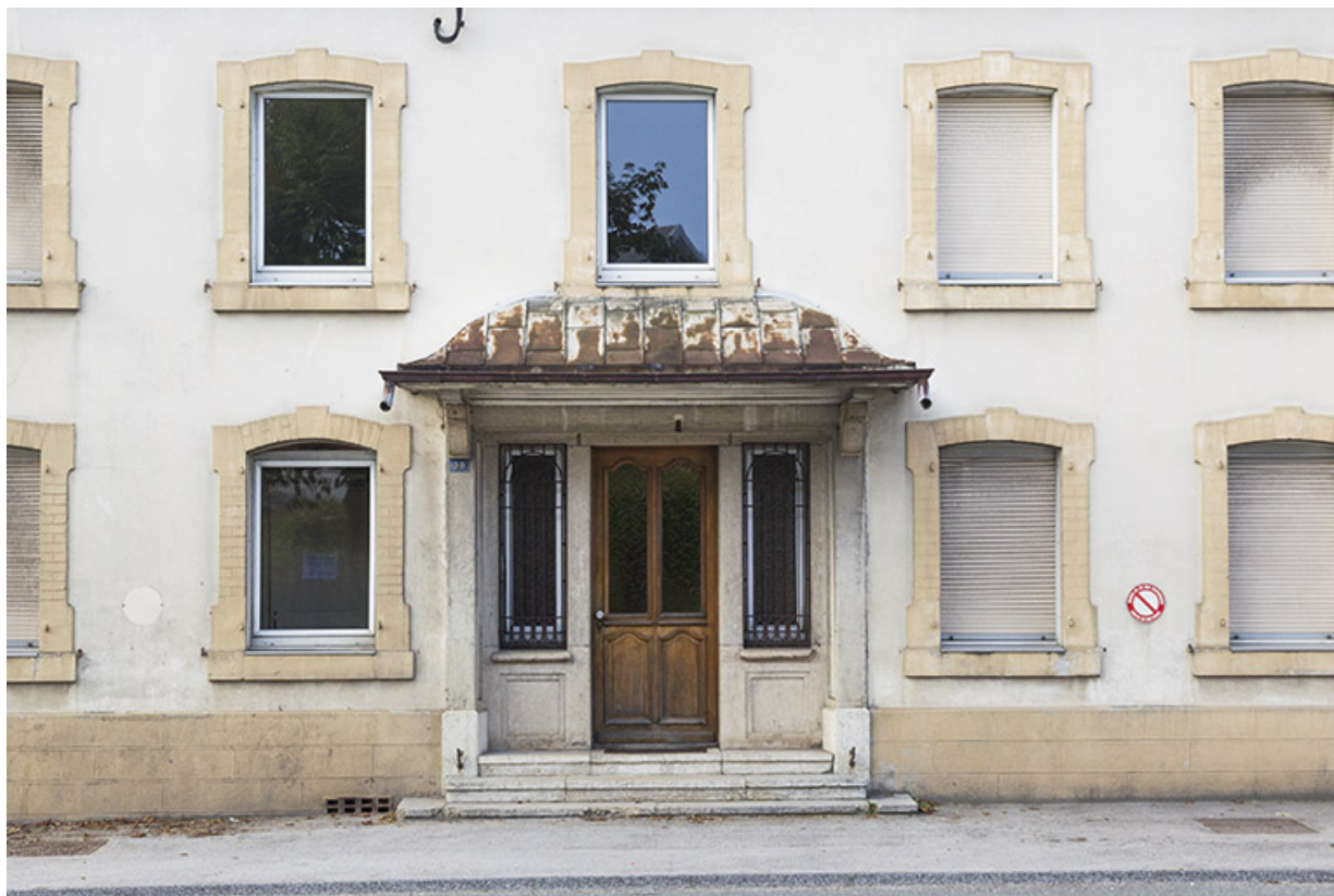
Façade antérieure : entrée de l'atelier de fabrication.
