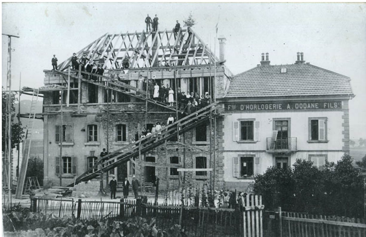
[Construction de l'usine d'Alphonse Dodane, rue de l'Helvétie], années 1920 ? 25, Morteau
