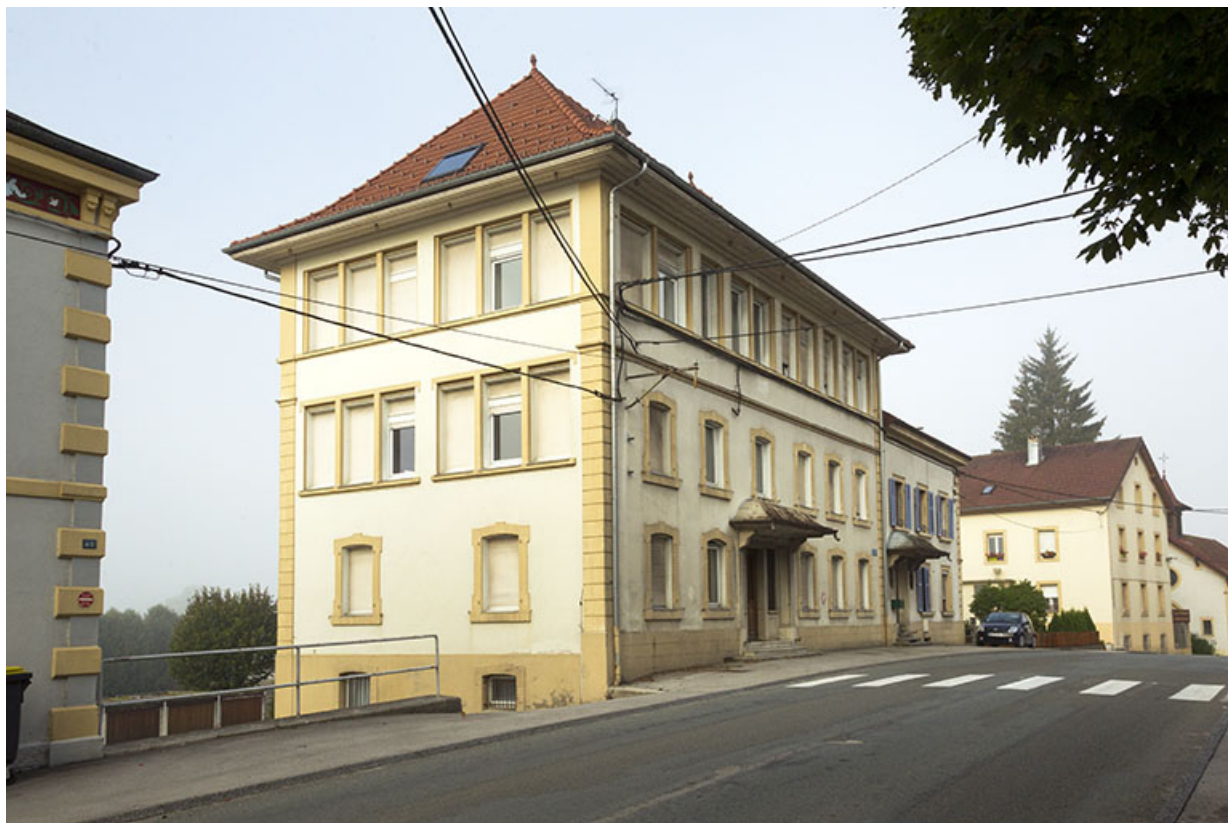
Vue d'ensemble depuis l'est (façade antérieure).
