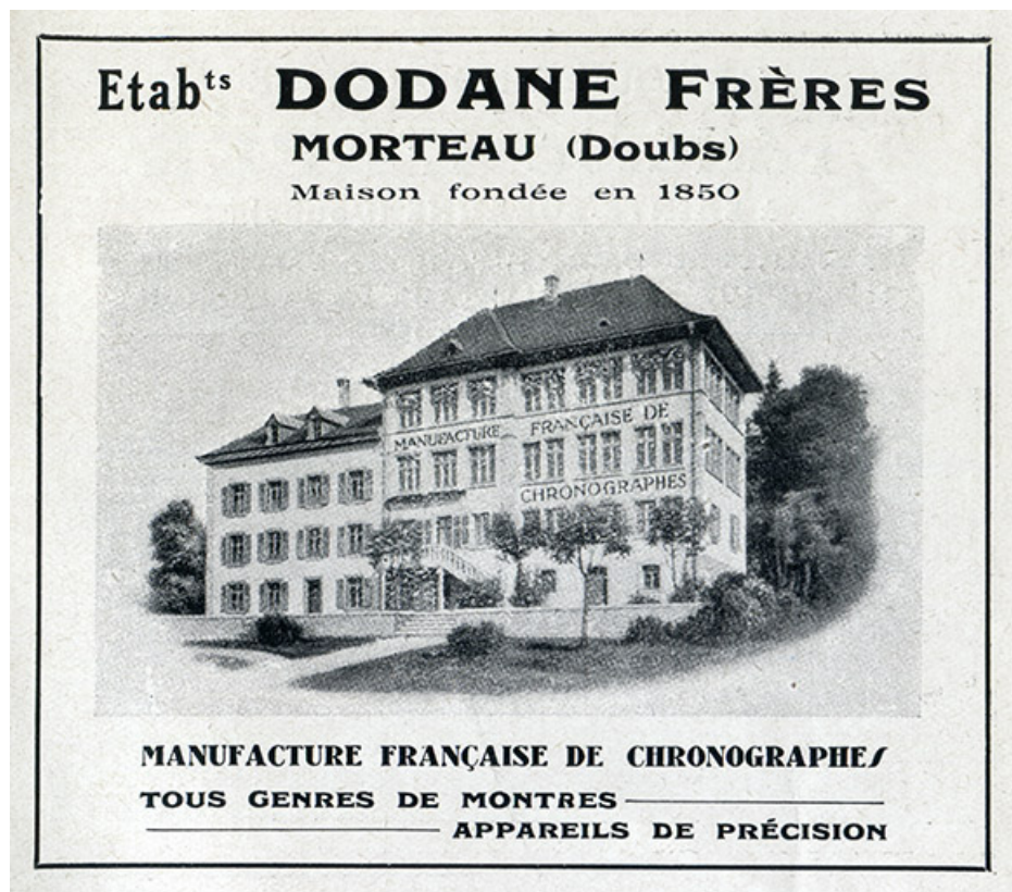
Etab[lissemen]ts Dodane Frères. Morteau (Doubs) [façade postérieure de la maison et de l'usine], 1943. 25, Morteau, 36 et 38 rue de l' Helvétie
