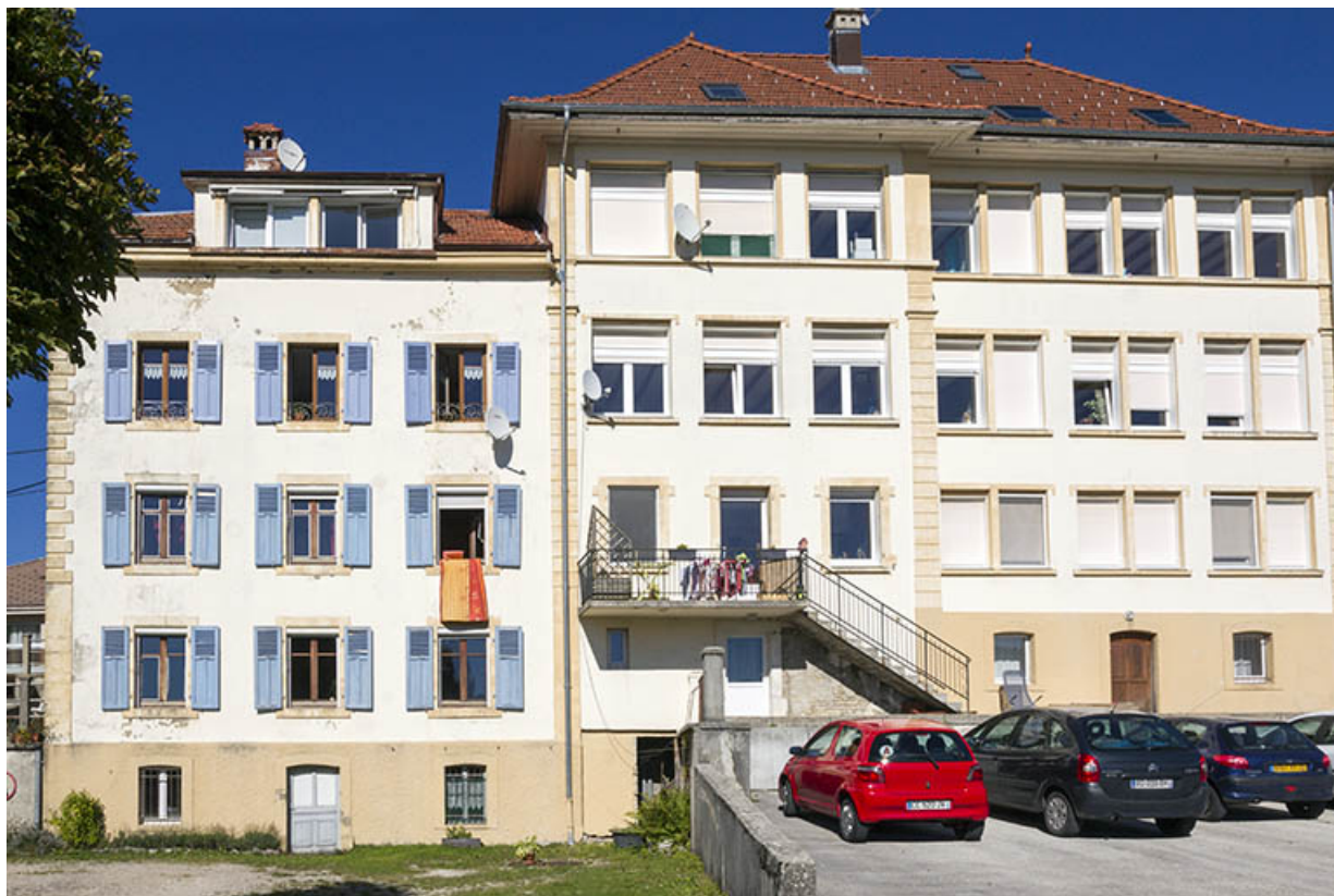
Maison et usine d'horlogerie Alphonse Dodane Fils puis Dodane Frères, 36-38 rue de l'Helvétie : façade postérieure. 25, Morteau
