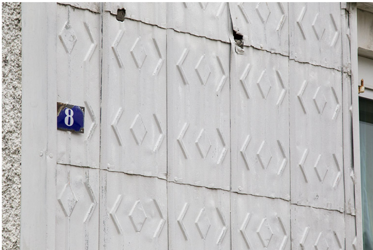
Façade latérale gauche : détail de l'essentage de tôle.
