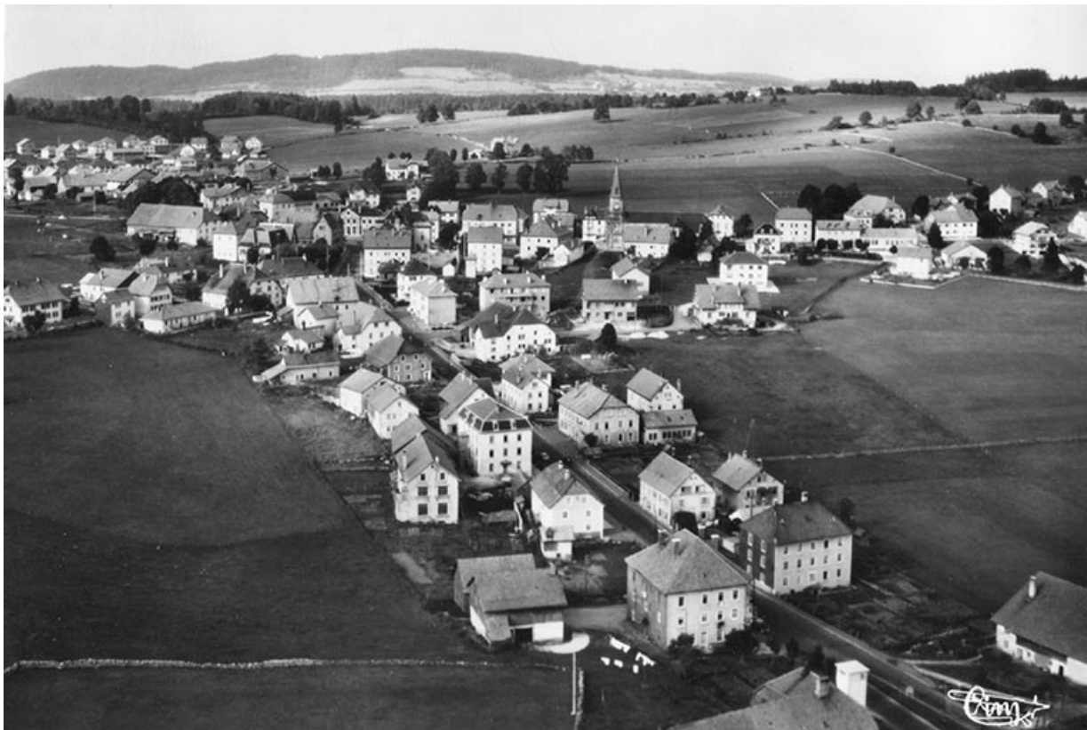
Charquemont (Doubs). 210-1 A. Vue générale [la Grande Rue et le bas du village vus du sud], 3e quart 20e siècle. 25, Charquemont, 8 rue du Chalet
