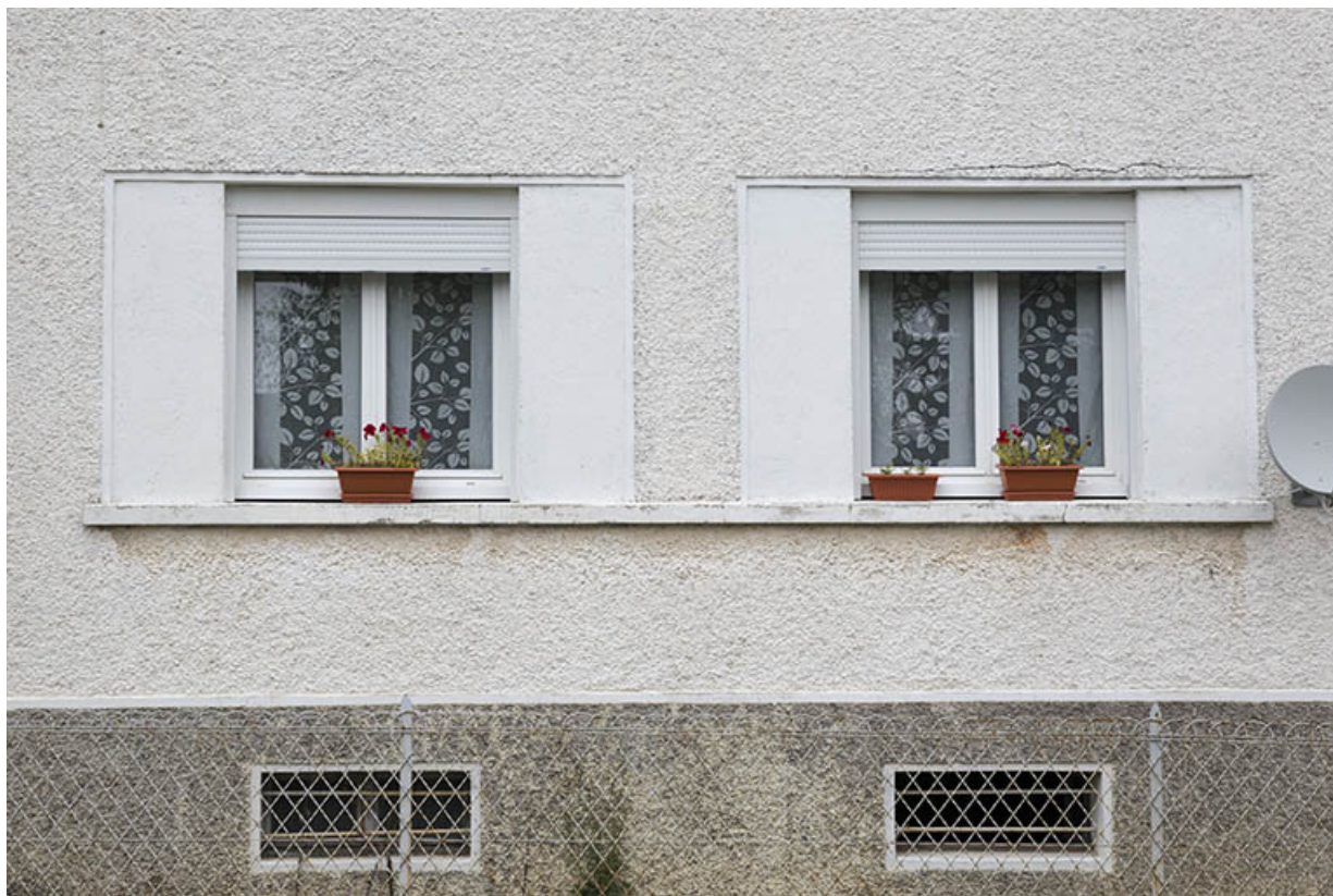
Des fenêtres d'atelier (partiellement murées) : usine d'horlogerie Numa Monnin puis Georges Monnin et Cie (8 rue de l'Eglise), 25, Charquemont
