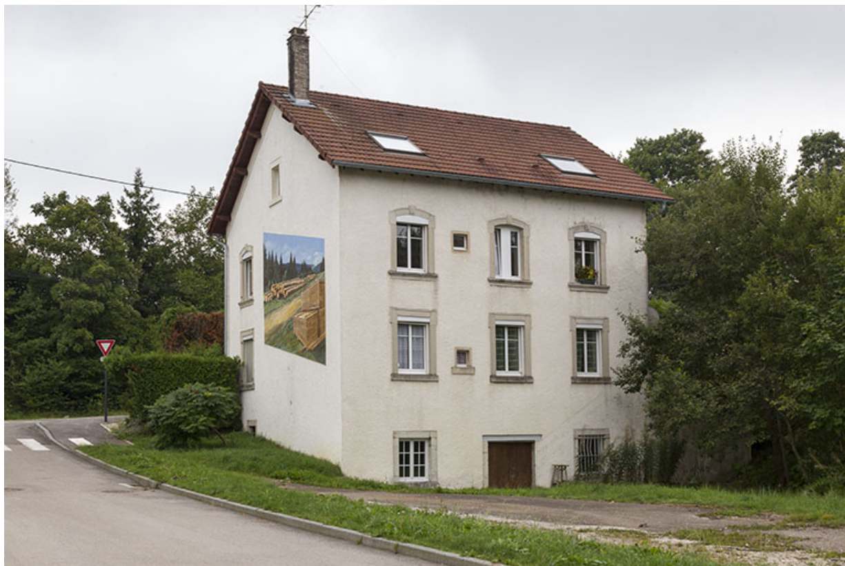
Logement patronal : façades postérieure et latérale droite.
