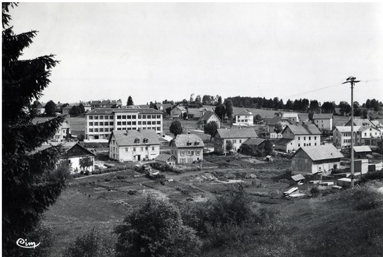
Charquemont (Doubs). Quartier de la Gare et les Cités, entre 1951 et 1958
