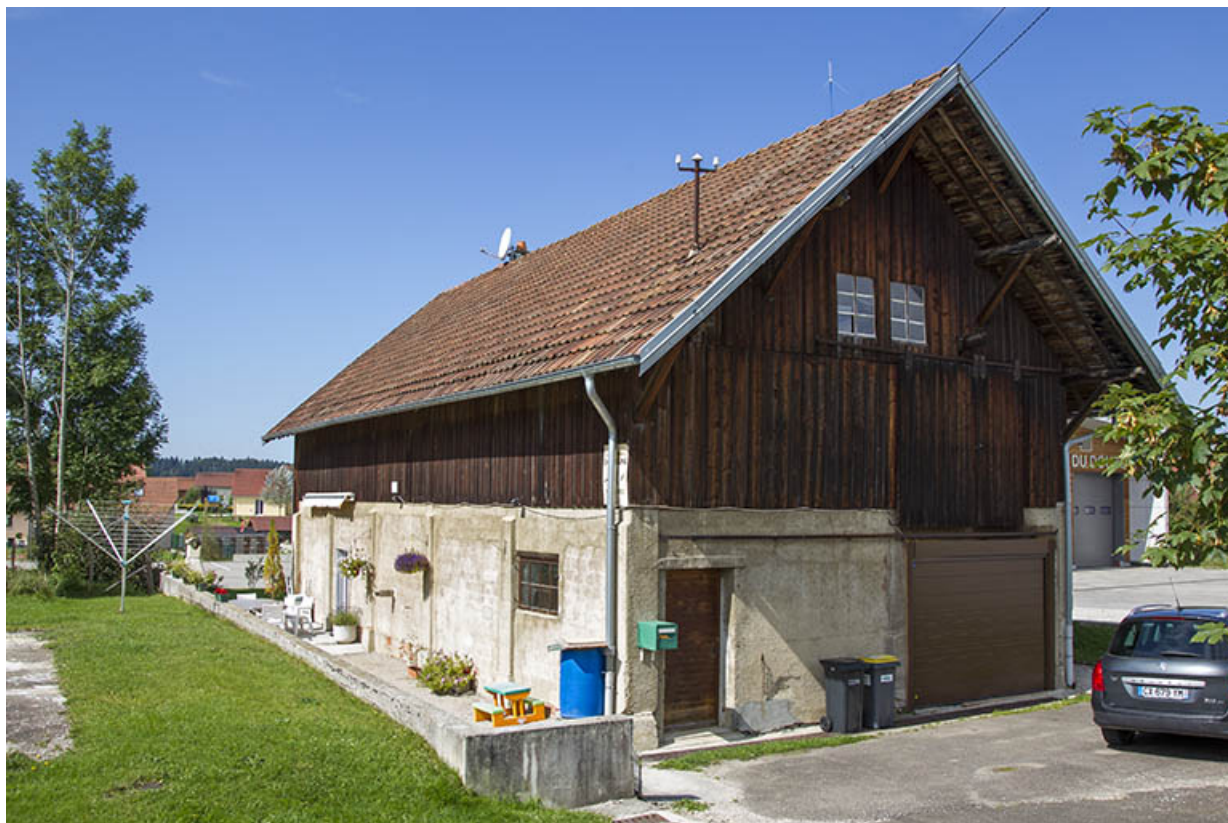
Logement d'ouvriers et dépôt de sciure, depuis la rue à l'est.
