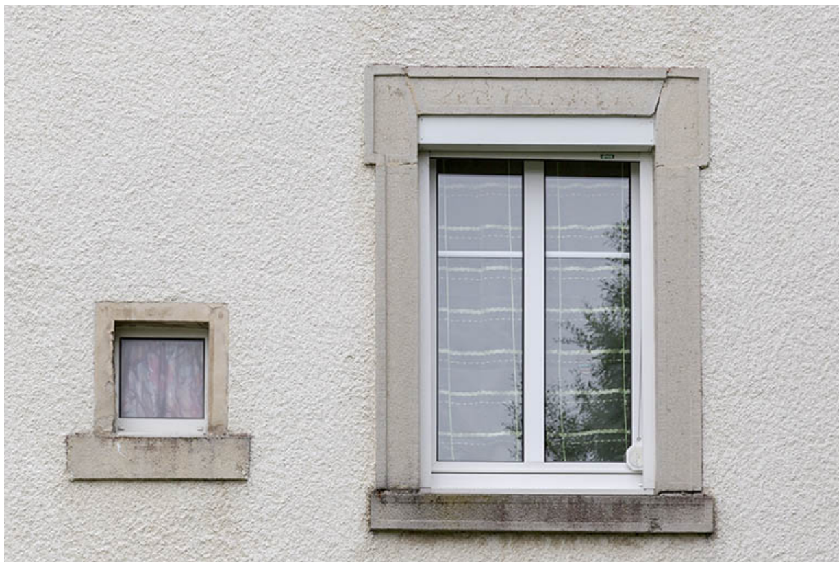
Logement patronal, façade postérieure : fenêtre du rez-de-chaussée surélevé. 25, Charquemont, 16 Rue Neuve
