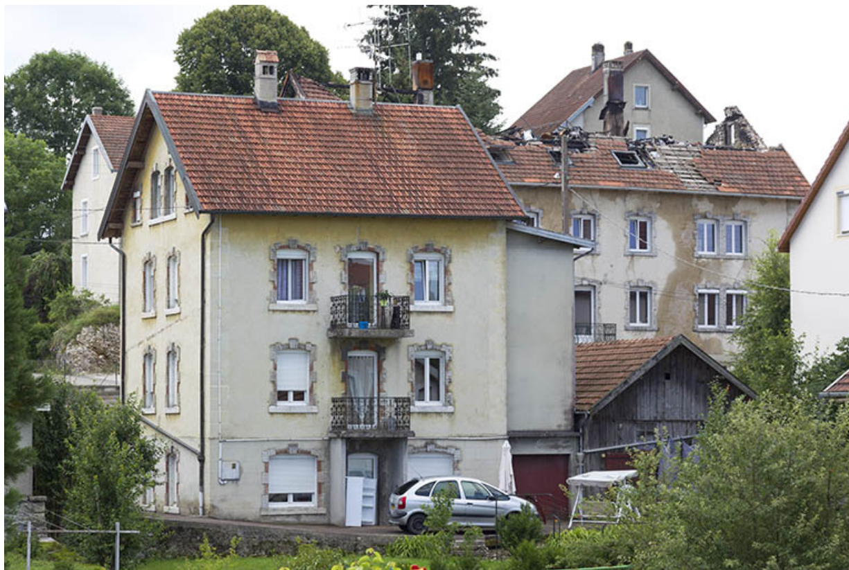
Façades postérieure et latérale droite. A l'arrière, l'usine Froidevaux Frères (au 5 Rue Neuve) incendiée le 25 juin 2014. 25, Charquemont, 8 Rue Neuve
