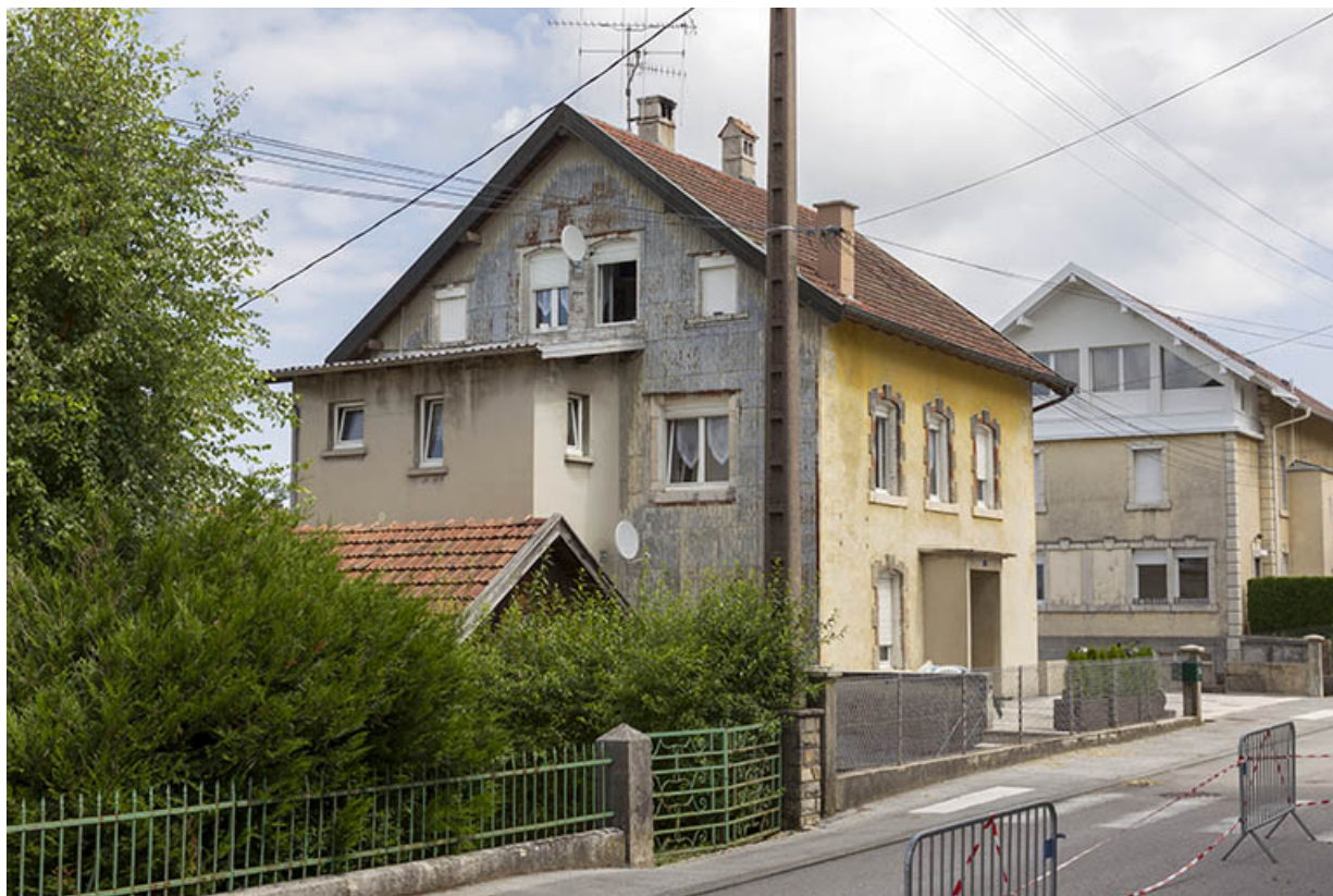
Façades antérieure et latérale gauche.
