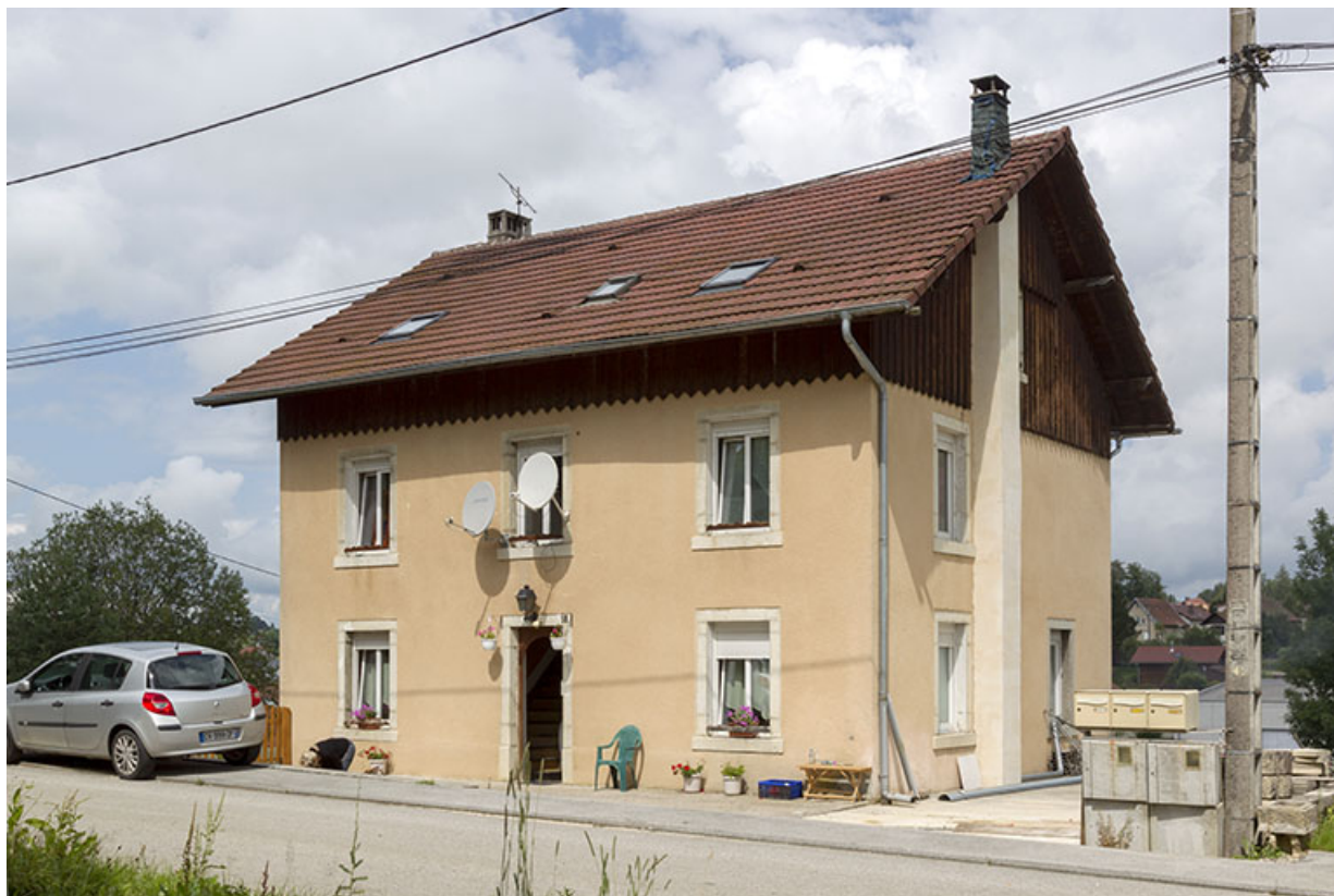
Façades antérieure et latérale droite.
