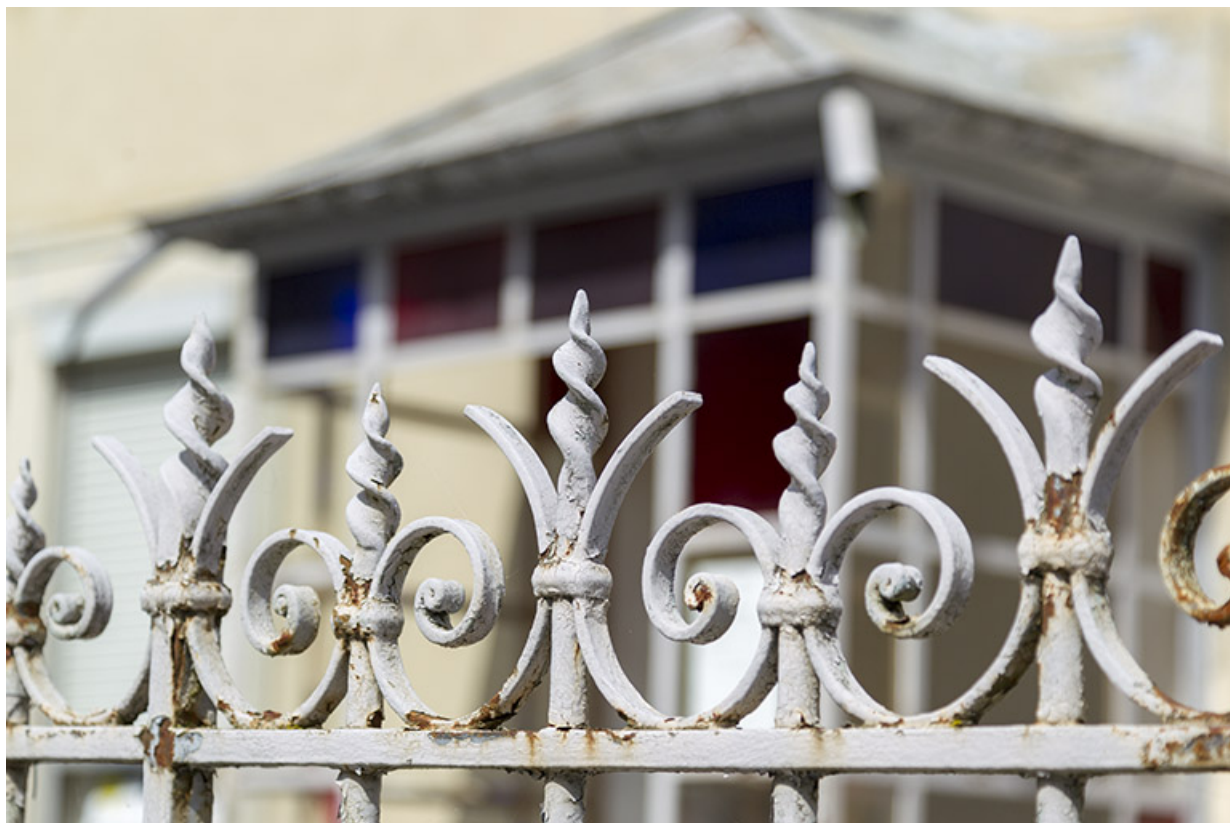
Détail de la ferronnerie de la grille de clôture.
