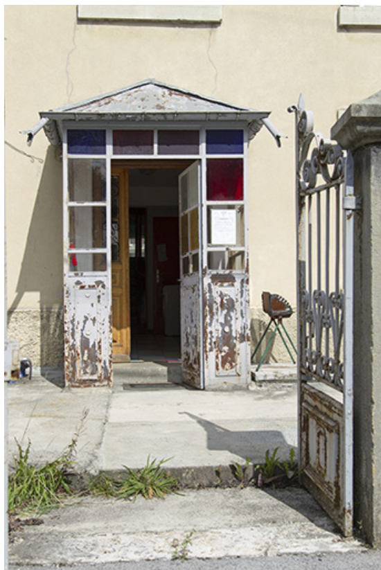
Façade antérieure : entrée.
