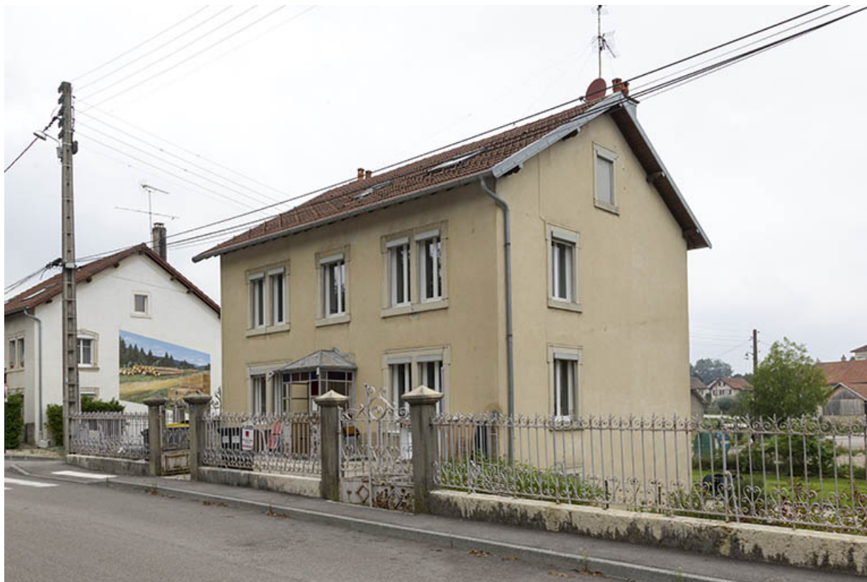
Façades antérieure et latérale droite.
