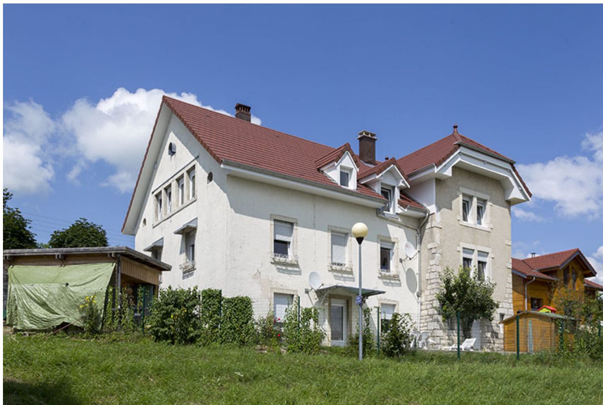
Façades postérieure et latérale droite.
