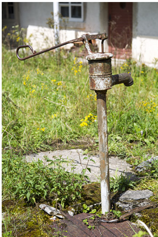
Pompe à eau sur la citerne.
