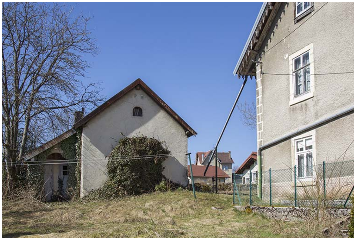
Tuyau d'alimentation de la citerne et dépendance.
