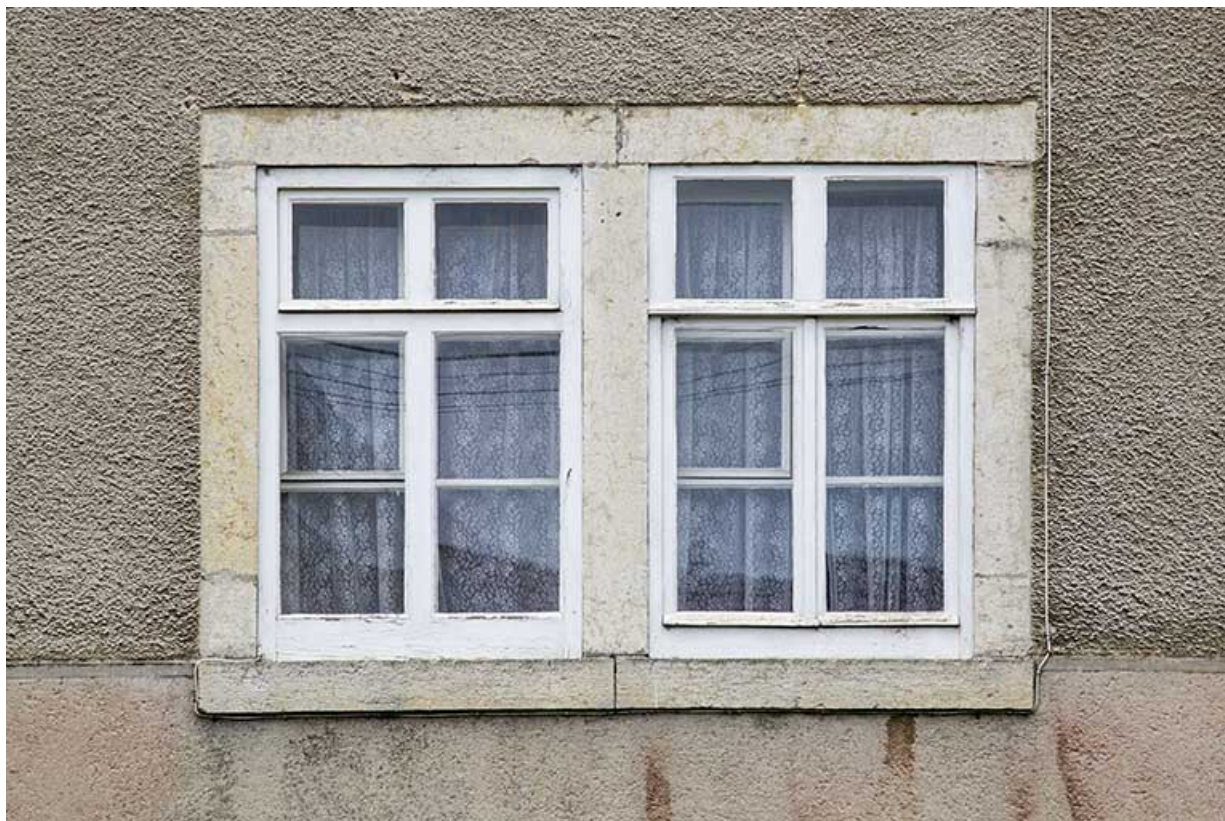
Une fenêtre horlogère ou "pile double" : atelier d'horlogerie de Louis et Léon Feuvrier puis de Robert Bessot (16 Grande Rue).
