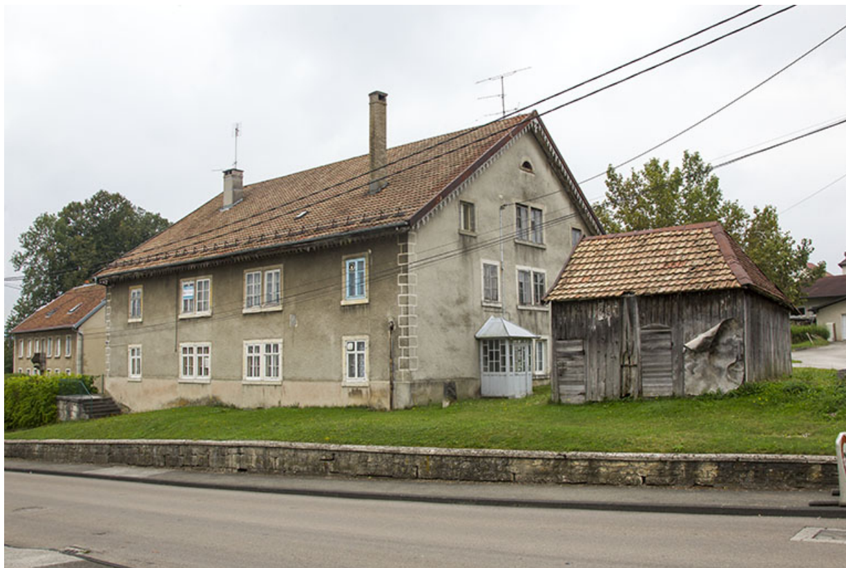
Un immeuble de 1892 : atelier d'horlogerie de Louis et Léon Feuvrier puis de Robert Bessot (16 Grande Rue). 25, Charquemont, 16 Grande Rue
