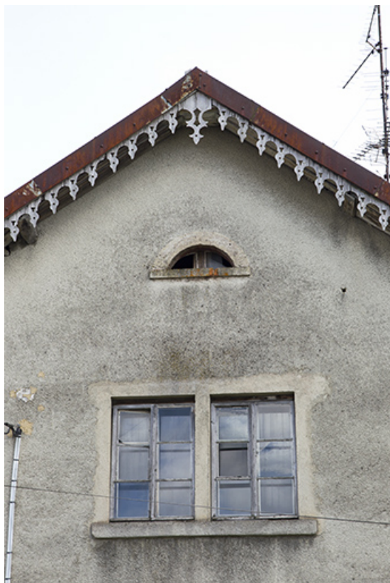
Façade latérale droite : pignon avec fenêtre horlogère.
