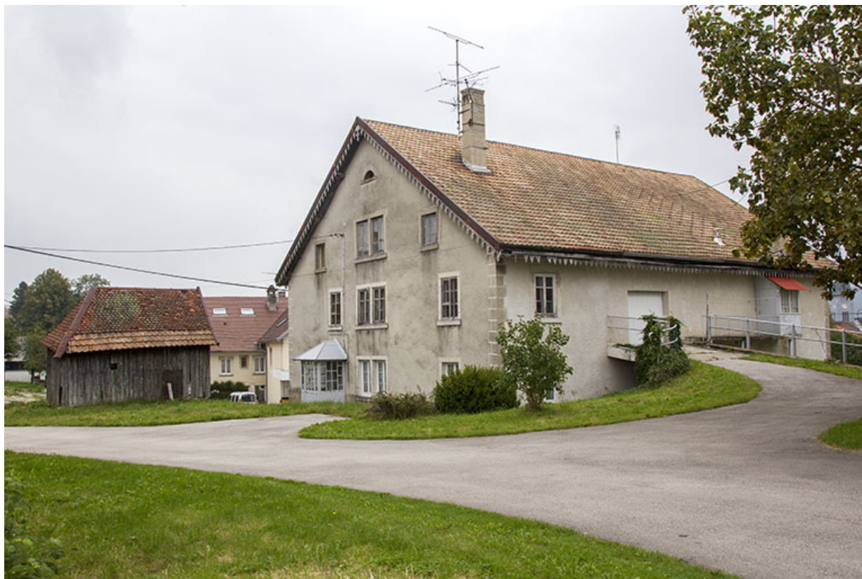
Vue d'ensemble, depuis l'ouest (façades postérieure et latérale droite). 25, Charquemont, 16 Grande Rue
