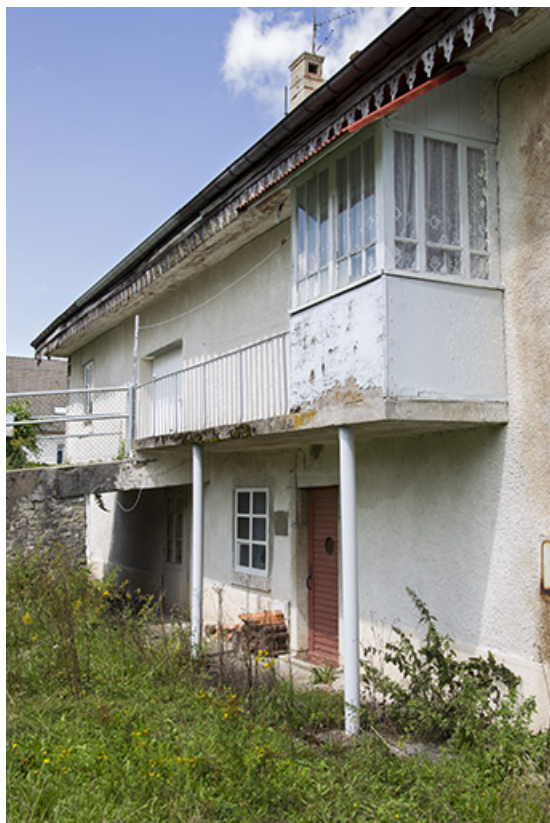
Façade postérieure, vue en enfilade depuis la droite. 25, Charquemont, 16 Grande Rue
