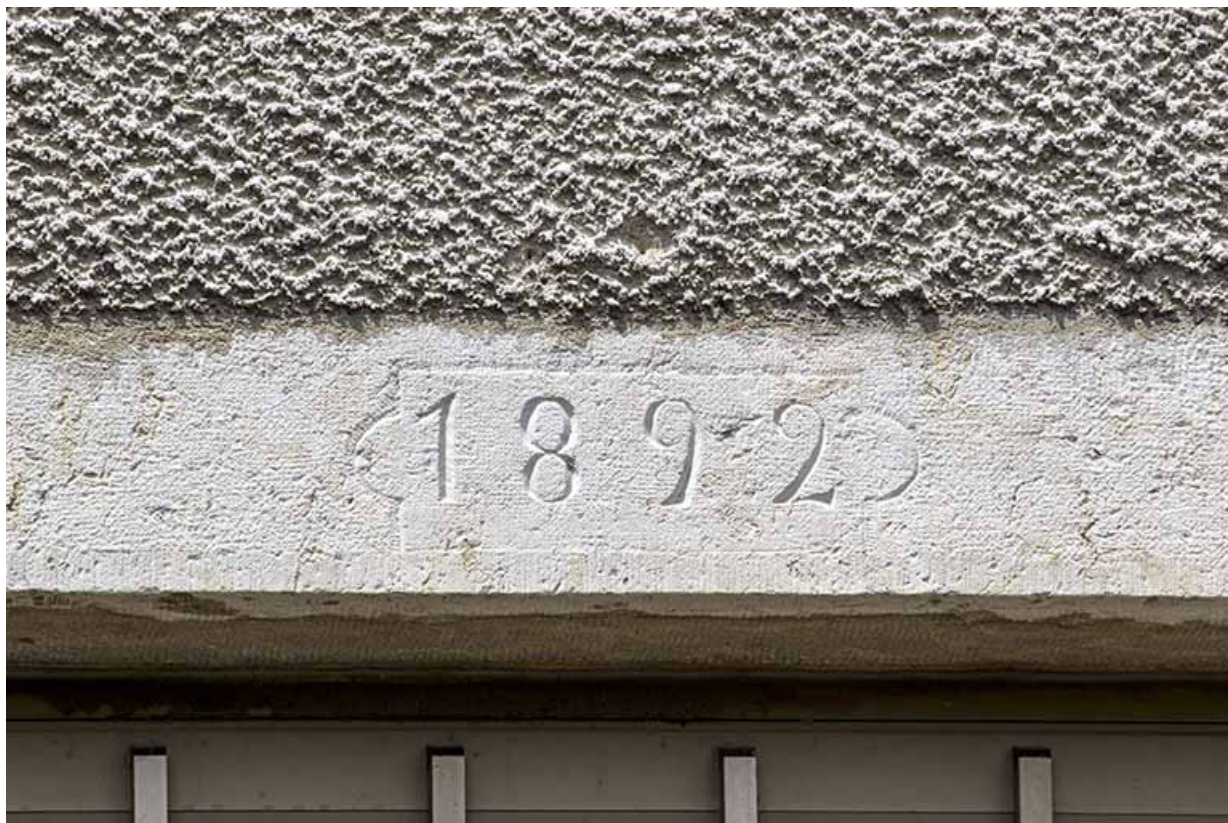
Façade latérale gauche : date 1892 gravée sur un linteau.
