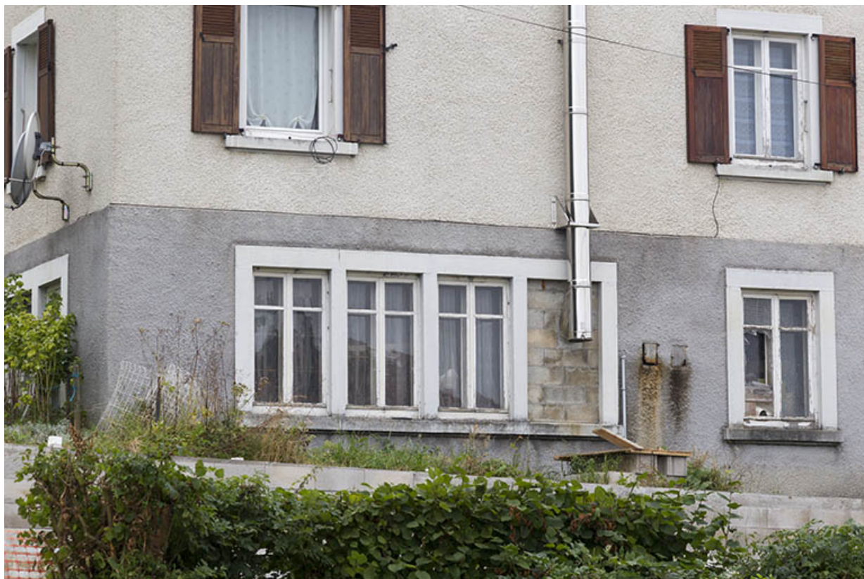
Façade latérale droite : fenêtres multiples ouvrant l'étage de soubassement.
