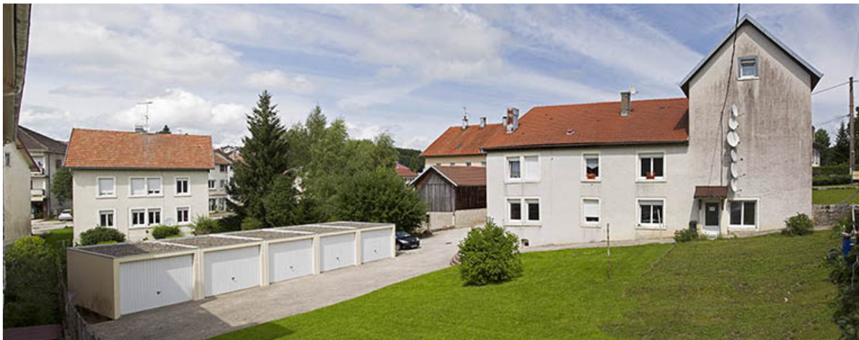
Vue d'ensemble, depuis l'ouest. De gauche à droite : garages, aile en retour et bâtiment principal (mur pignon). 25, Charquemont, 2 Rue Neuve
