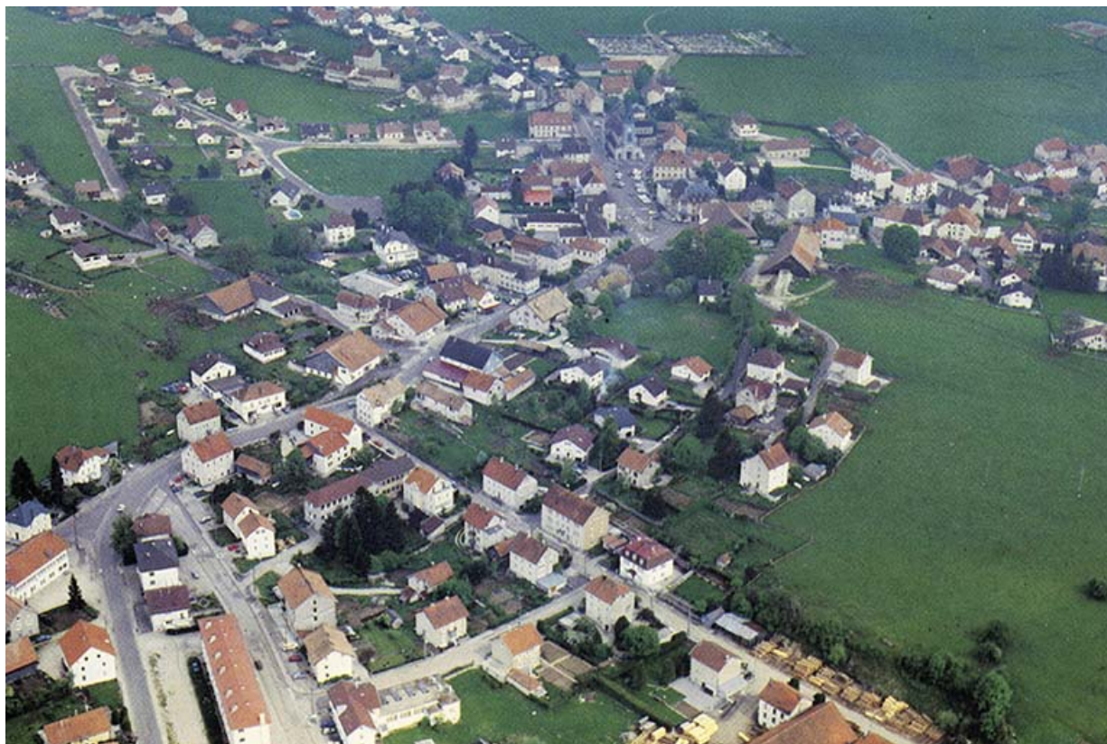
25140 Charquemont [vue aérienne du village depuis l'ouest], 4e quart 20e siècle 25, Charquemont, 3 rue Pasteur
