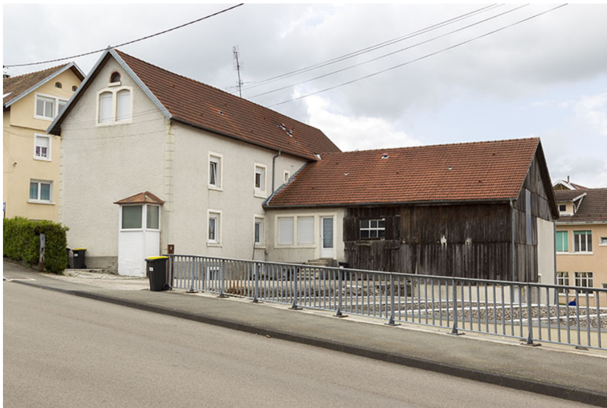
Bâtiment principal (façades postérieure et latérale droite) et aile en retour, depuis le nord. 25, Charquemont, 2 Rue Neuve
