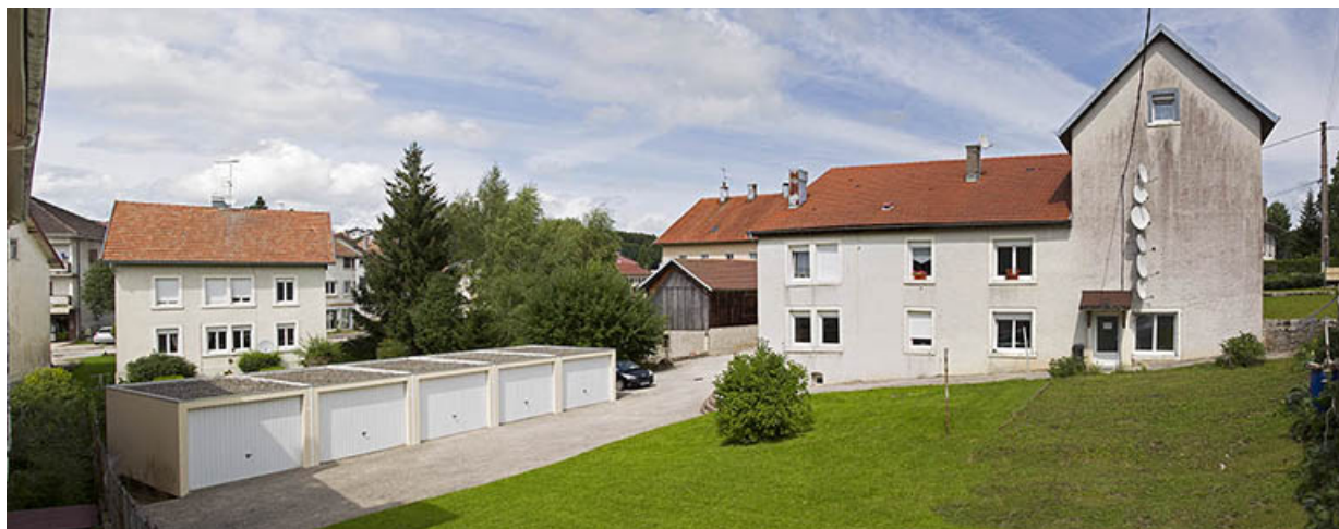
Vue d'ensemble, depuis l'ouest. De gauche à droite : garages, aile en retour et bâtiment principal (mur pignon). 25, Charquemont, 2 Rue Neuve
