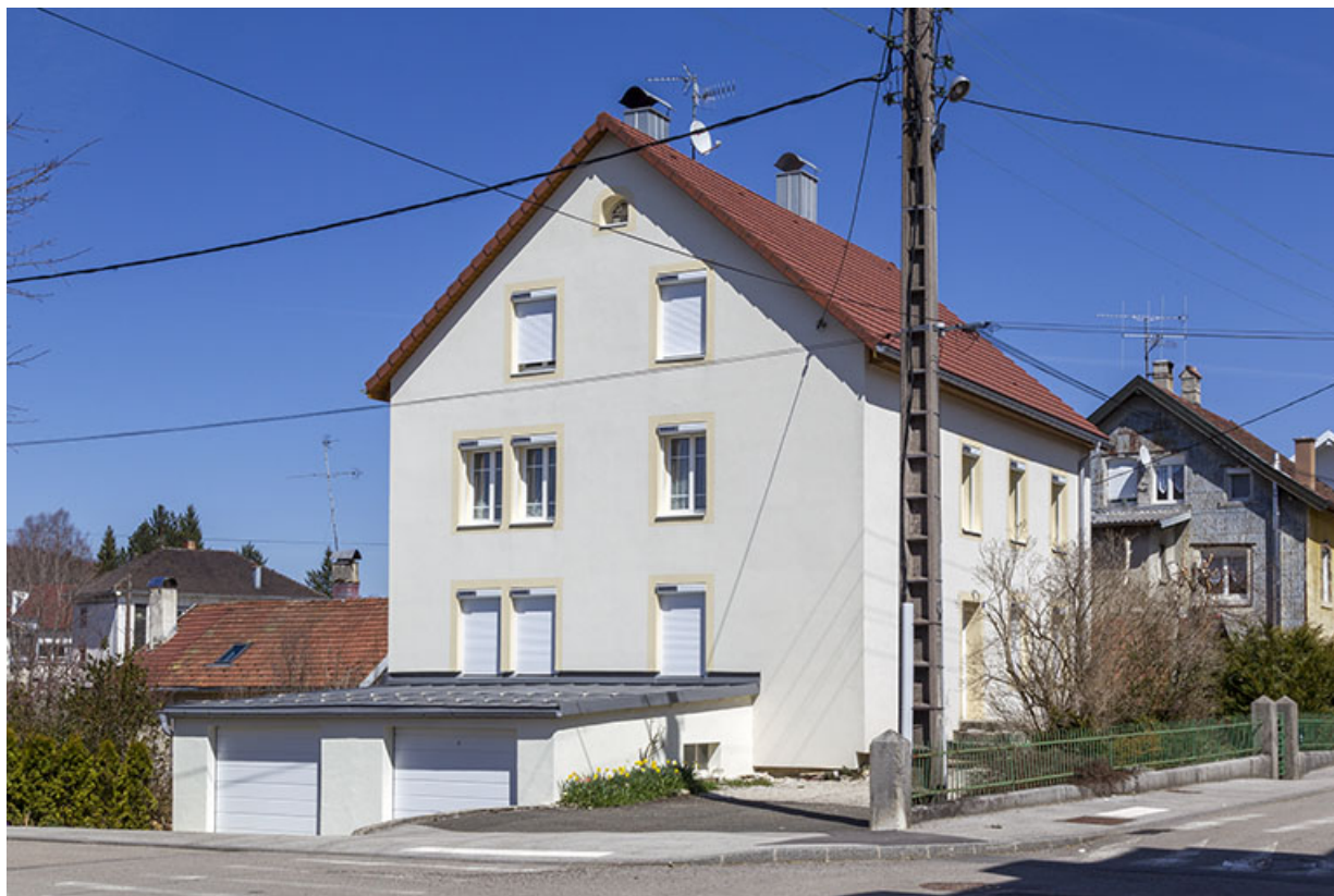
Façades antérieure et latérale gauche.
