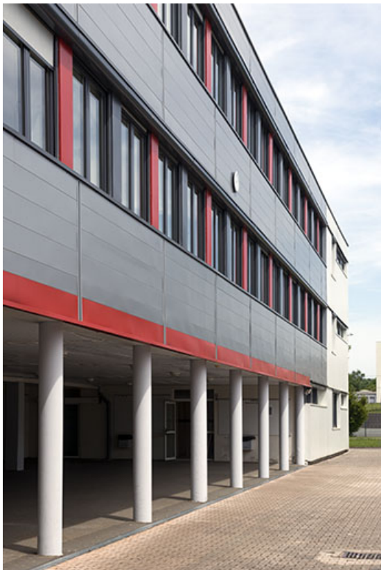
Vue sur le préau et l'externat fermant la cour au nord. 25, Bethoncourt impasse Camus
