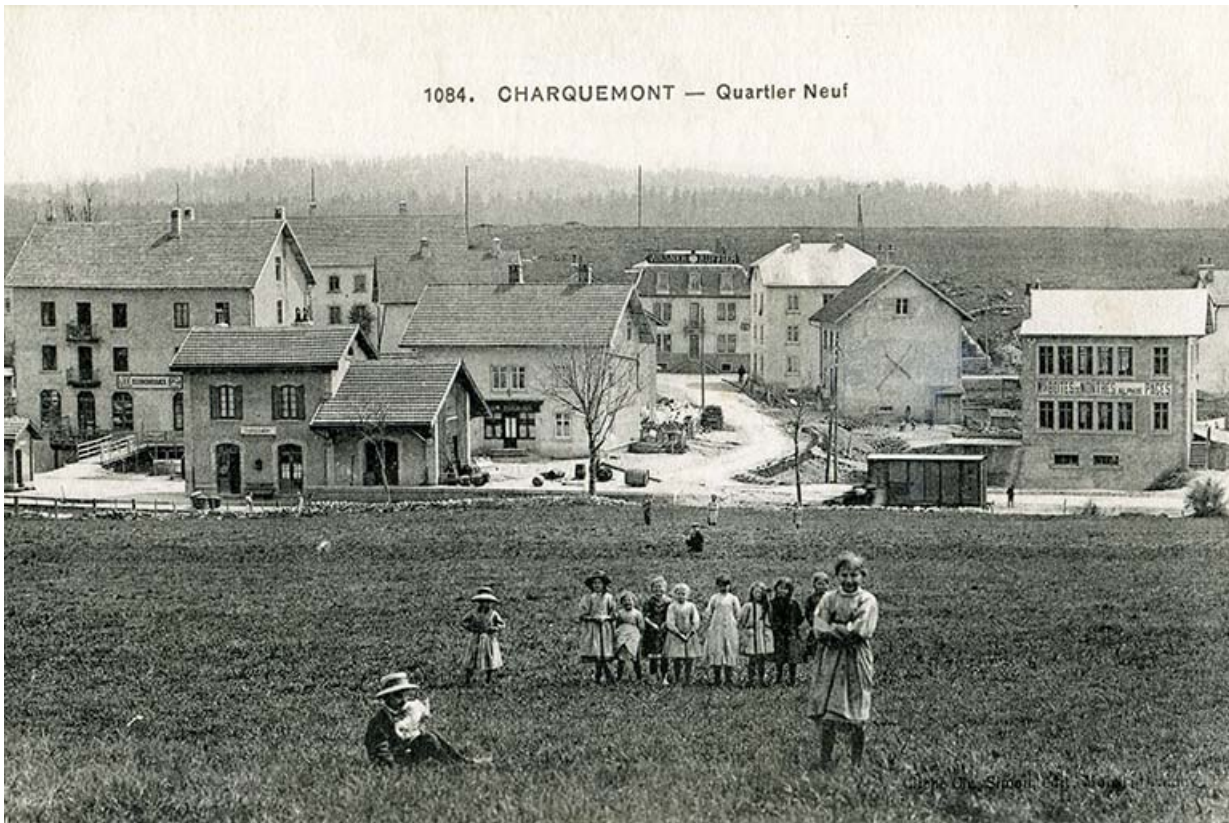
1084. Charquemont - Quartier Neuf, 1er quart 20e siècle 25, Charquemont, 13 rue de la Gare
