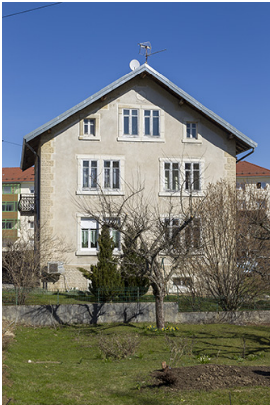
Façade latérale droite.
