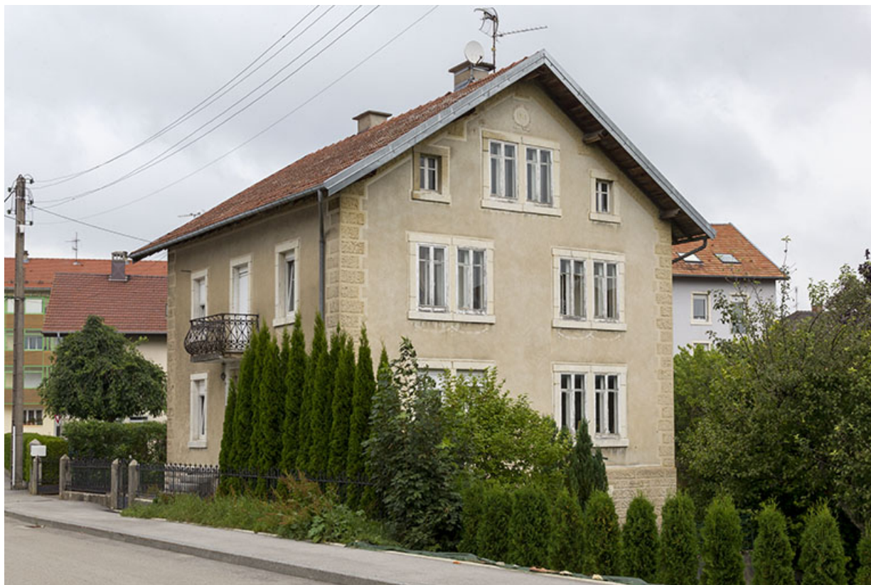
Vue d'ensemble, depuis le sud (façades antérieure et latérale droite). 25, Charquemont, 2 rue Pasteur
