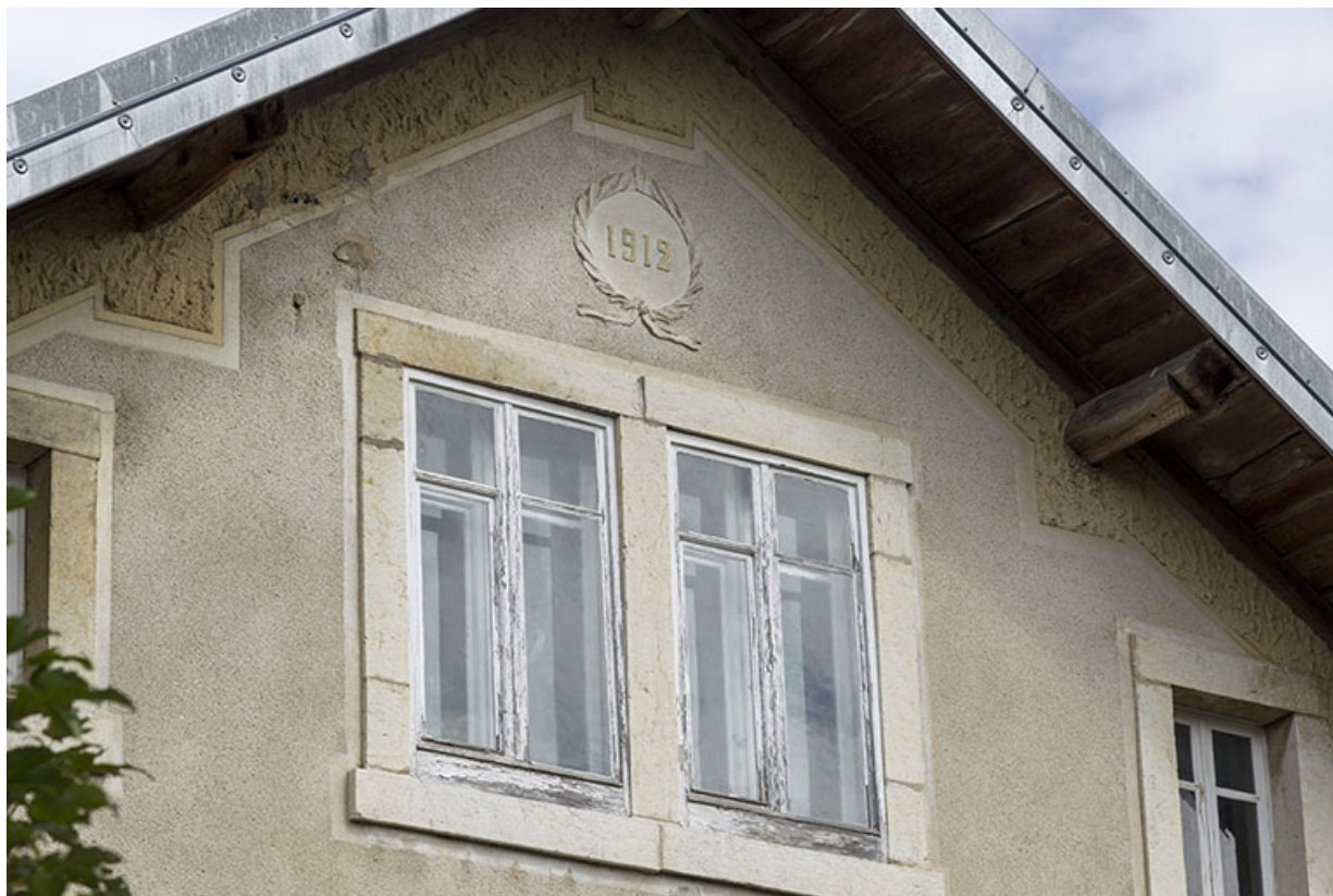
Façade latérale droite : date et fenêtre horlogère sur le pignon.
