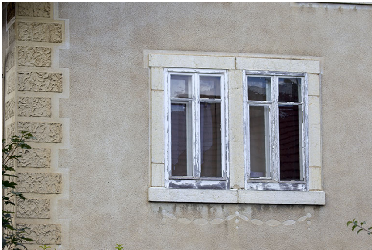
Façade latérale droite : fenêtre horlogère et décor.
