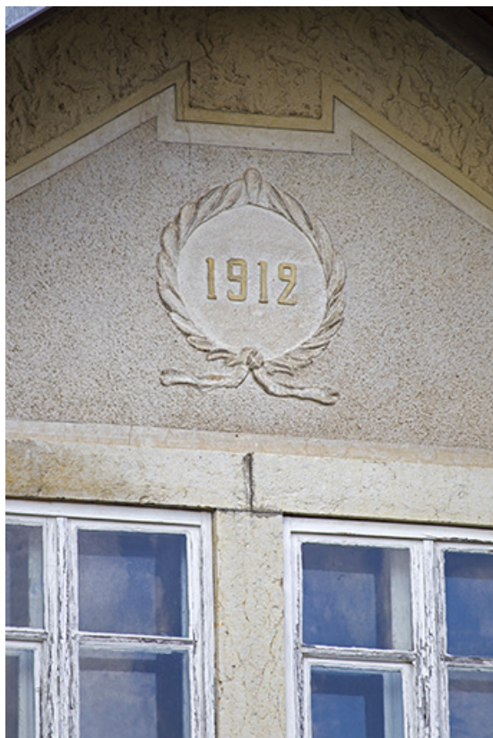
Façade latérale droite : date sur le pignon.
