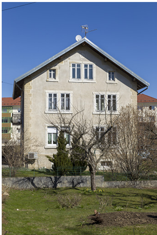
Façade latérale droite.
