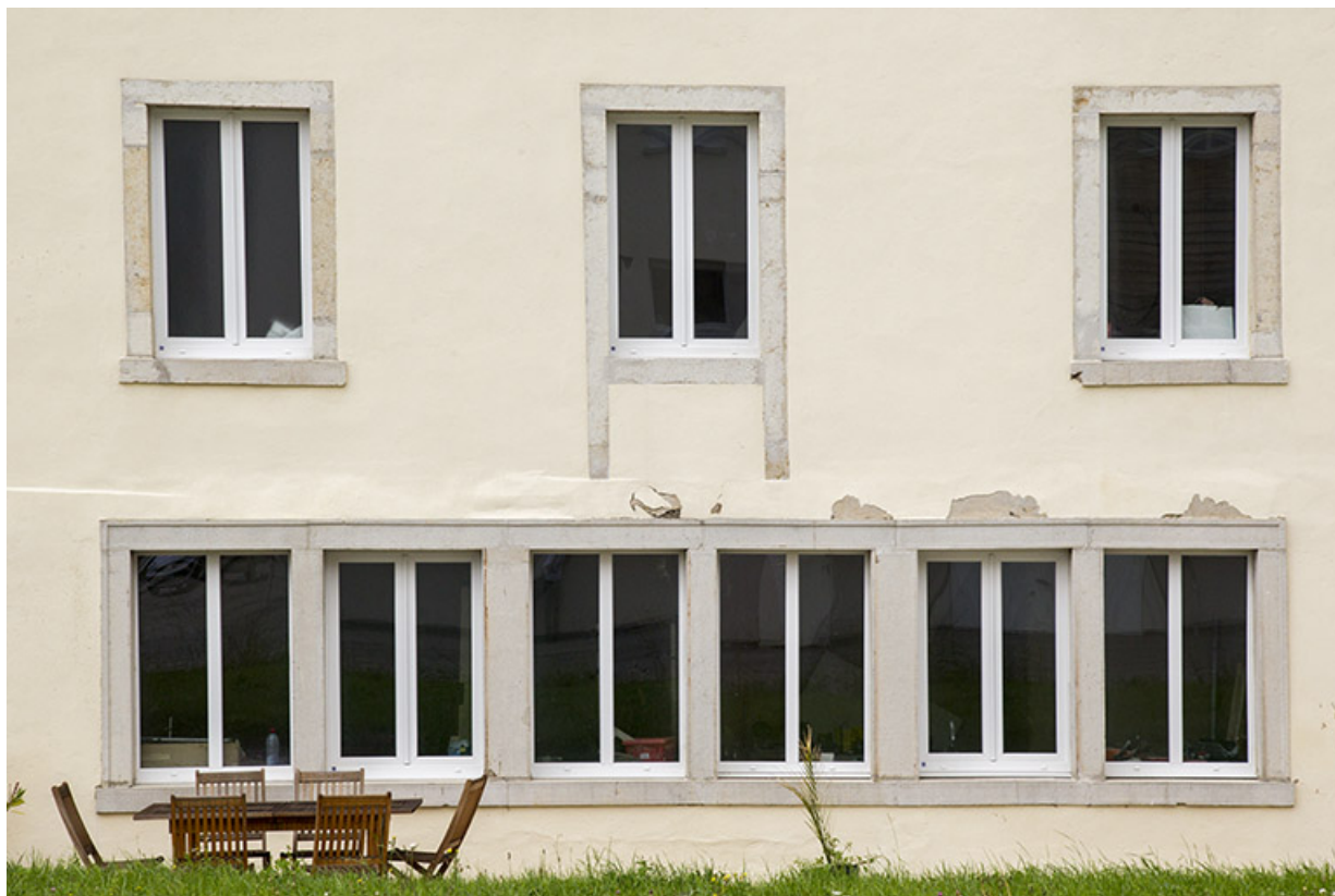
Façade postérieure : fenêtres multiples à l'étage de soubassement.
