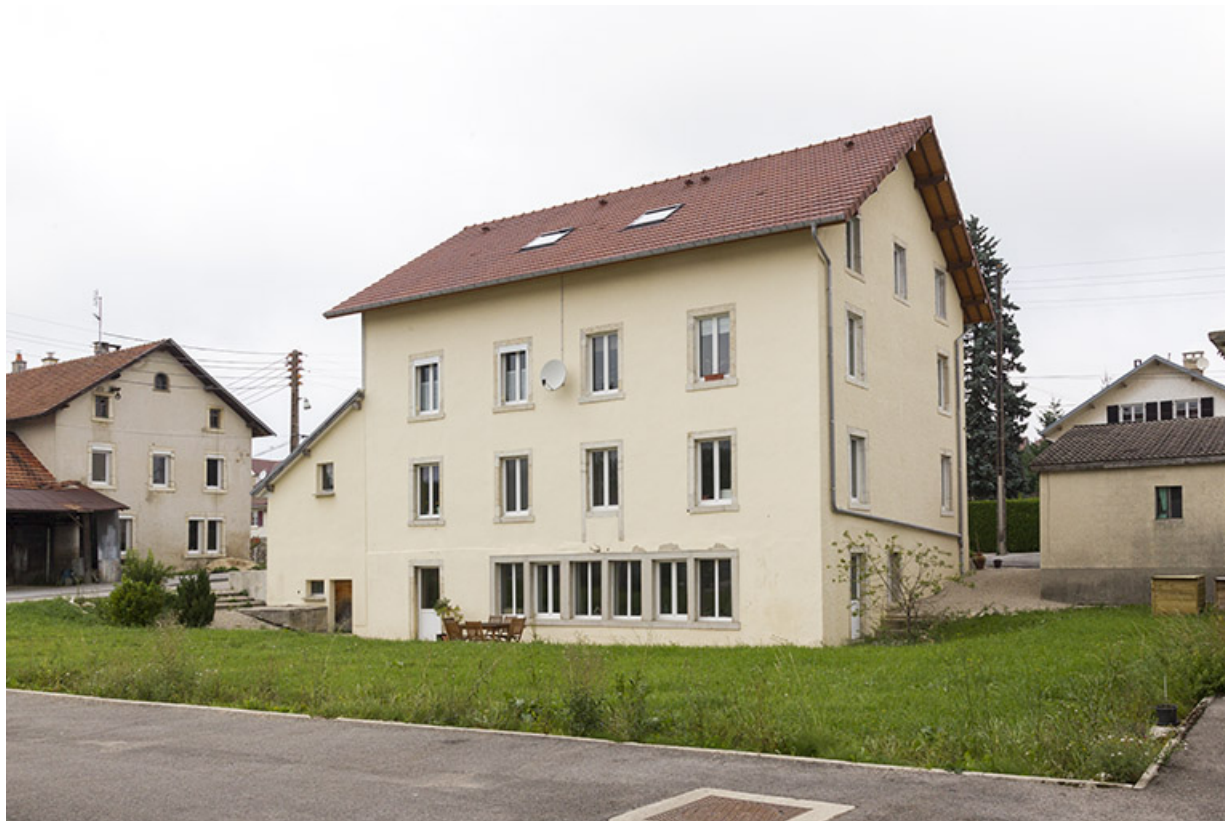
Façades postérieure et latérale droite.
