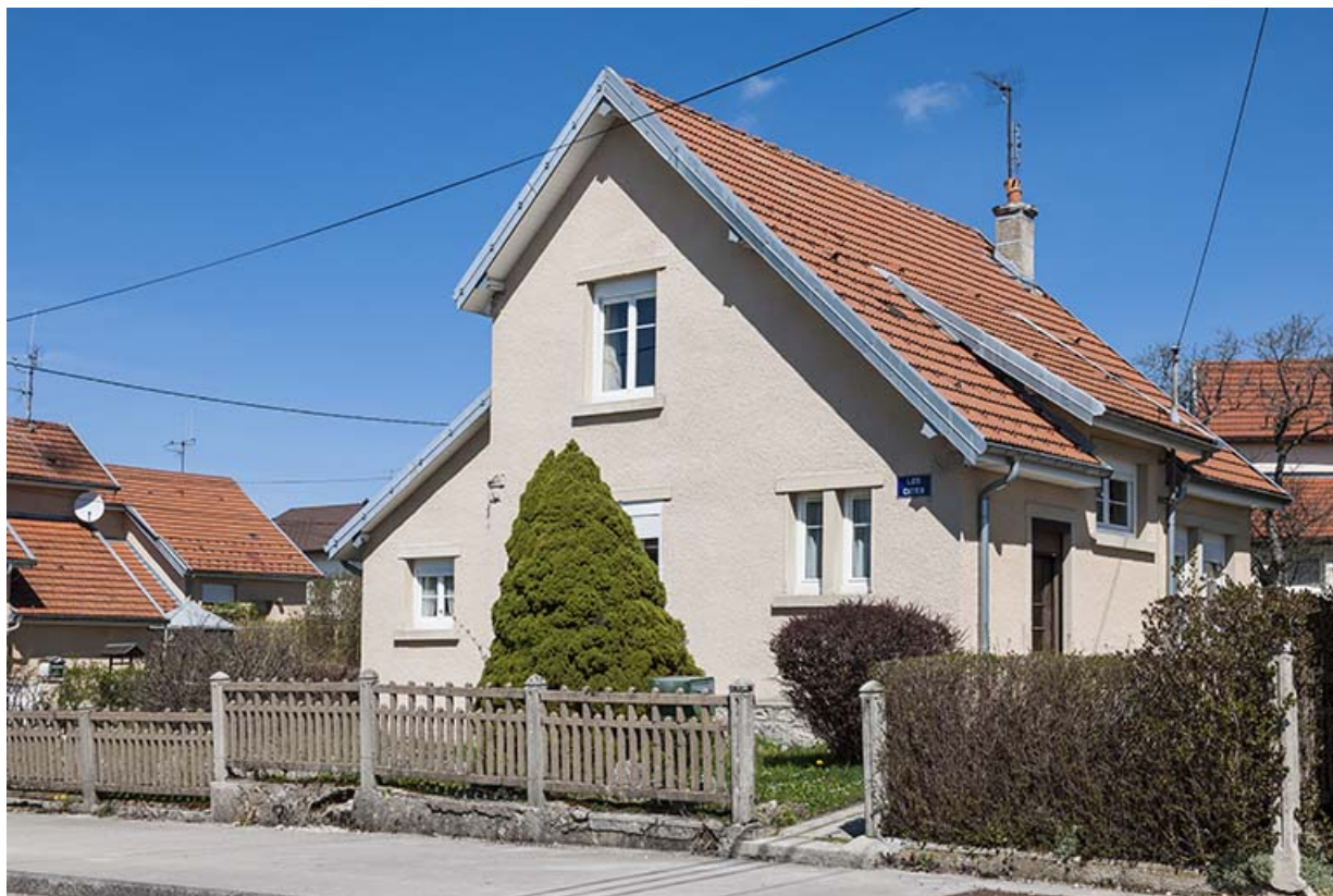
Vue d'ensemble, depuis le sud. 25, Charquemont, 2 rue des Cités
