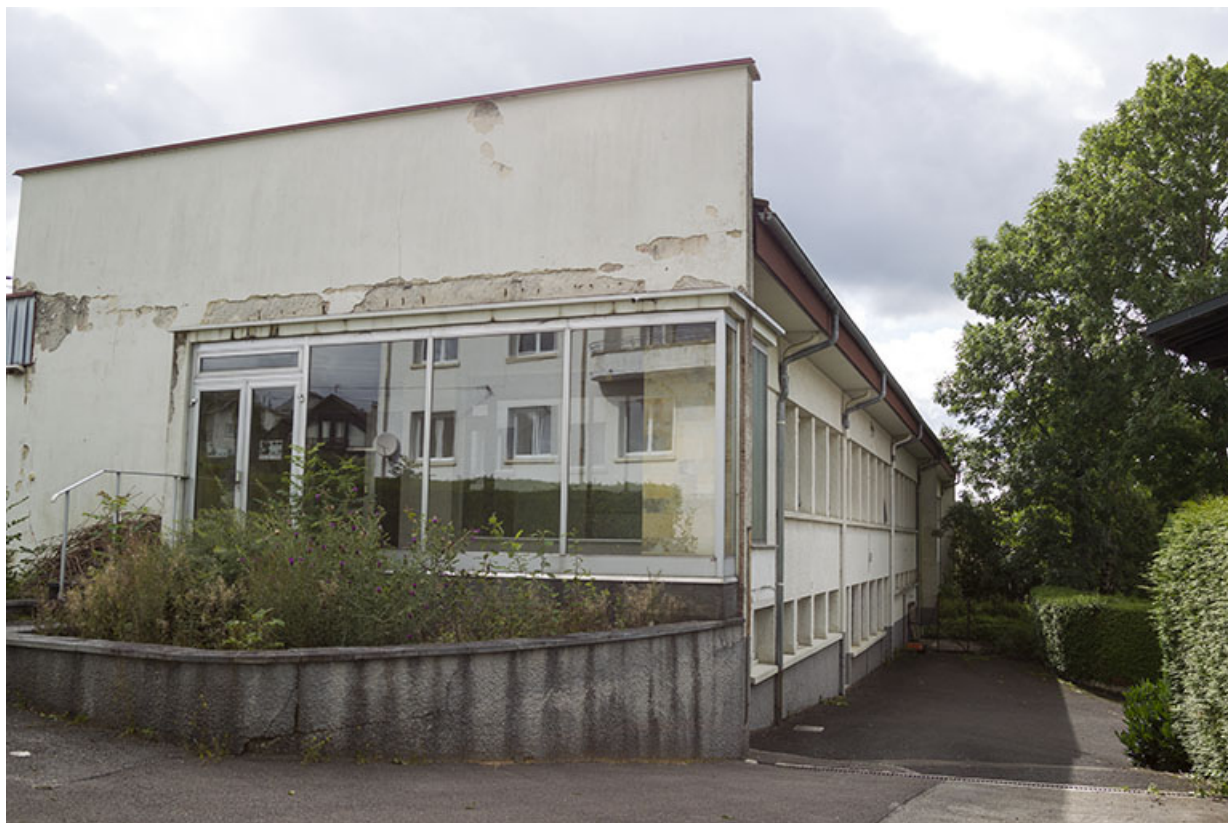
Usine, corps de bâtiment ancien : façades antérieure et latérale droite.
