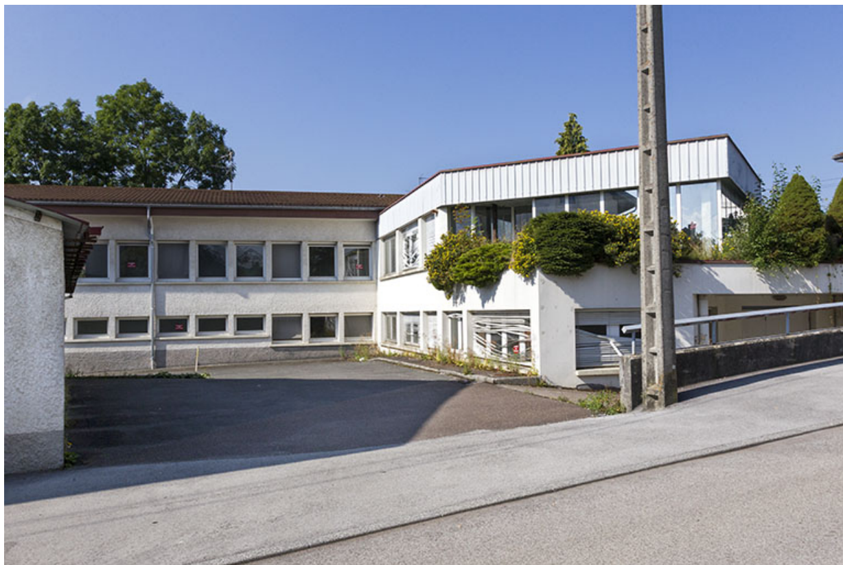
Usine, vue de l'est : corps de bâtiment ancien à gauche, récent à droite. 25, Charquemont, 7 et 9 rue Victor Hugo
