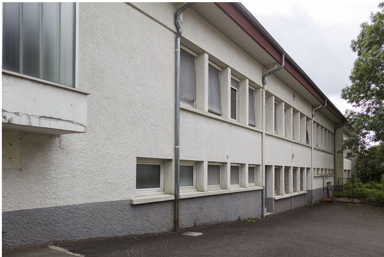
Usine, corps de bâtiment ancien : façade latérale droite.
