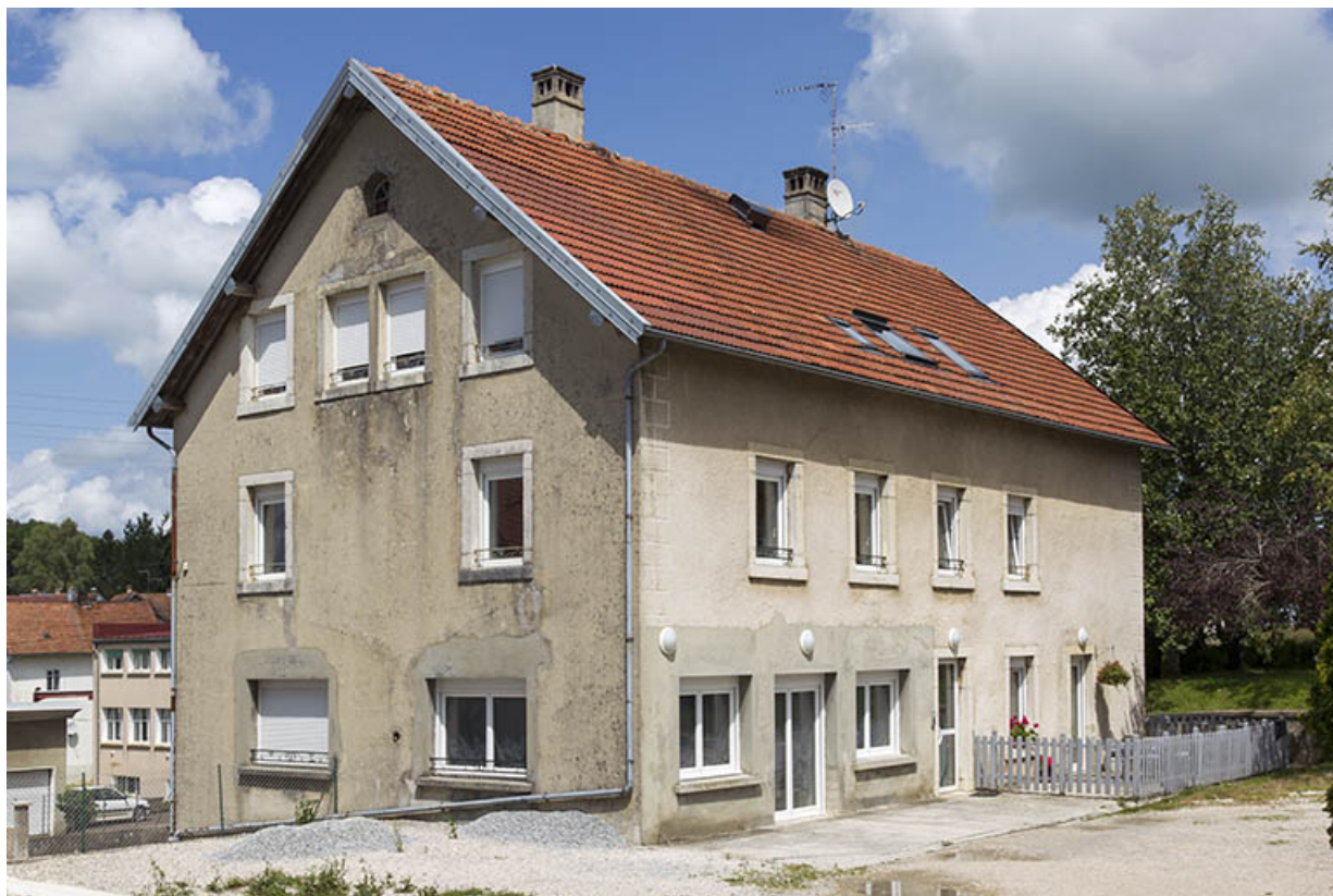
Façades postérieure et latérale droite.
