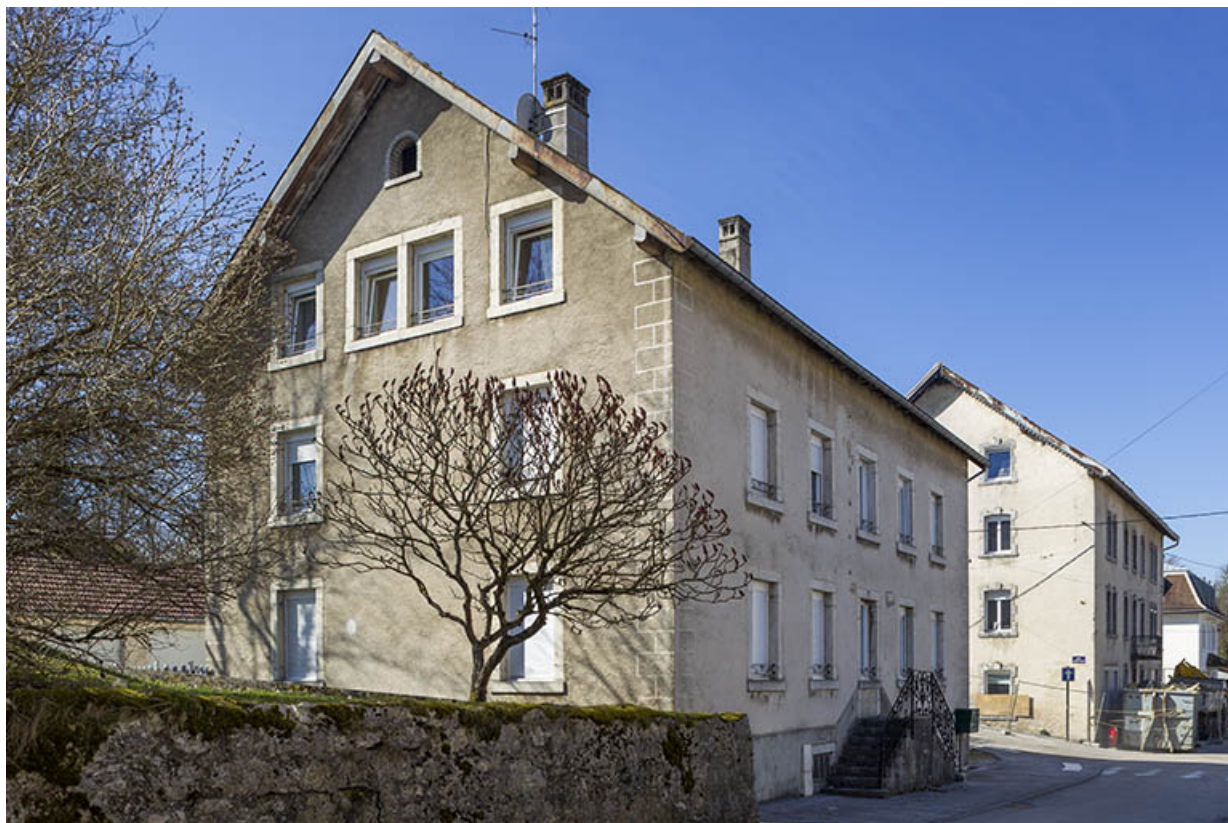
Façades antérieure et latérale gauche.
