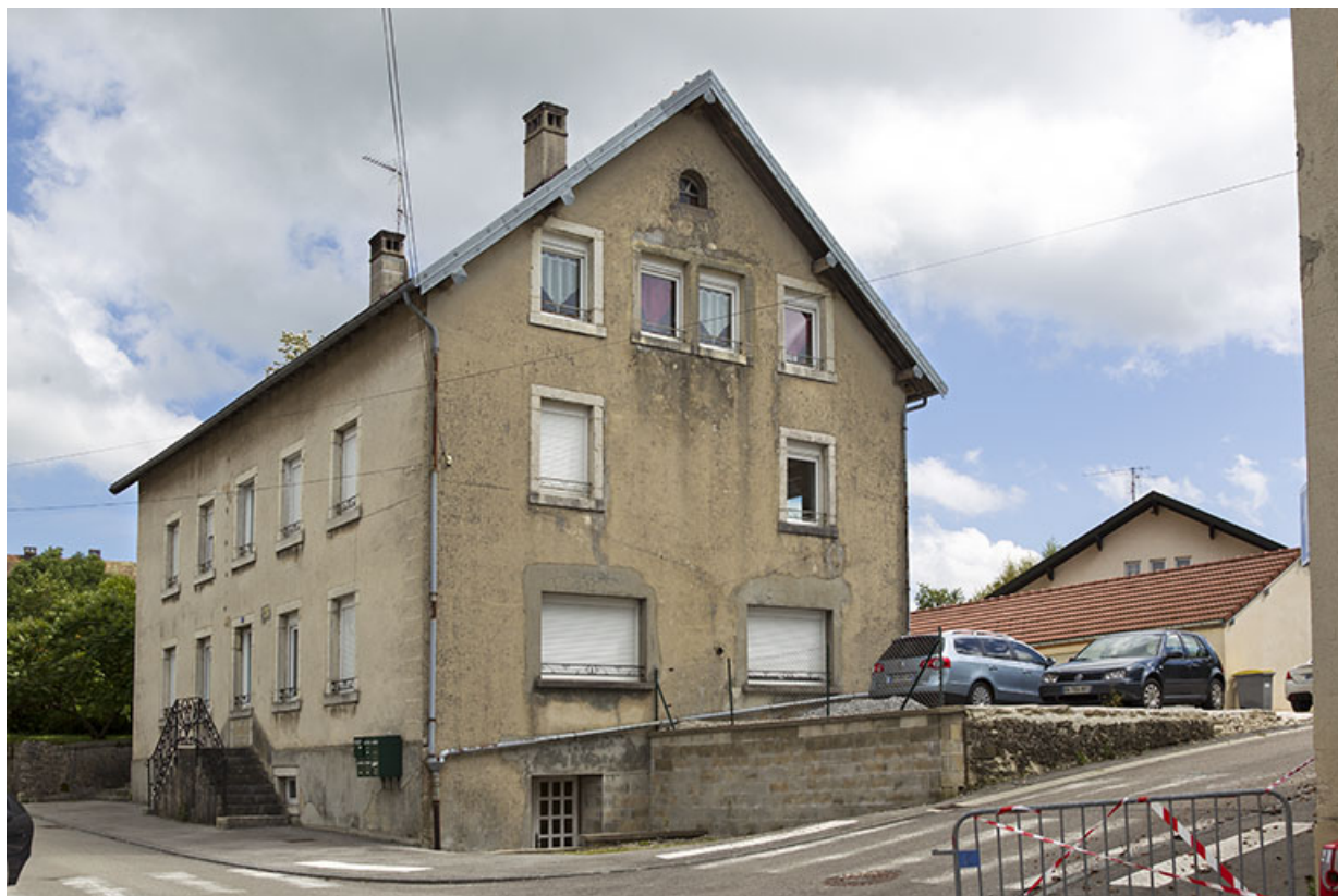
Façades antérieure et latérale droite.
