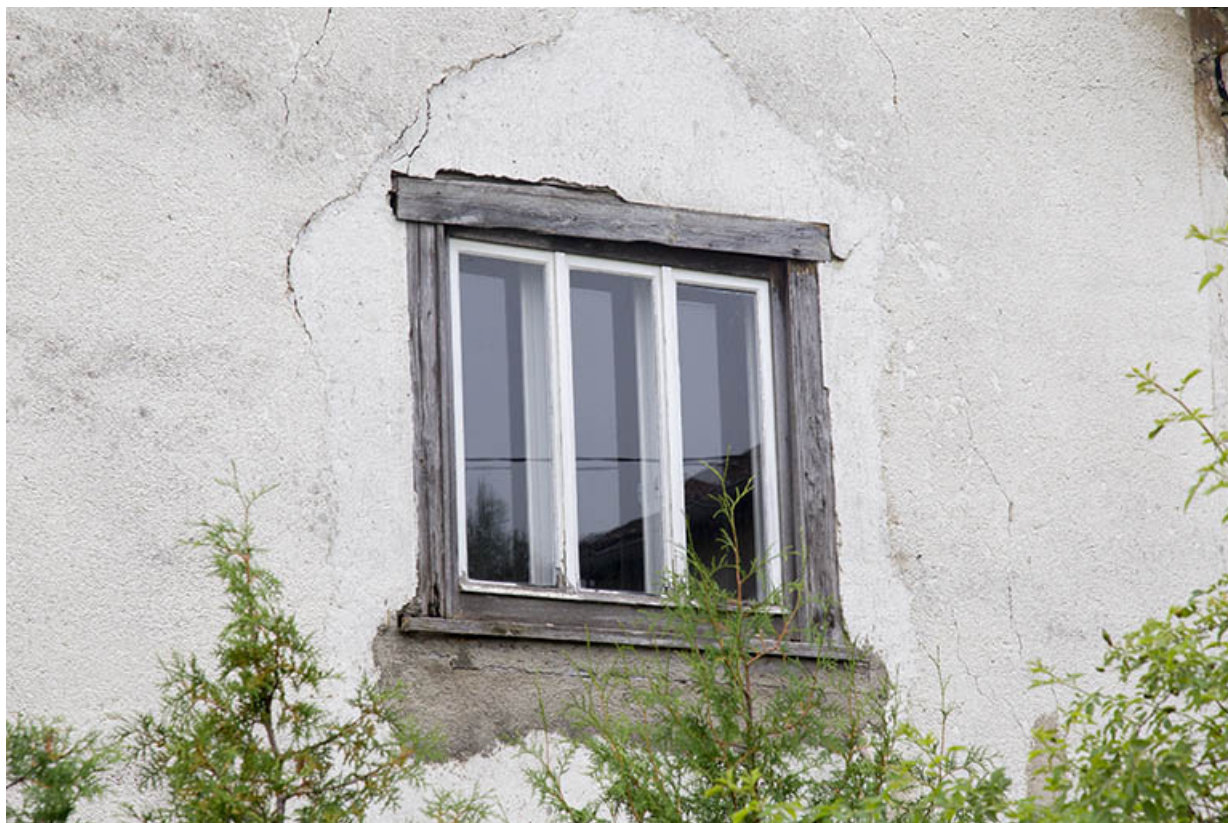
Façade latérale droite : fenêtre à encadrement en bois.
