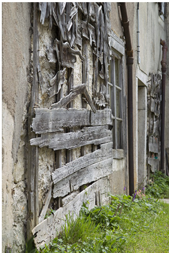
Façade postérieure : support de l'essentage de tavillons, vu en enfilade. 25, Charquemont, 48 Grande Rue
