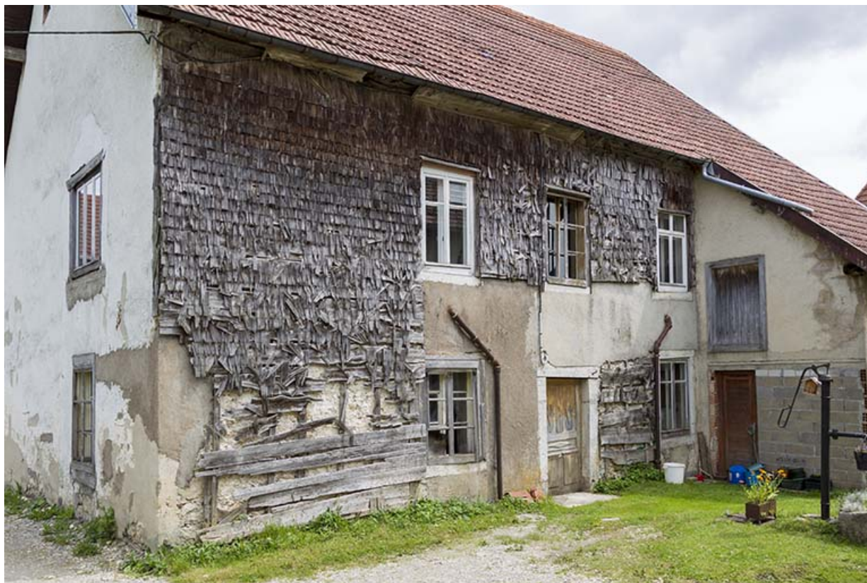
Façade postérieure, de trois quarts gauche. 25, Charquemont, 48 Grande Rue
