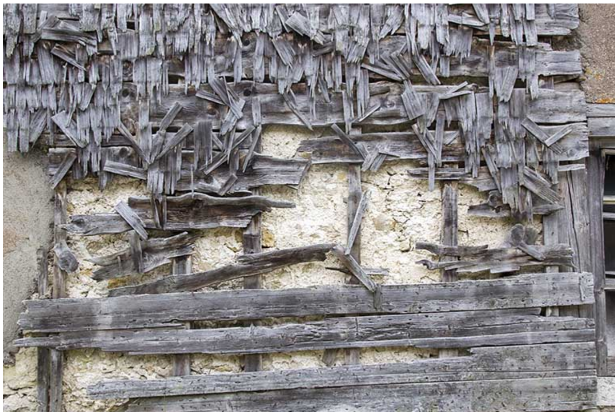
Façade postérieure : vestiges de l'essentage de tavillons.
