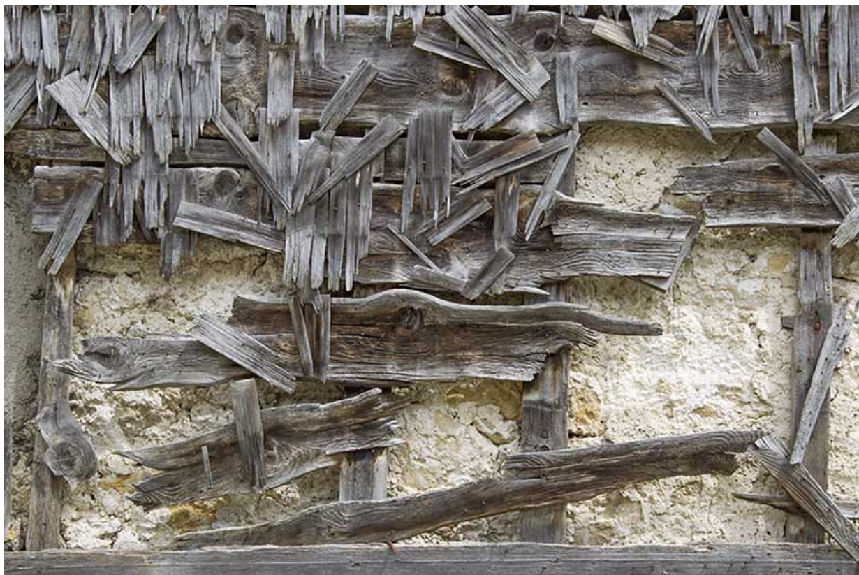
Façade postérieure : vestiges de l'essentage de tavillons.
