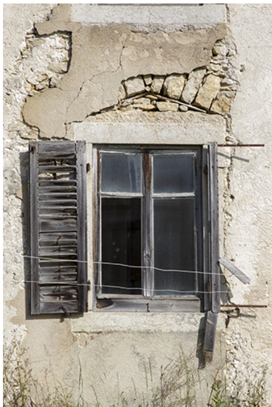
Façade latérale gauche : fenêtre surmontée d'un arc de décharge. 25, Charquemont, 48 Grande Rue
