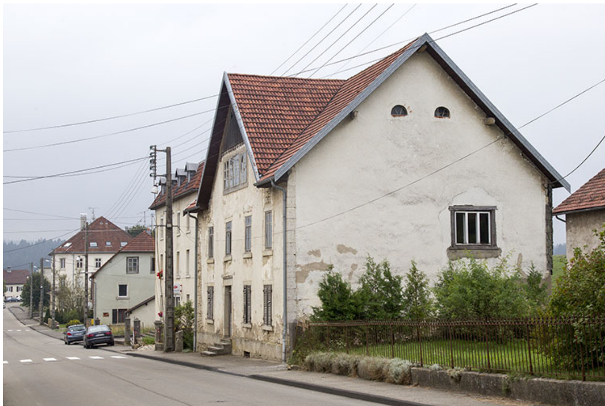
Vue d'ensemble, depuis le nord (façades antérieure et latérale droite). 25, Charquemont, 48 Grande Rue
