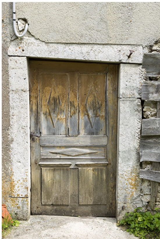
Façade postérieure : porte.
