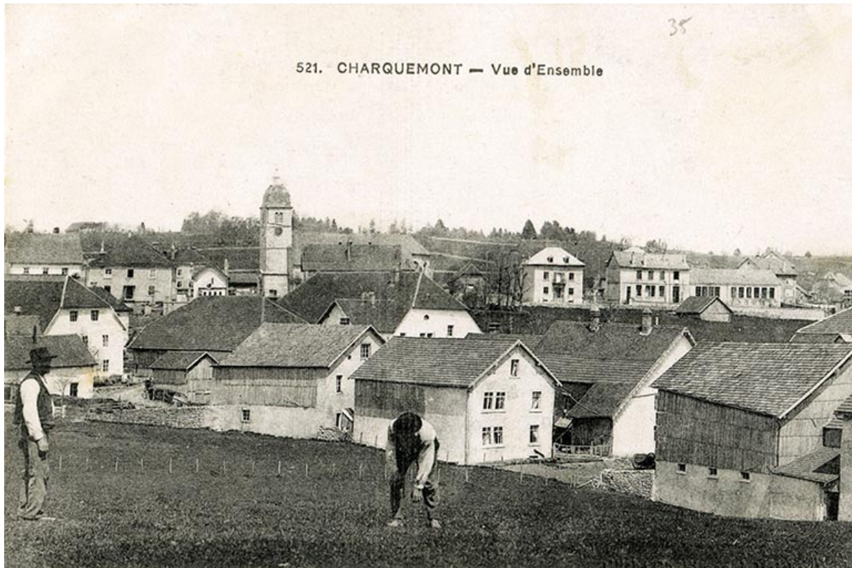
521. Charquemont - Vue d'ensemble [le quartier de l'église et le bas du village vus du sud], 1er quart 20e siècle 25, Charquemont, 50 et 52 Grande Rue
