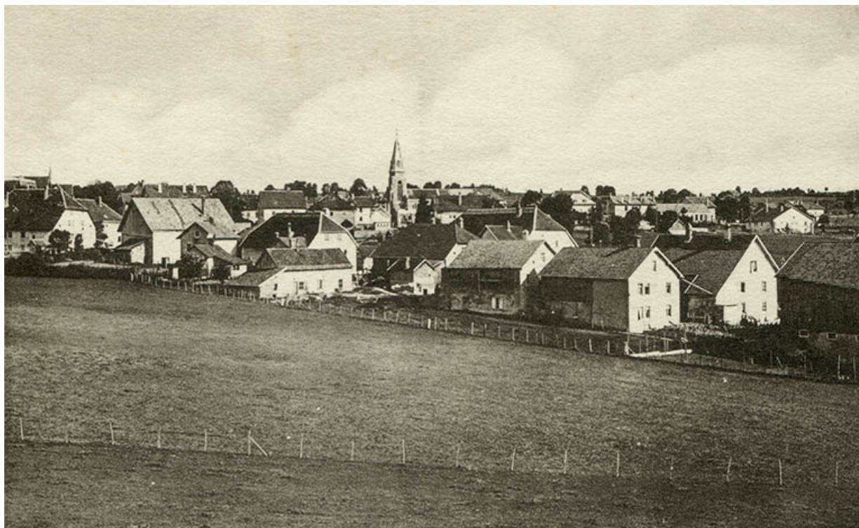
17 Charquemont - Vue générale [le quartier de l'église et le bas du village vus du sud], milieu 20e siècle. Arrière du bâtiment. 25, Charquemont, 48 Grande Rue
