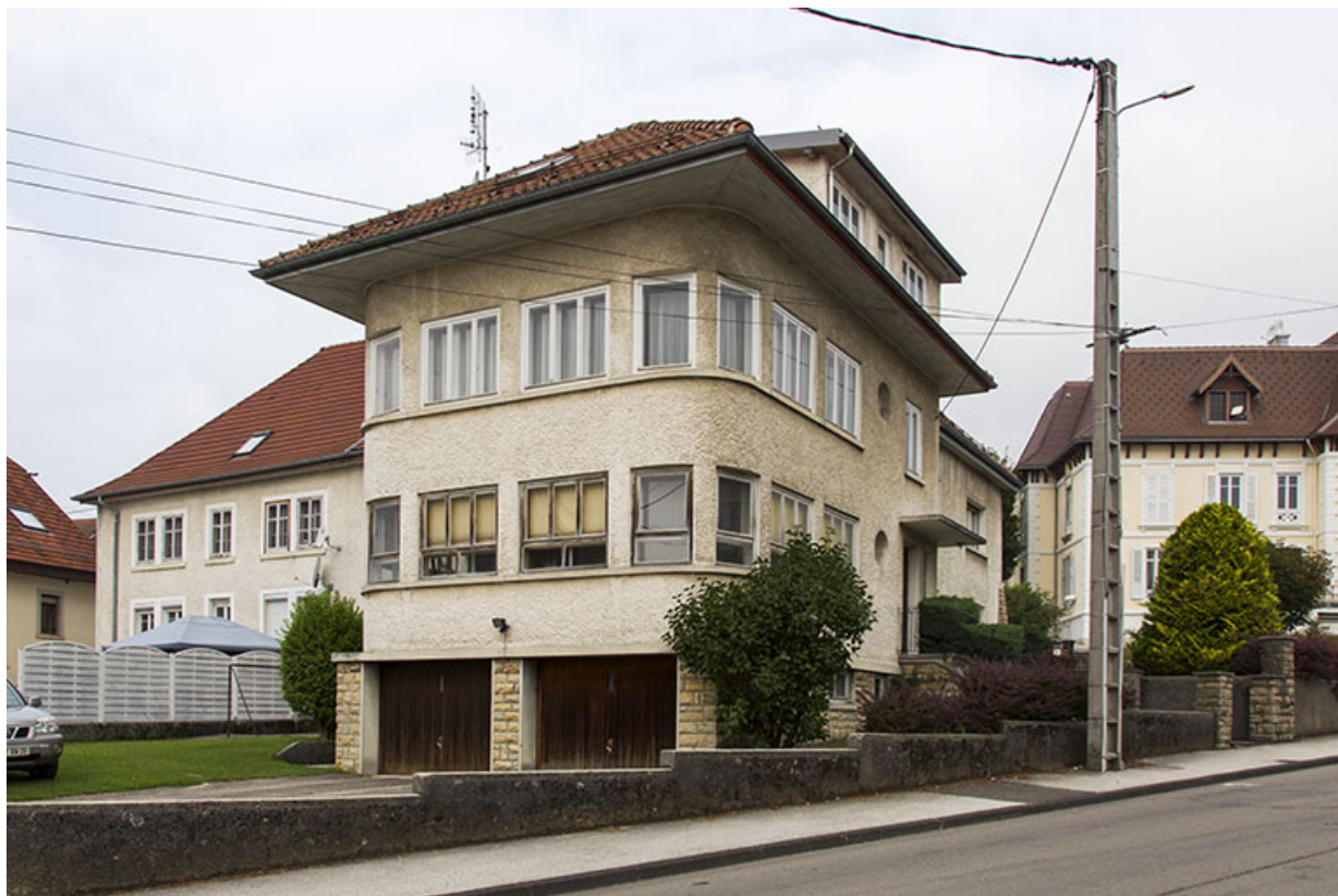
Corps de bâtiment de 1965 : atelier de fabrication et bureau.
