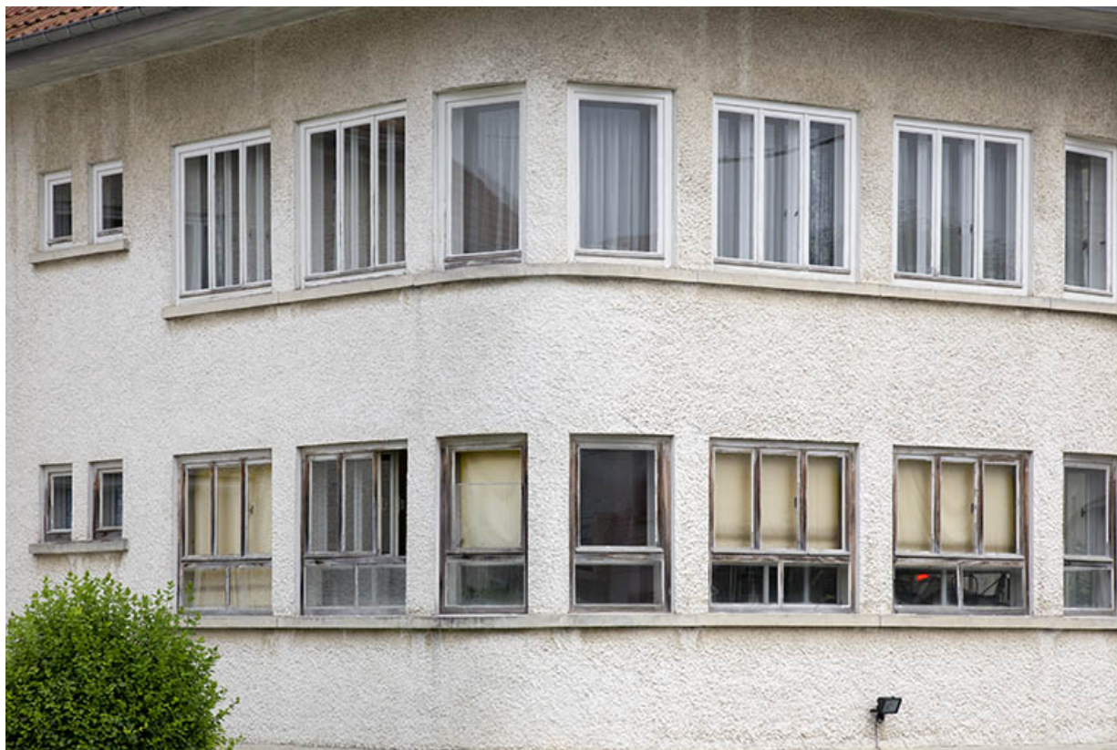
Fenêtres du corps de bâtiment de 1965.
