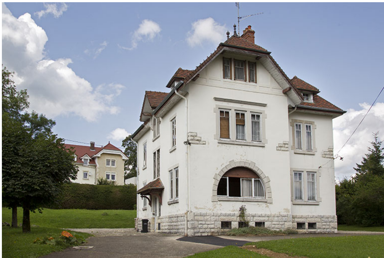
Façades antérieure et latérale gauche.
