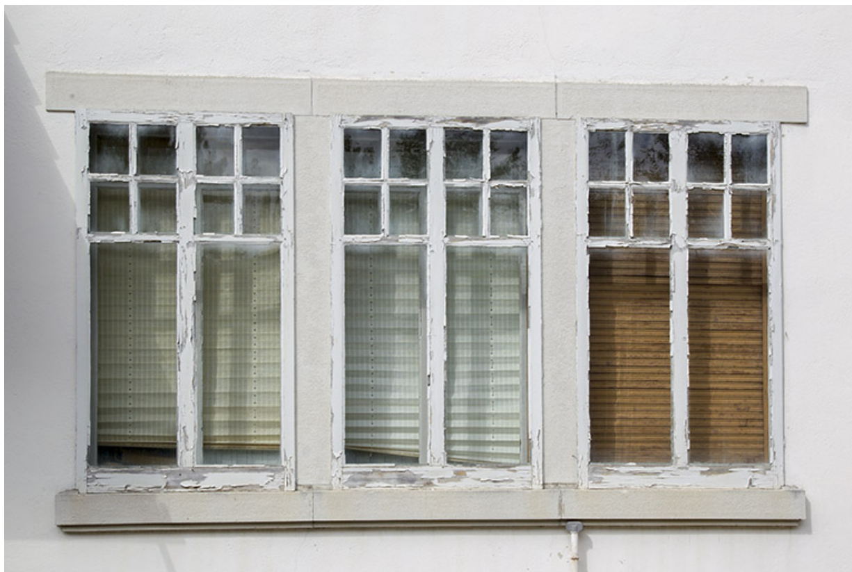
Façade latérale droite : fenêtres multiples.
