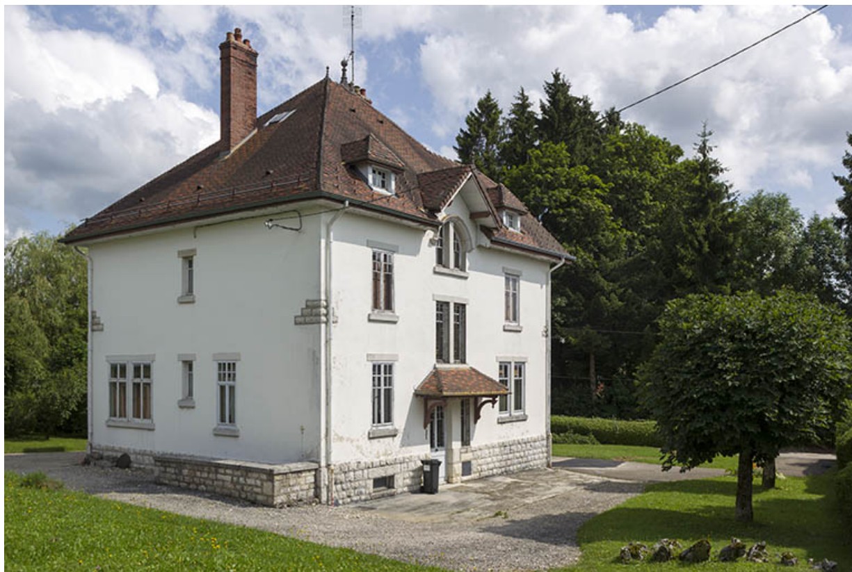
Façades postérieure et latérale gauche.
