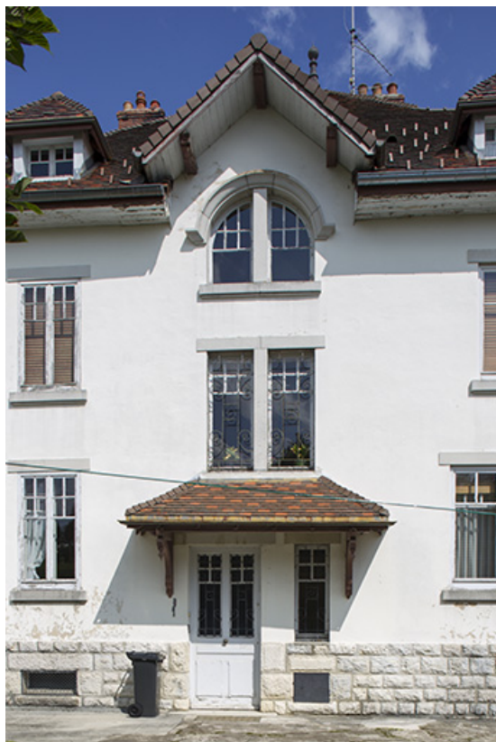
Façade latérale gauche : la travée centrale.
