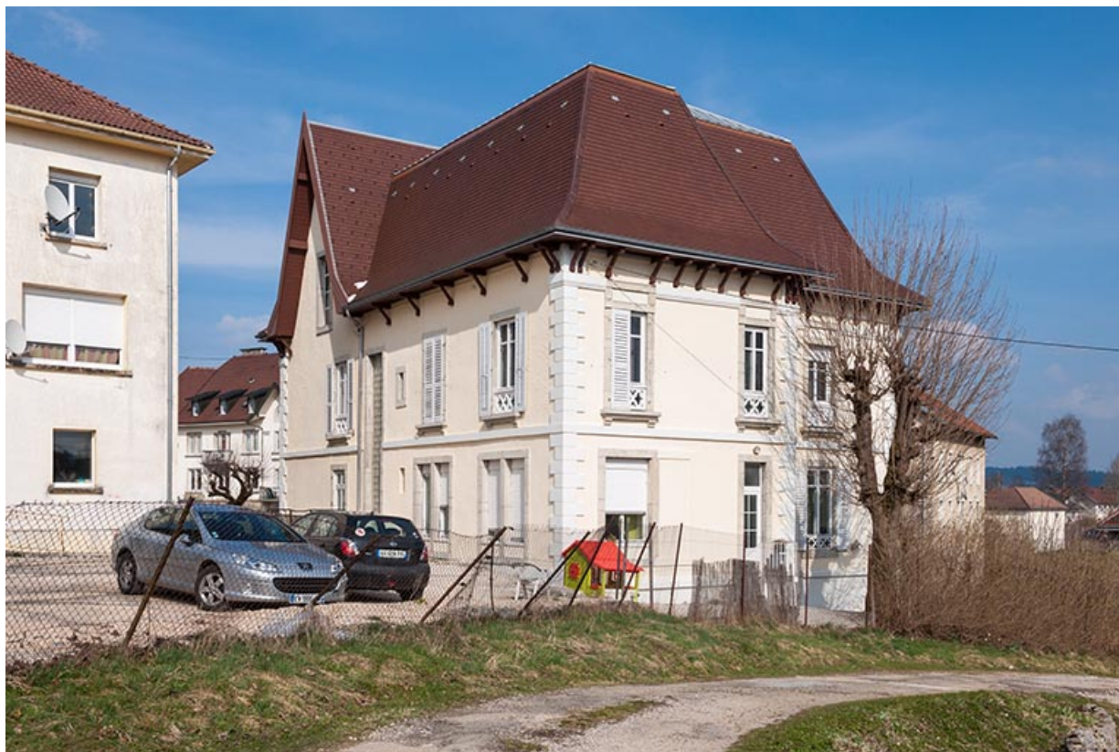
Logement patronal : façade postérieure, de trois quarts droite. 25, Charquemont, 28 Grande Rue
