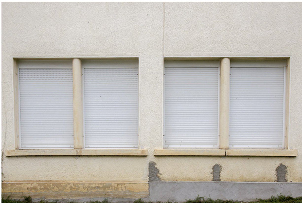
Usine : fenêtres horlogères de la façade antérieure.
