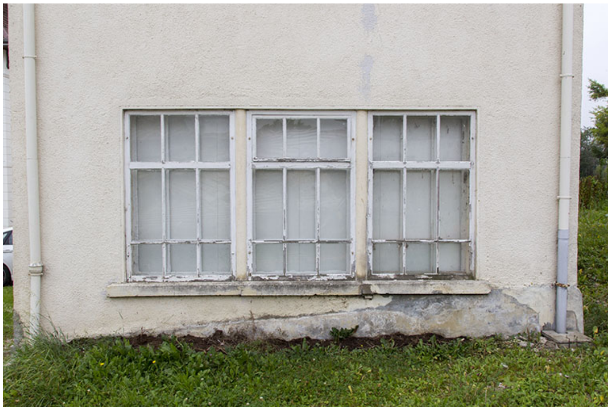
Usine : fenêtres multiples de la façade latérale droite.
