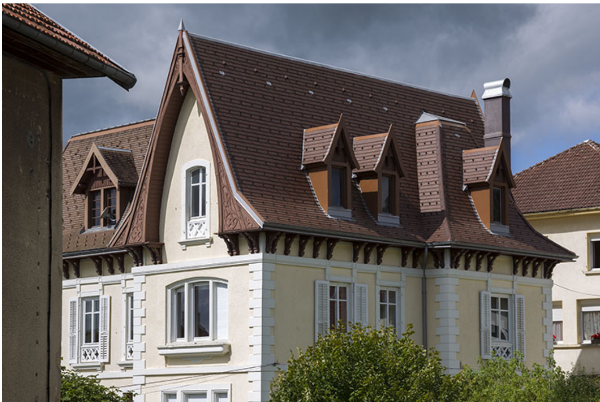
Logement patronal : étages supérieurs et toiture, vus de l'ouest. 25, Charquemont, 28 Grande Rue
