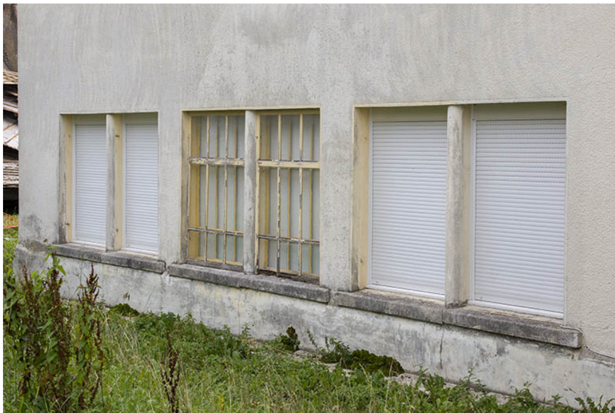
Usine : fenêtres horlogères de la façade postérieure.
