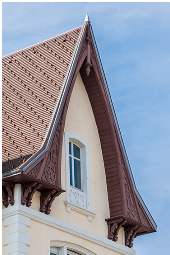
Logement patronal : pignon de la façade antérieure. 25, Charquemont, 28 Grande Rue
