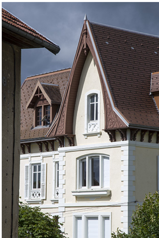
Logement patronal : étages supérieurs, toiture et pignon de la façade antérieure, vus de l'ouest. 25, Charquemont, 28 Grande Rue
