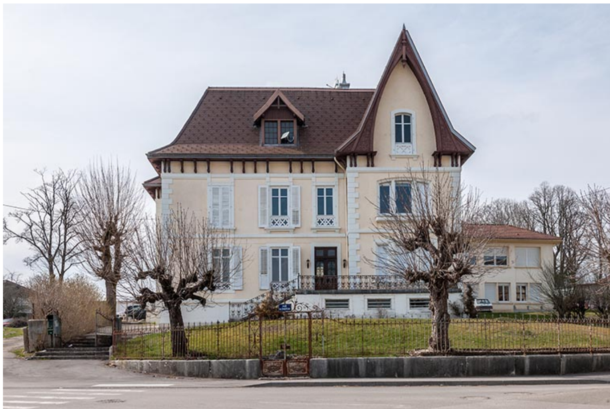
Logement patronal : façade antérieure.
