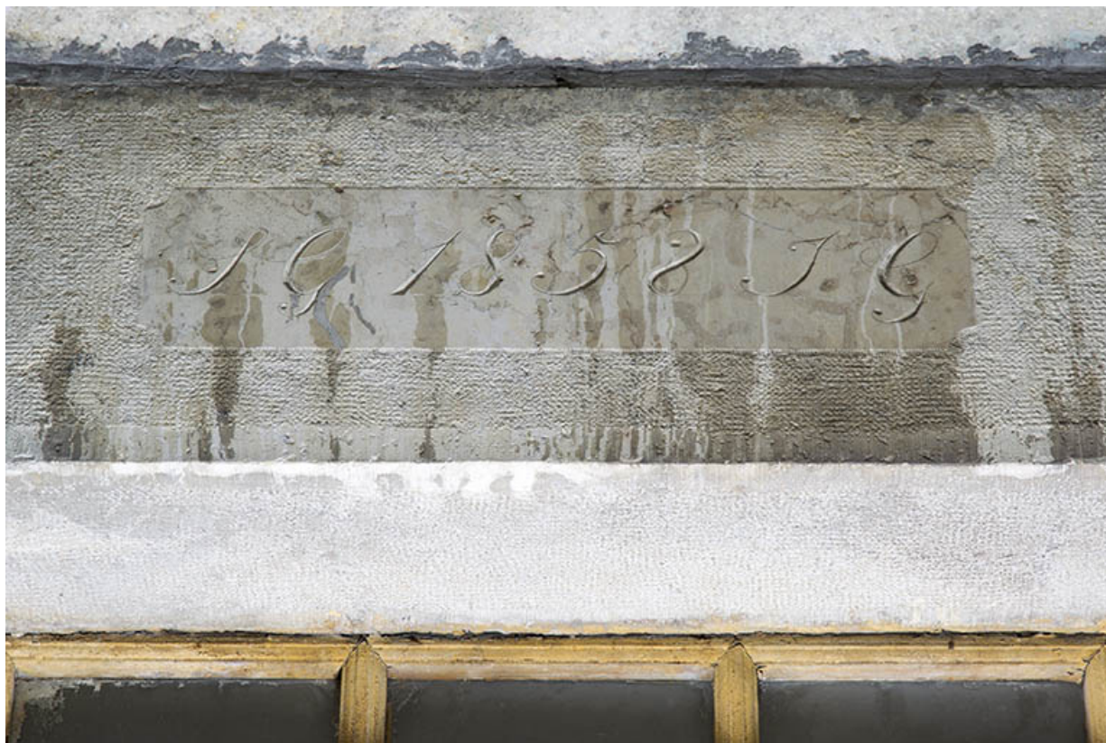
Façade antérieure : date et initiales sur le linteau de la porte.
