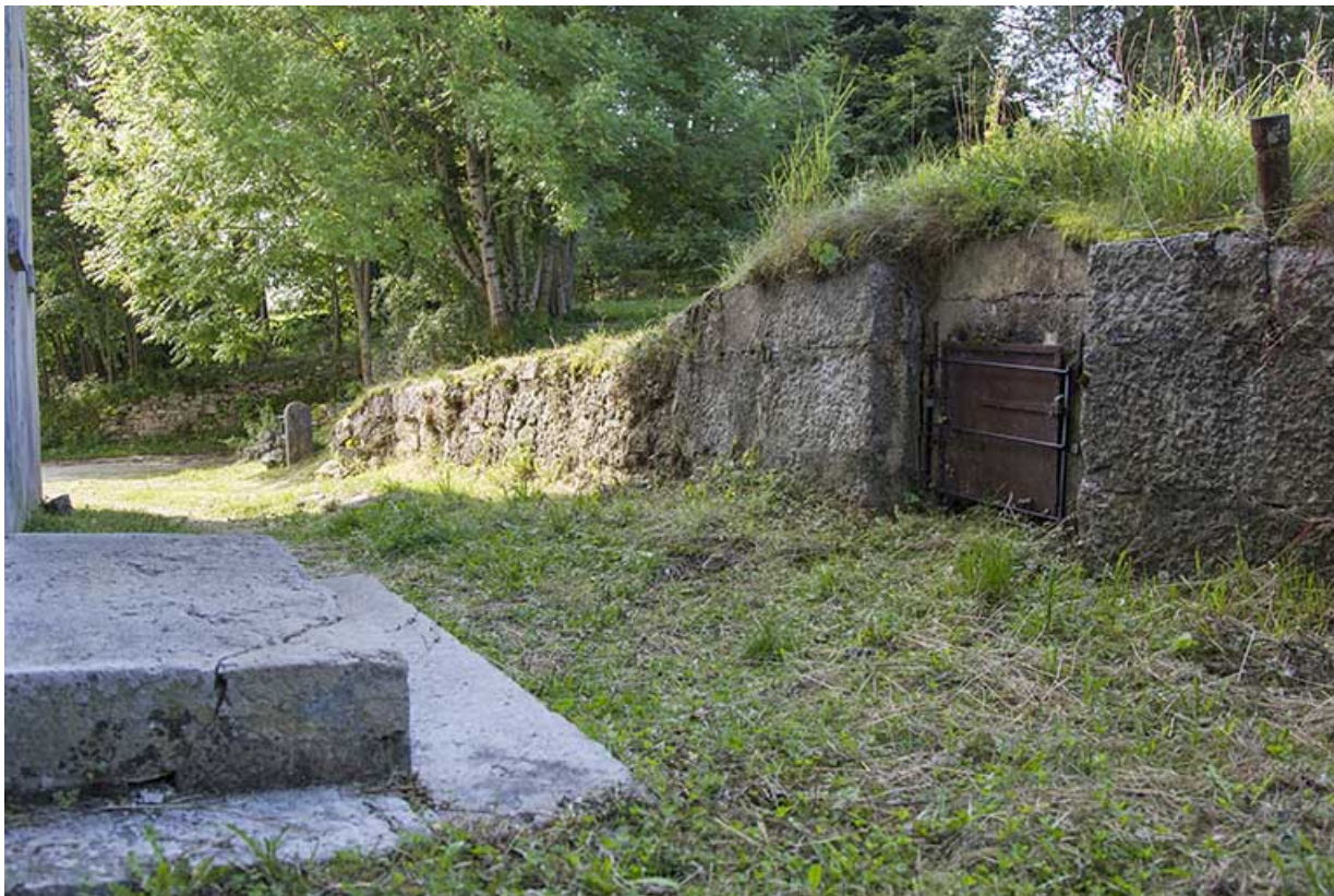
Citerne près de la façade postérieure.
