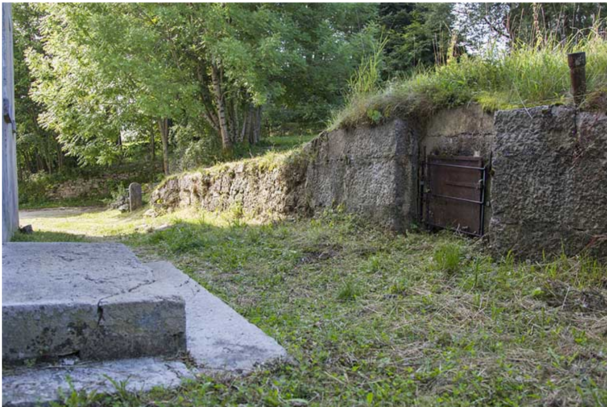
Citerne près de la façade postérieure.
