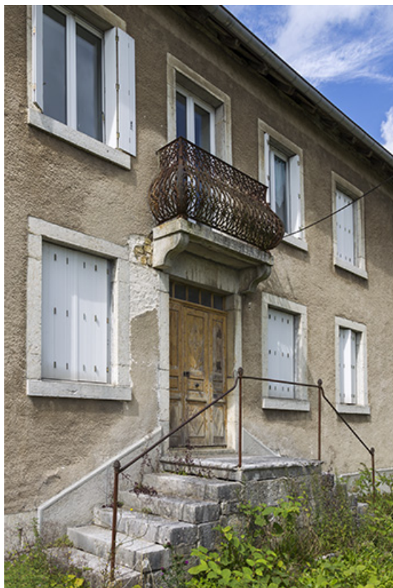
Façade antérieure : travées centrale et perron, vus en enfilade. 25, Charquemont, 18 Grande Rue
