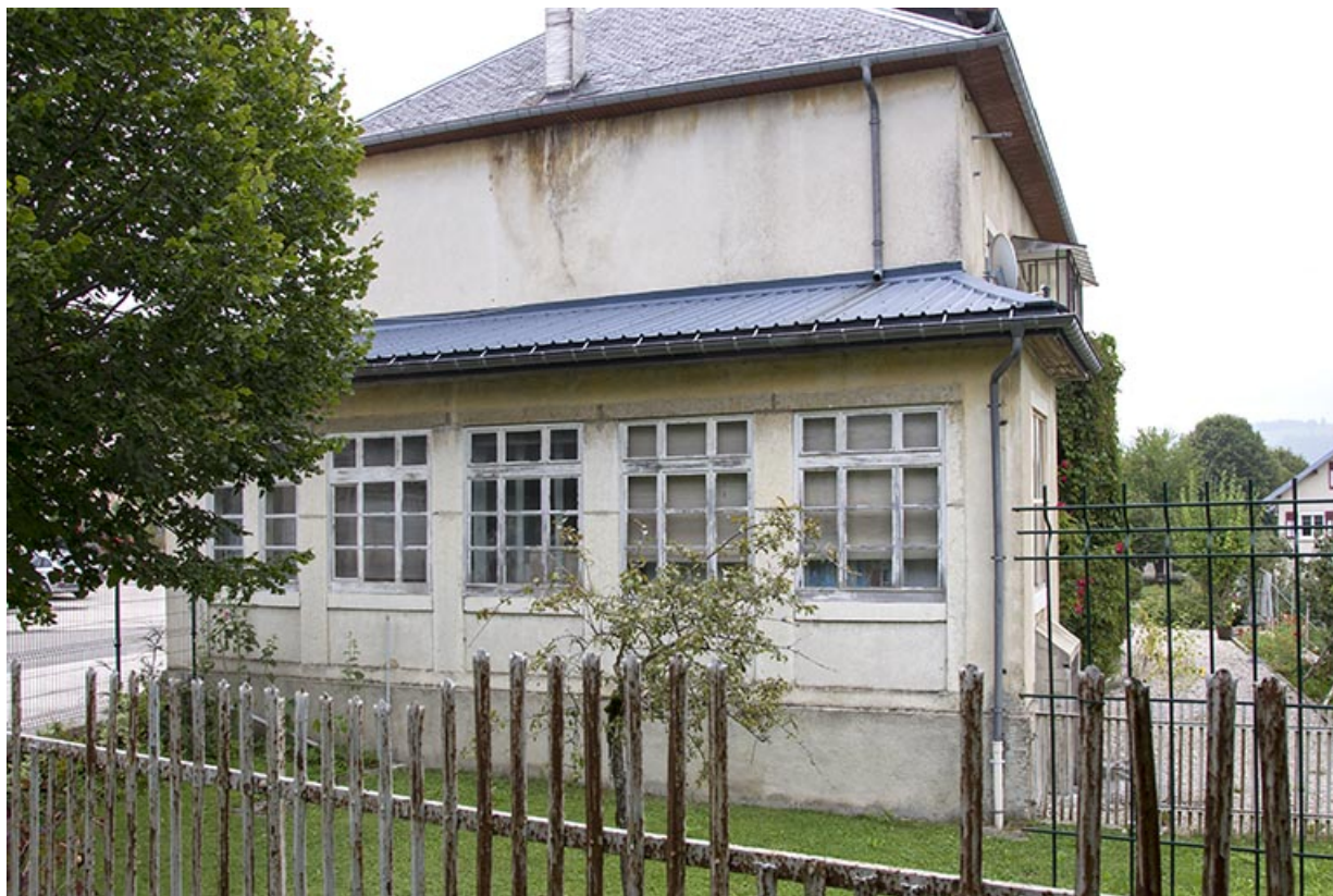
Atelier de fabrication sur la façade latérale droite.
