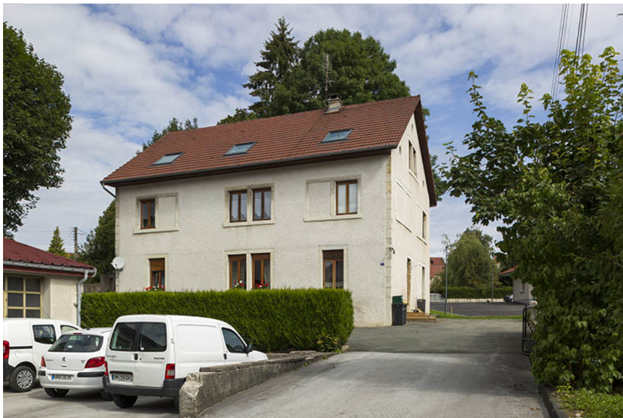
Usine : façade antérieure, de trois quarts droite.
