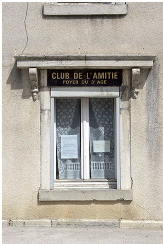
Logement patronal : fenêtre sur la façade antérieure.
