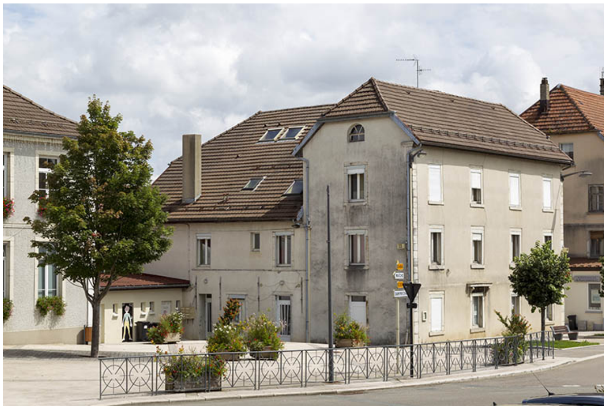
Vue d'ensemble du site, depuis l'ouest (logement patronal et bureau). 25, Charquemont
