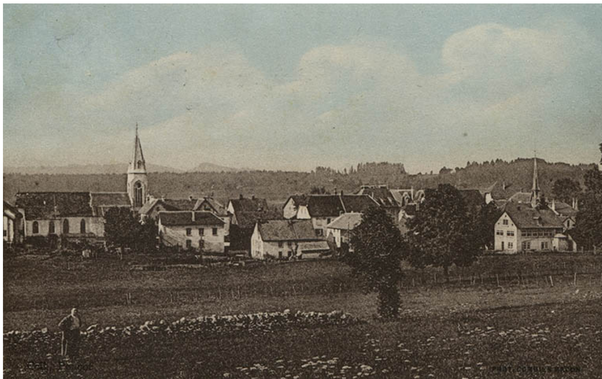
Charquemont (Doubs) - Vue générale [depuis le nord], 2e quart 20e siècle (entre 1932 et 1946). L'usine est visible à droite. 25, Charquemont, 2 et 3 place de l' Hôtel de Ville
