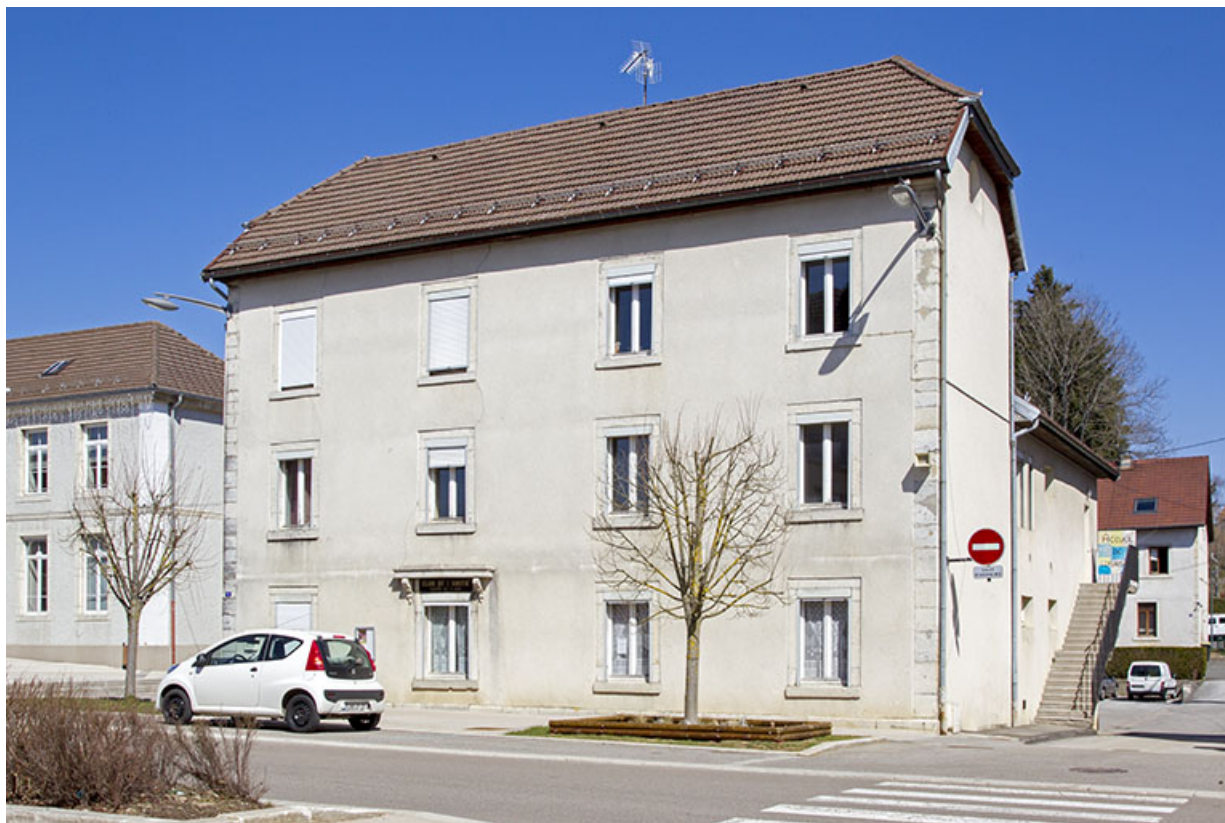
Logement patronal : façade antérieure, de trois quarts droite.
