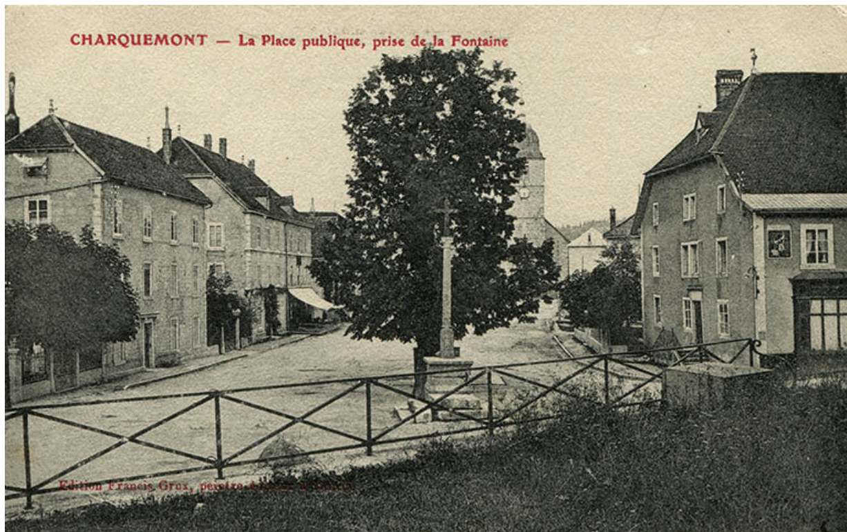
Charquemont - La place publique, prise de la fontaine, 1er quart 20e siècle (avant 1908).
