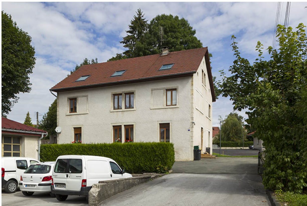
Usine : façade antérieure, de trois quarts droite.
