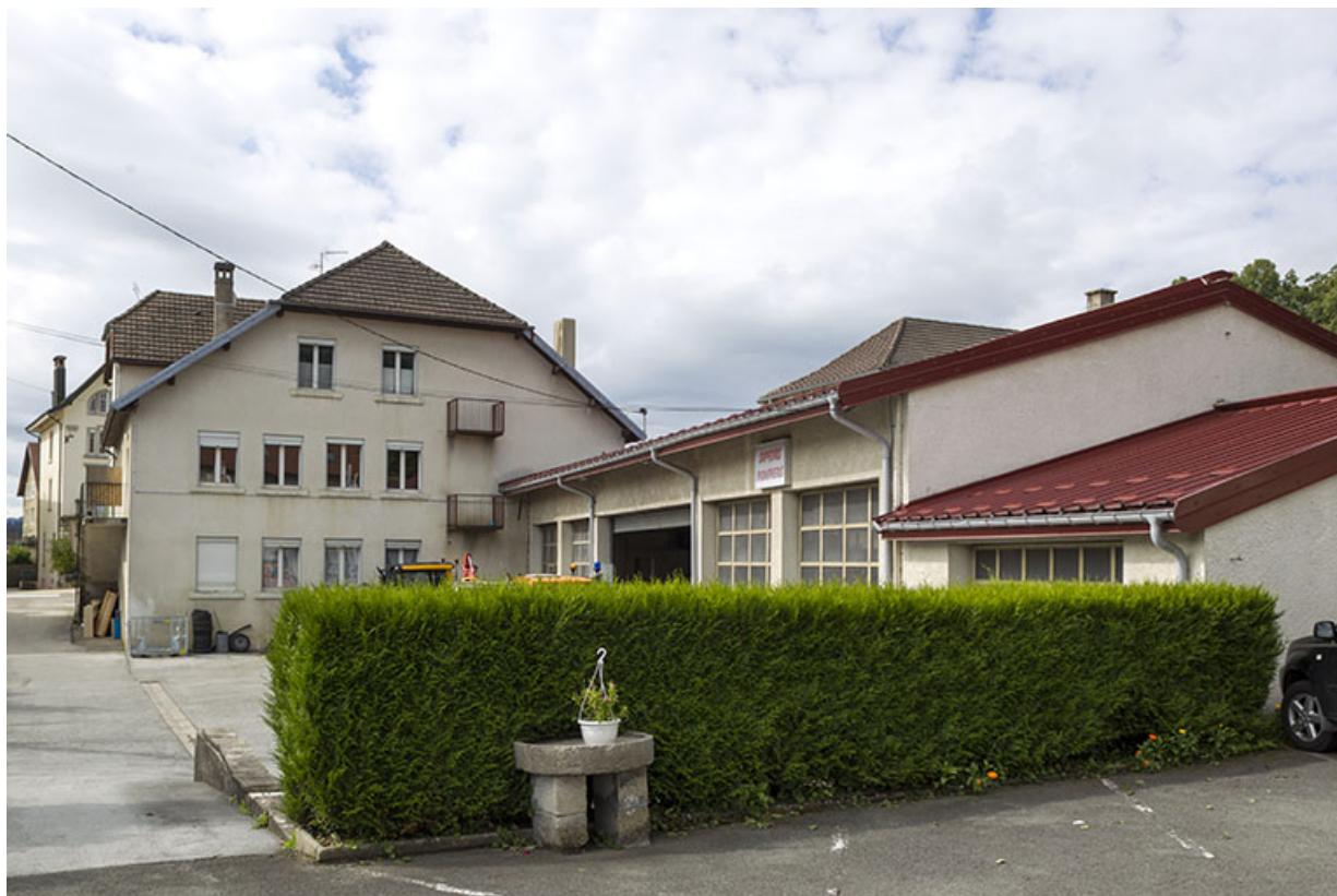
Logement patronal (façade postérieure) et ateliers municipaux, vus depuis l'usine.
