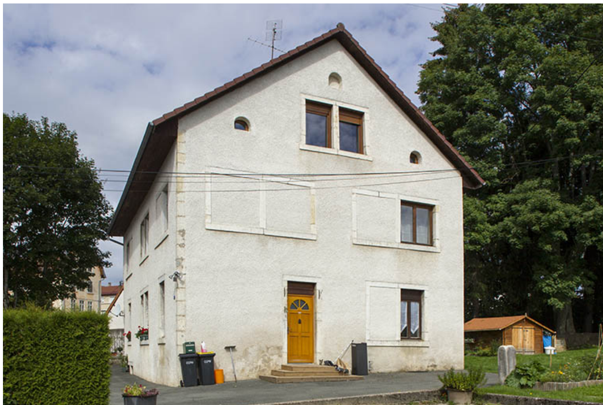
Usine : façade latérale droite, de trois quarts gauche.
