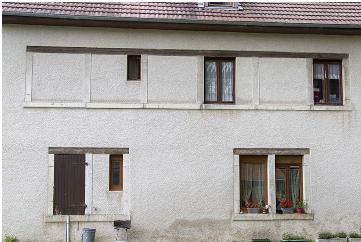
Usine : fenêtres horlogères au rez-de-chaussée et fenêtres multiples à l'étage (façade postérieure). 25, Charquemont, 2 et 3 place de l' Hôtel de Ville
