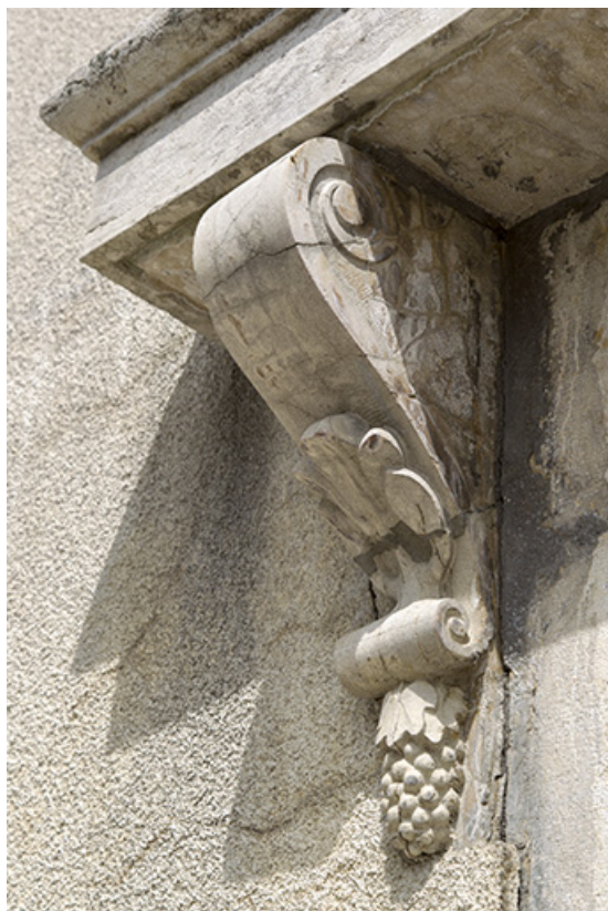
Logement patronal : console soutenant le dessus-de-fenêtre (façade antérieure). 25, Charquemont, 2 et 3 place de l' Hôtel de Ville
