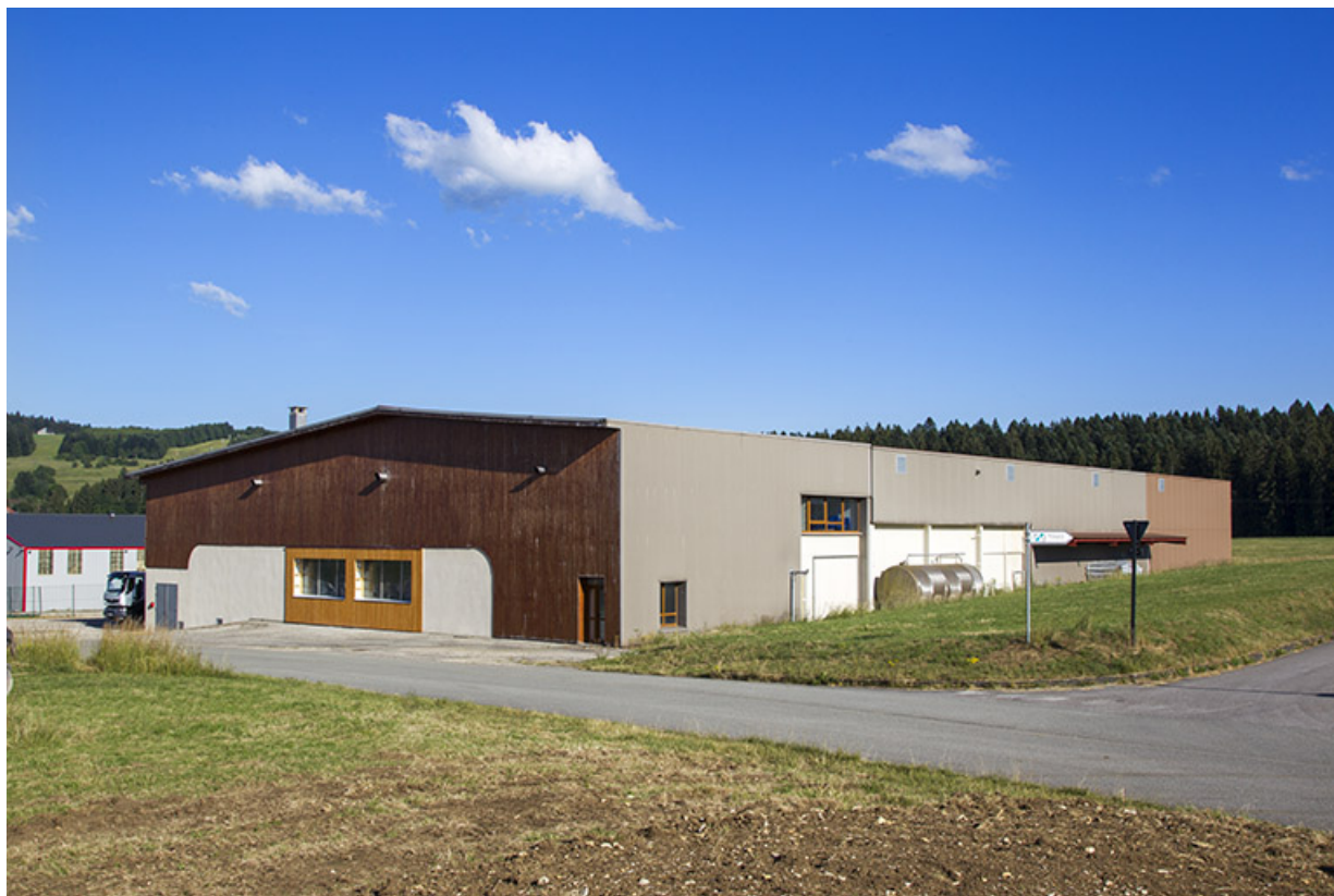
Vue d'ensemble, depuis le nord-ouest.
