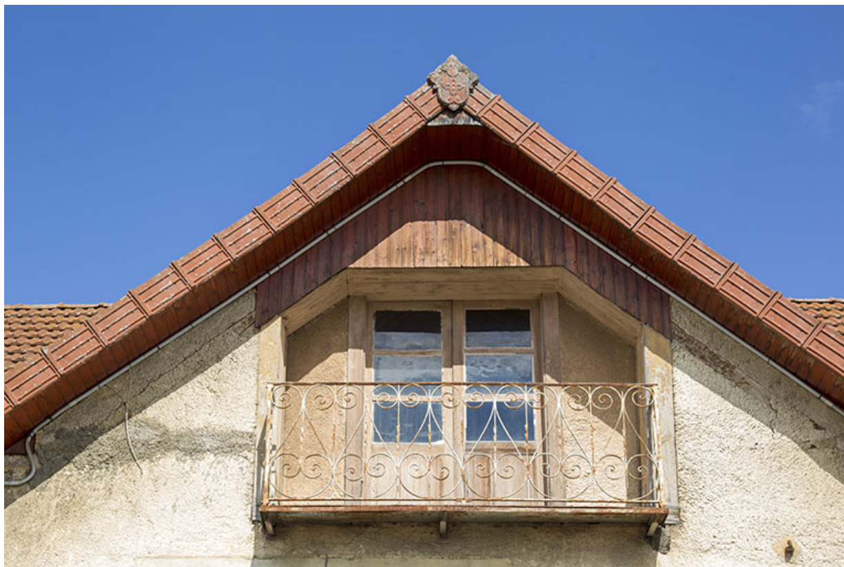
Façade antérieure : lucarne-pignon de l'étage en surcroît.
