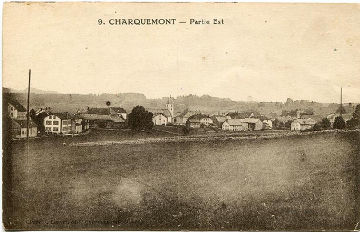
9. Charquemont - Partie Est, 1er quart 20e siècle. L'usine est visible à droite. 25, Charquemont, 11 rue de l' Eglise
