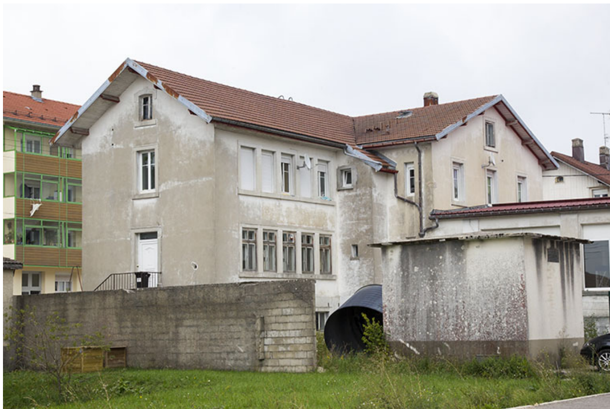
Façades postérieure et latérale droite.
