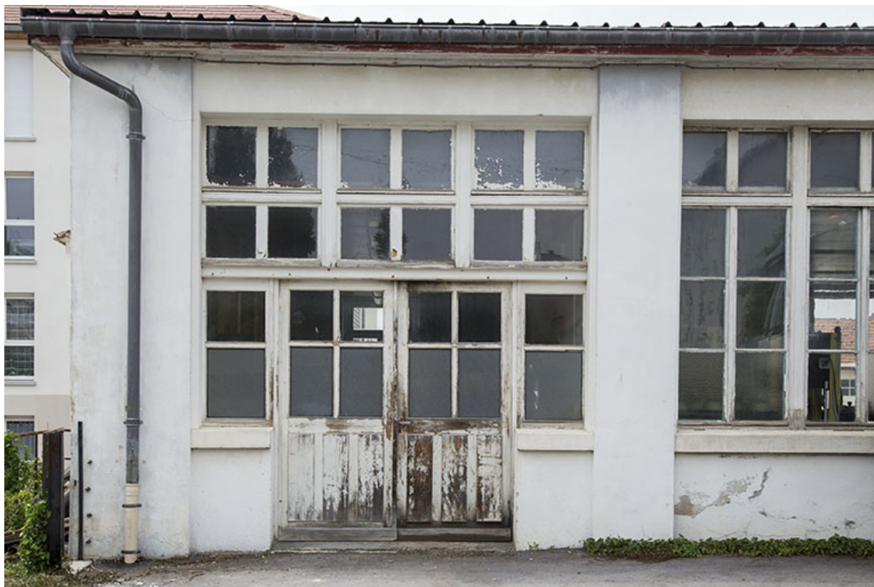
Extension : dernière travée sur la rue Pasteur.
