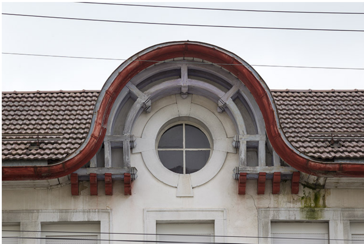
Façade antérieure : oculus éclairant le comble.
