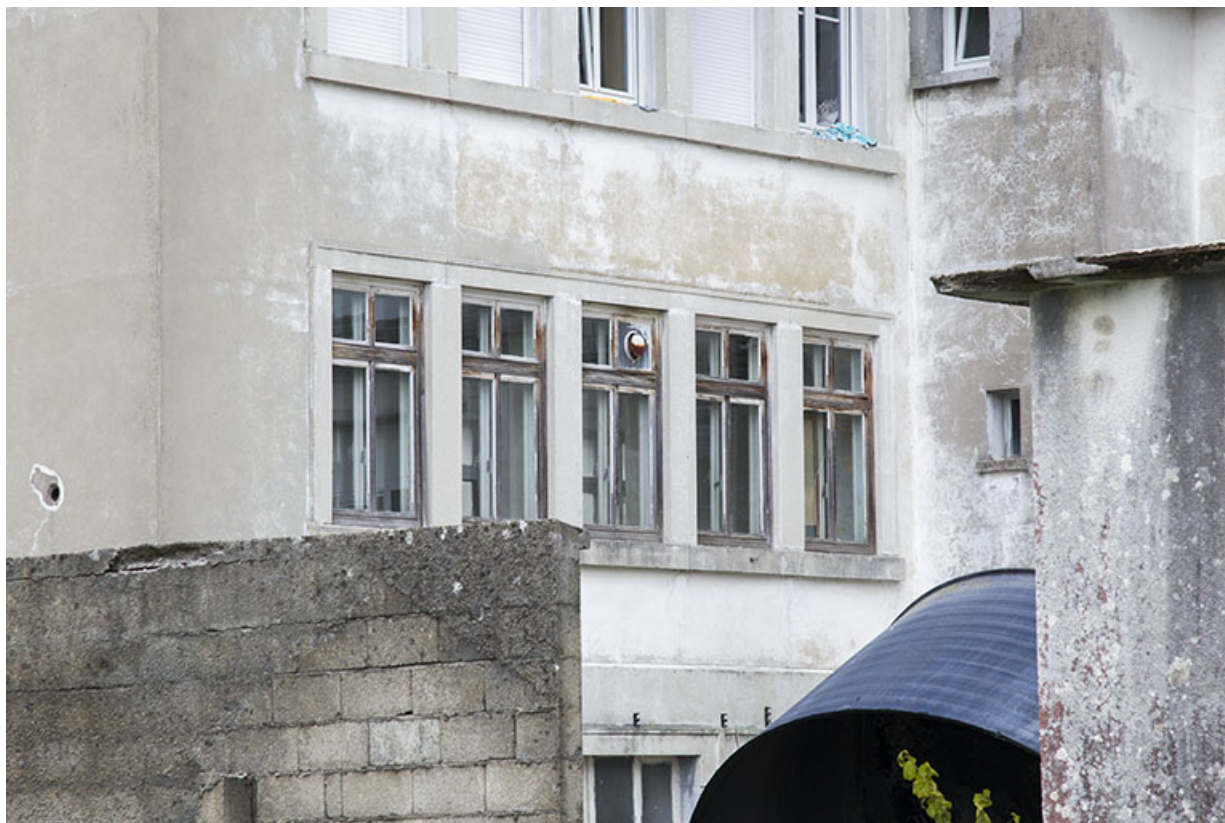
Façade postérieure : fenêtres multiples, vues de trois quarts.
