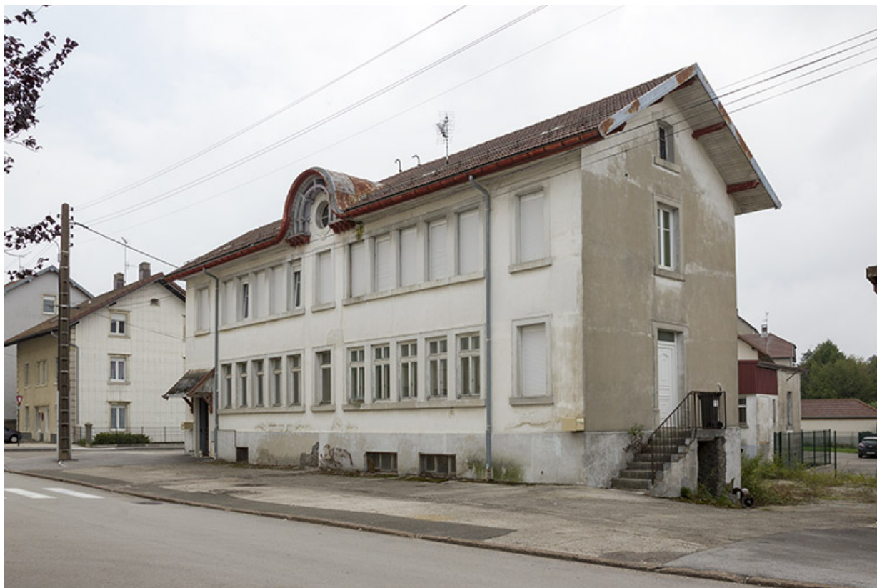
Façades antérieure et latérale droite.
