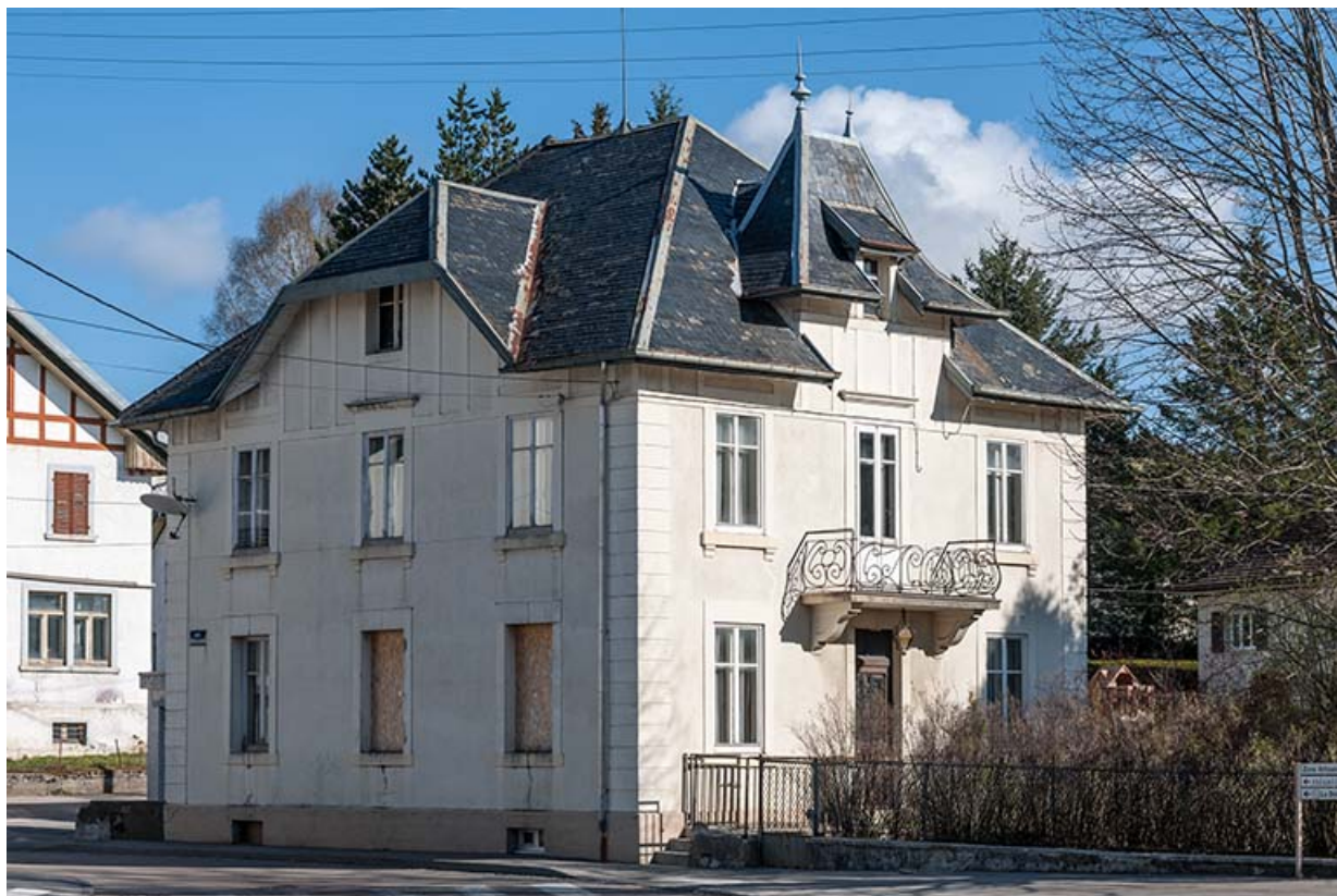
Premier bâtiment (logement patronal) au 2 rue Victor Hugo, vu du sud. 25, Charquemont, 1-5 rue Victor Hugo
