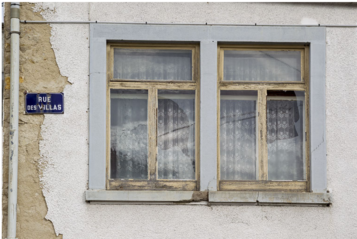
Deuxième bâtiment, au 4 rue Victor Hugo : fenêtre horlogère sur la façade antérieure. 25, Charquemont, 1-5 rue Victor Hugo
