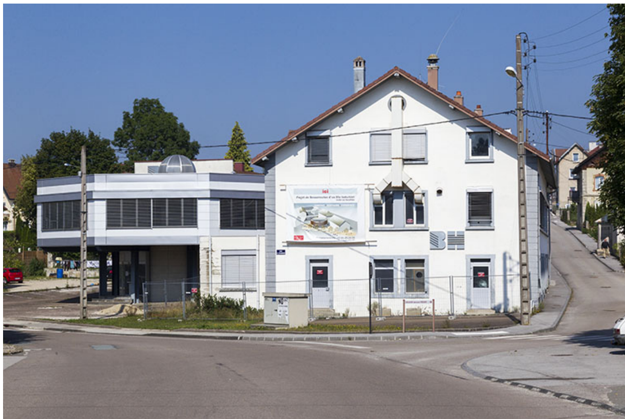
Corps d'entrée et usine, vus de l'est.
