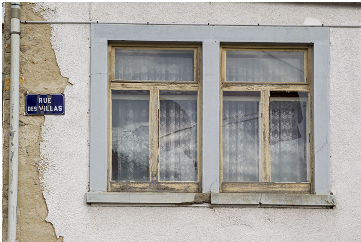
Deuxième bâtiment, au 4 rue Victor Hugo : fenêtre horlogère sur la façade antérieure. 25, Charquemont, 1-5 rue Victor Hugo
