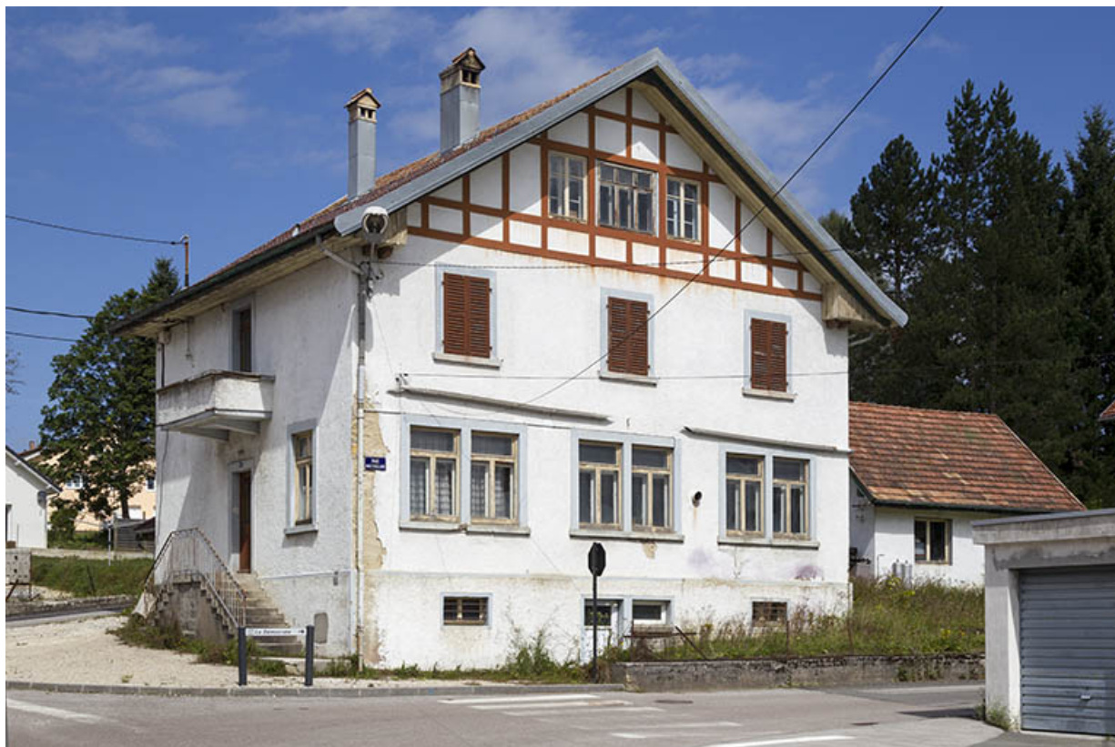
Deuxième bâtiment (logement et atelier de fabrication) au 4 rue Victor Hugo : façades antérieure et latérale gauche. 25, Charquemont, 1-5 rue Victor Hugo
