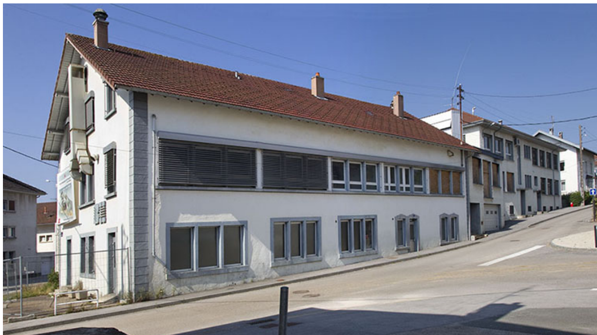
Usine : vue d'ensemble des façades antérieures, sur la rue Victor Hugo. 25, Charquemont, 1-5 rue Victor Hugo
