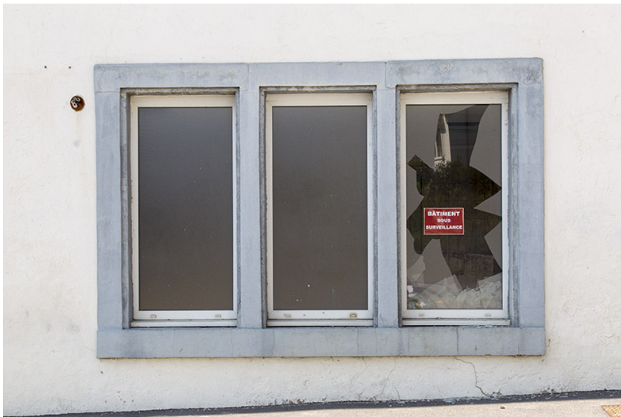
Usine, 1er corps de bâtiment : fenêtre multiple sur la façade antérieure. 25, Charquemont, 1-5 rue Victor Hugo
