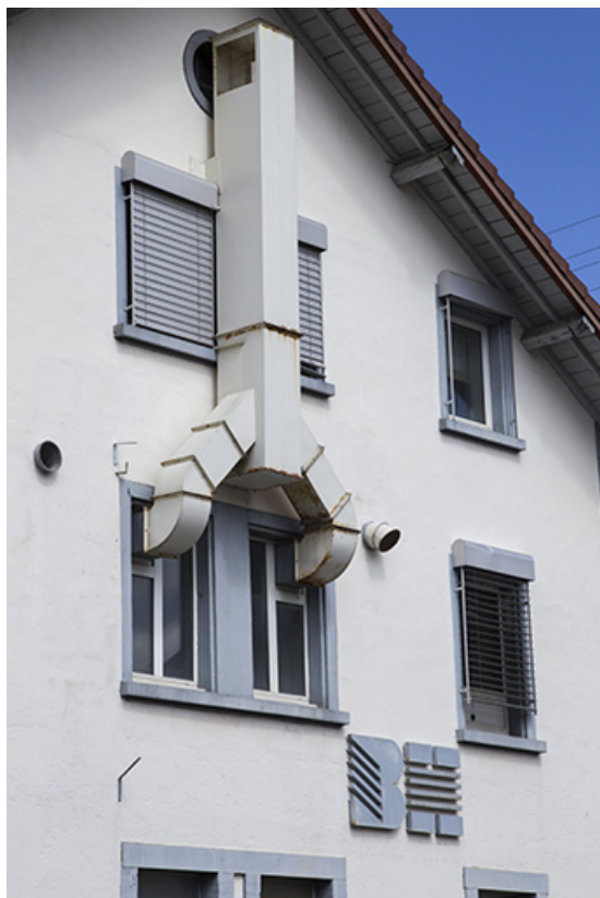
Usine, 1er corps de bâtiment : fenêtres horlogères, installation de ventilation et logotype, sur la façade latérale gauche. 25, Charquemont, 1-5 rue Victor Hugo
