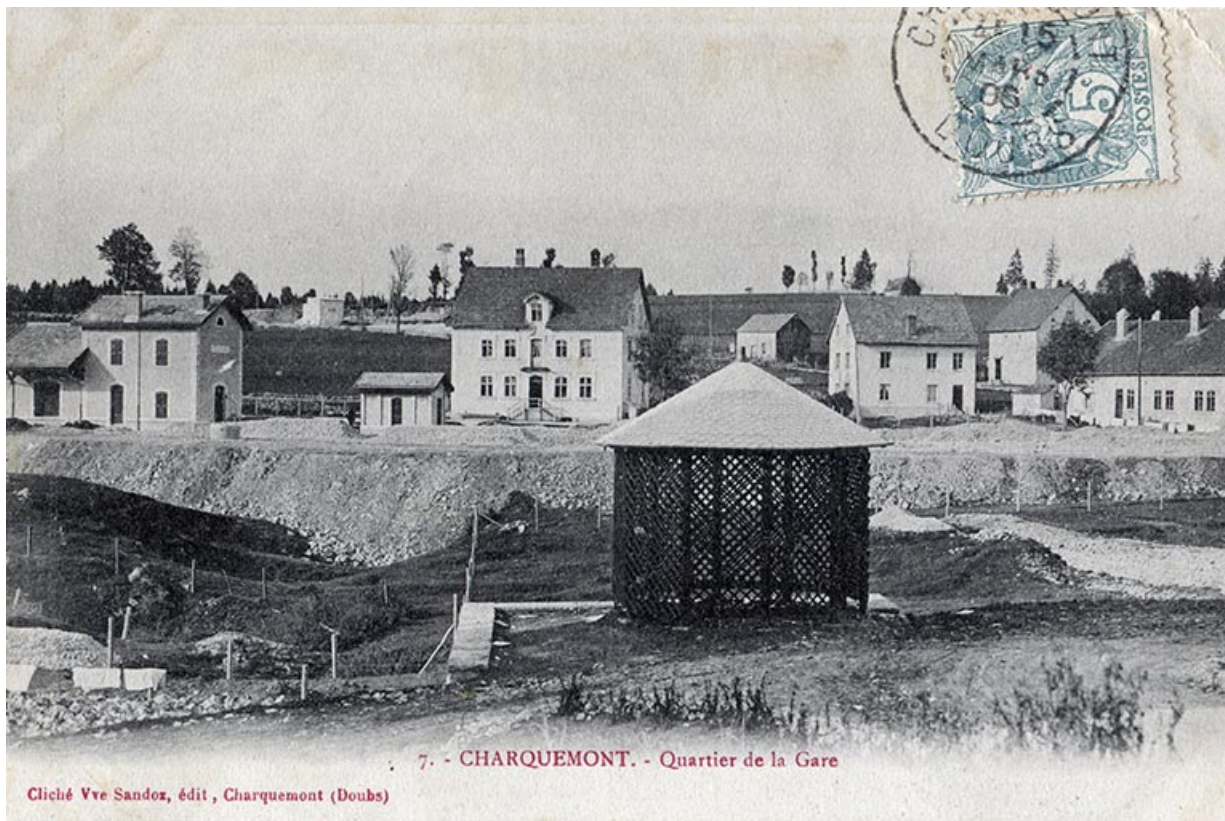
7. - Charquemont. - Quartier de la Gare [avec la voie ferrée en construction], entre 1900 et 1906. La maison dans la cour et l'ancienne ferme sont visibles à droite de la tonnelle.
