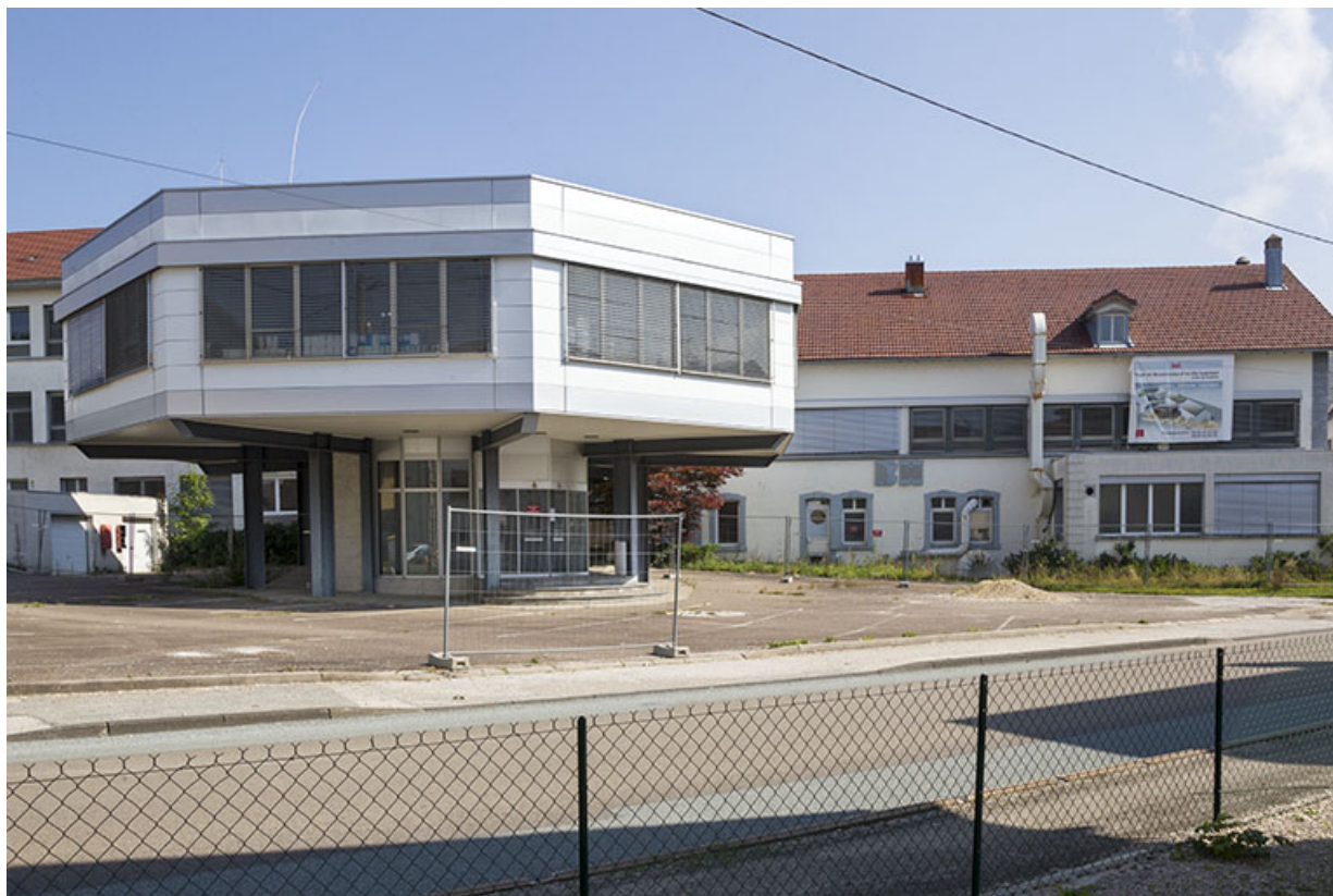
Usine, 1er corps de bâtiment : façade postérieure. Au 1er plan, le corps d'entrée. 25, Charquemont, 1-5 rue Victor Hugo
