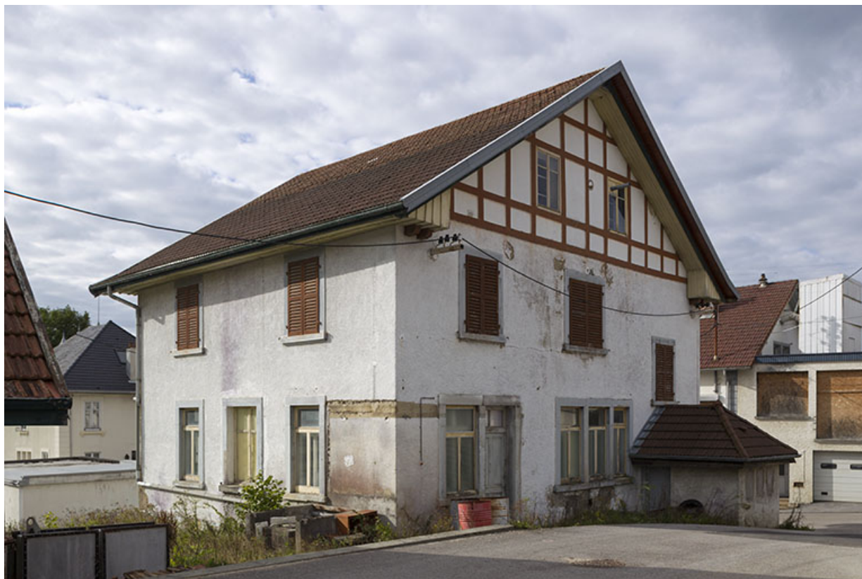
Deuxième bâtiment, au 4 rue Victor Hugo : façades postérieure et latérale droite. 25, Charquemont, 1-5 rue Victor Hugo
