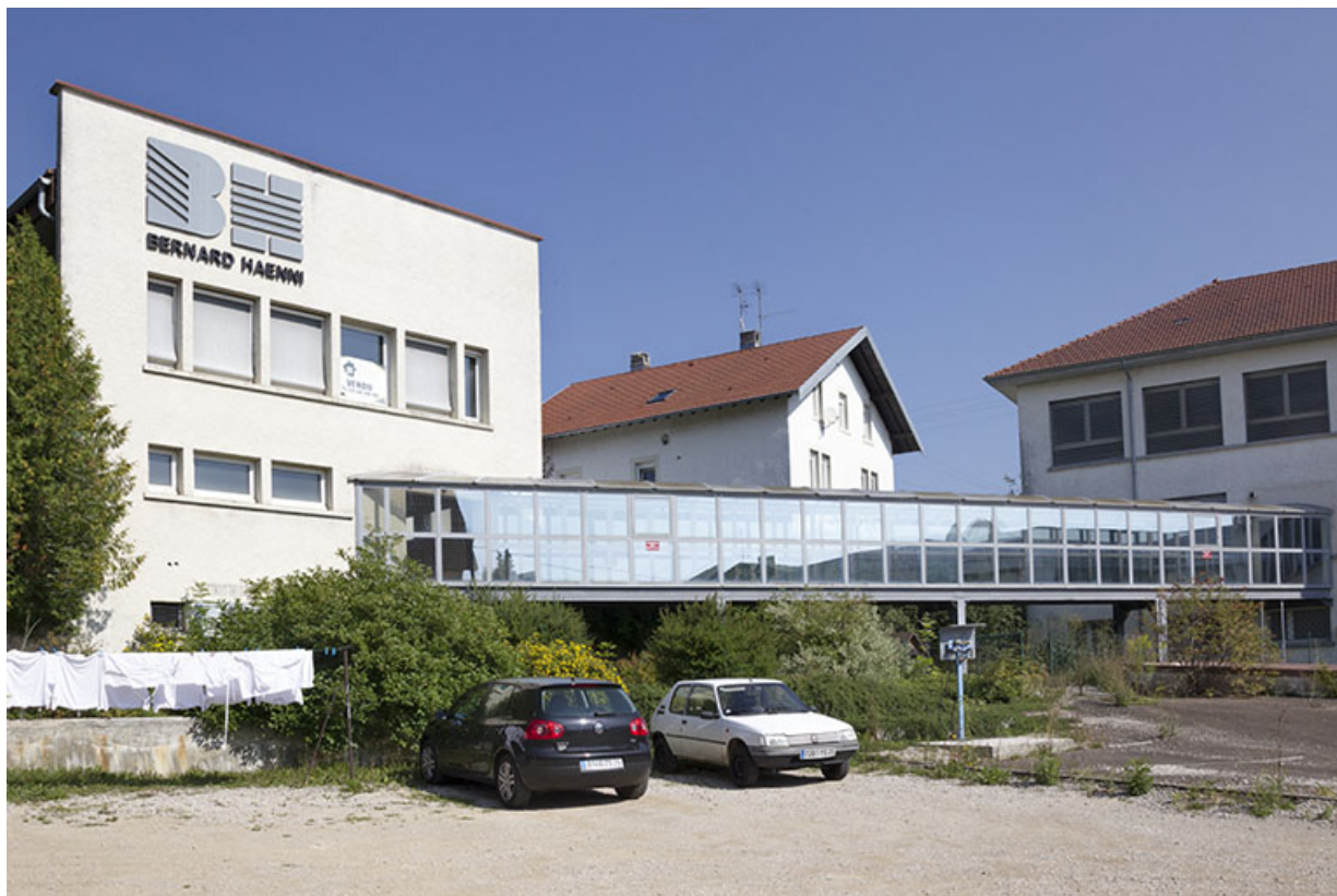
Usine, 2e corps de bâtiment (extrémité de la façade postérieure à droite) et passerelle de liaison avec l'ancien site Léon-Georges Petit.
