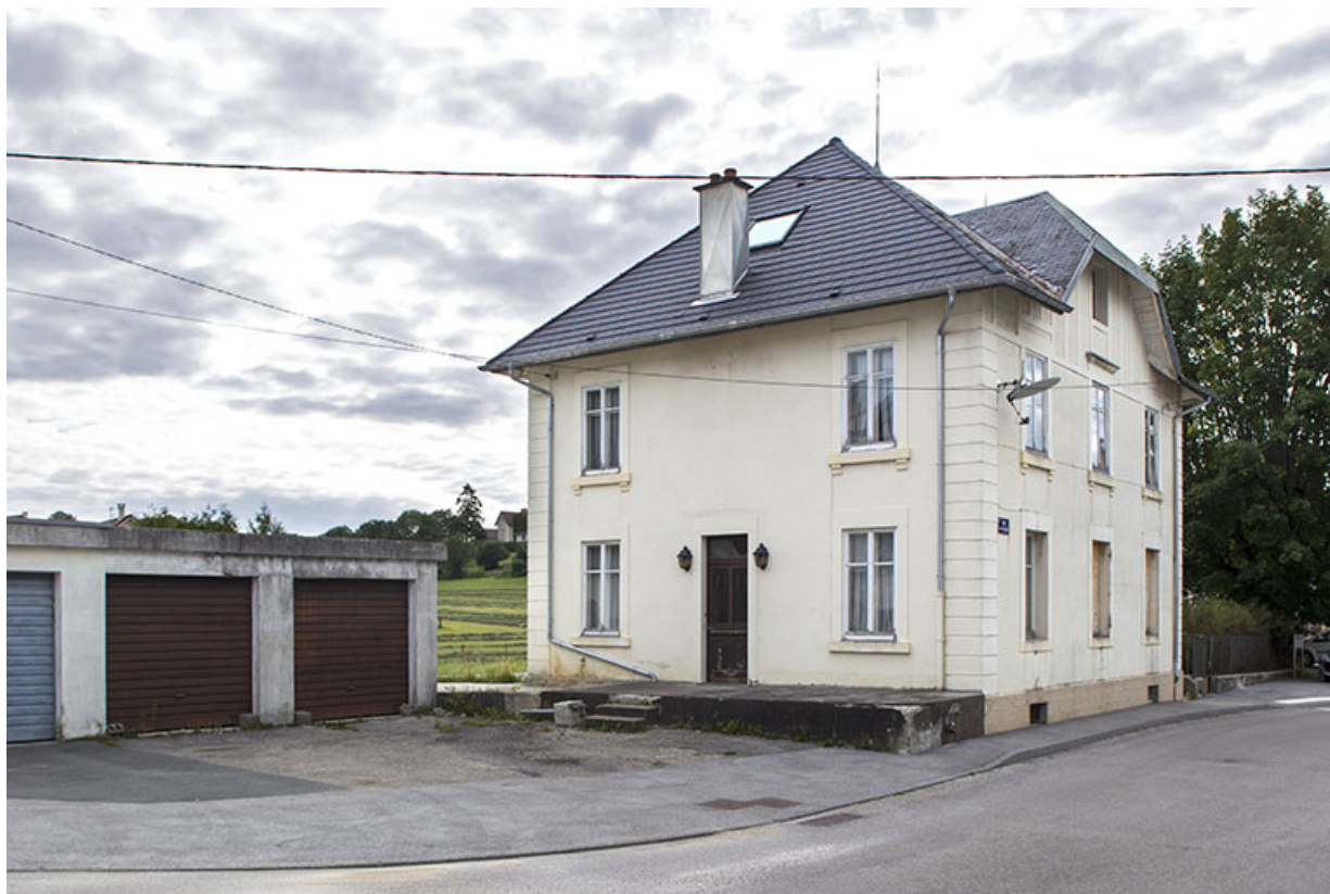
Premier bâtiment, au 2 rue Victor Hugo, vu du nord-ouest. 25, Charquemont, 1-5 rue Victor Hugo
