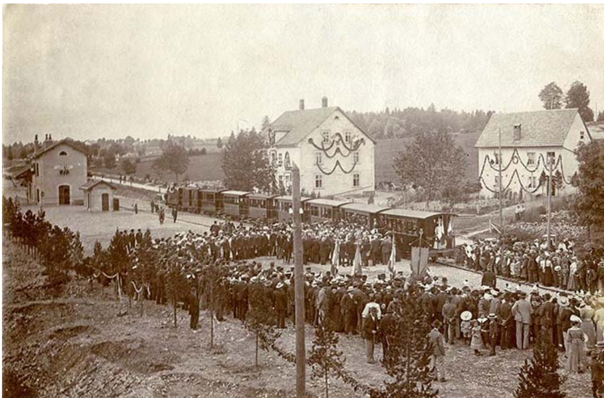
[Inauguration de la gare de Charquemont], 11 août 1905. La maison à droite est celle qui fut détruite durant la décennie 1990. 25, Charquemont, 1-5 rue Victor Hugo
