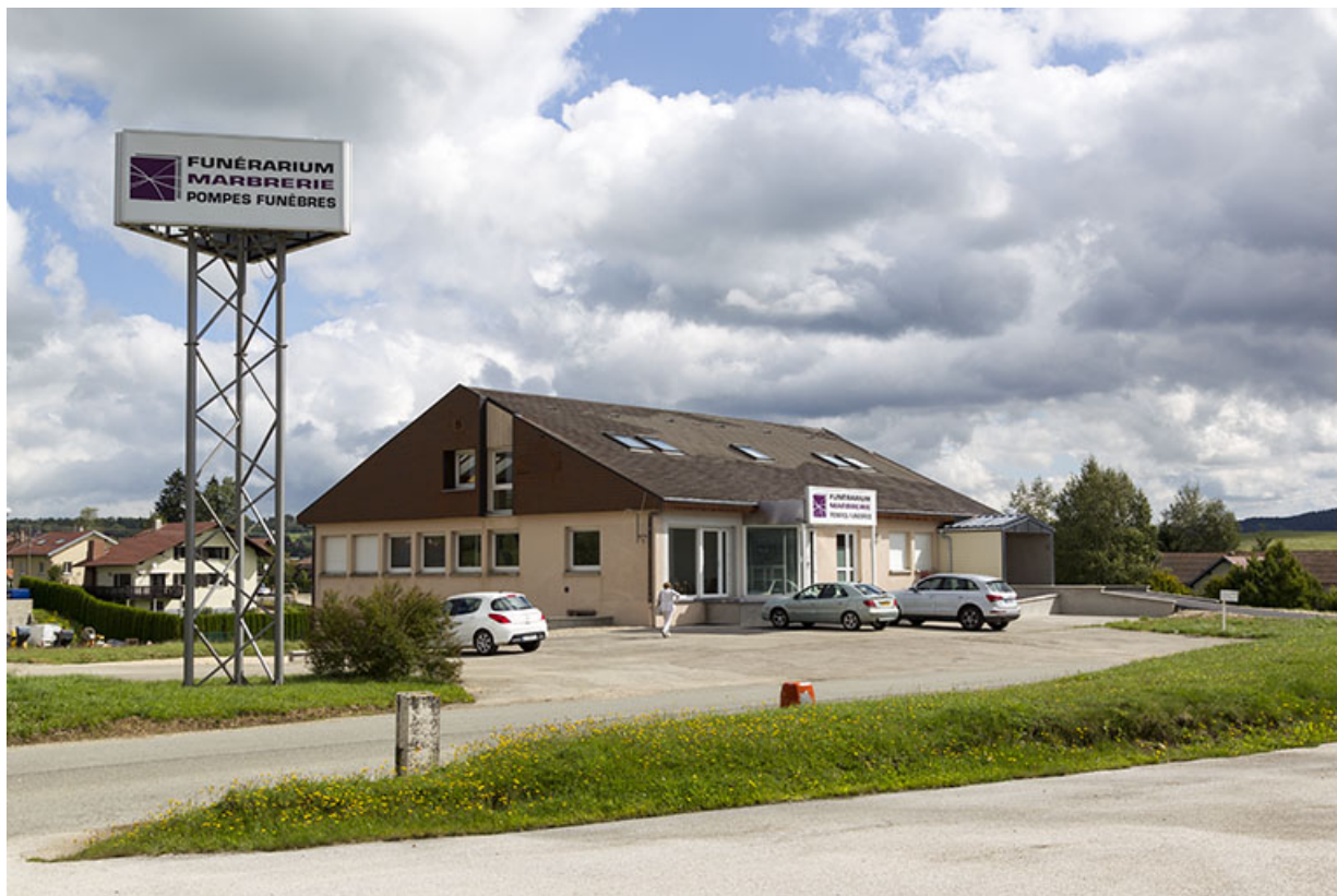
Vue d'ensemble, depuis le sud-ouest (façades antérieure et latérale gauche). 25, Charquemont, 3 rue Pierre Mendès-France
