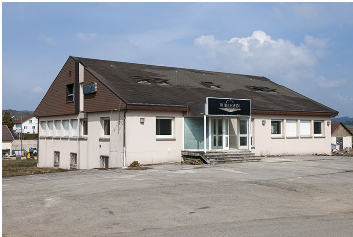
Vue d'ensemble depuis le sud-ouest, début 2014 (avant la transformation en funérarium). 25, Charquemont, 3 rue Pierre Mendès-France
