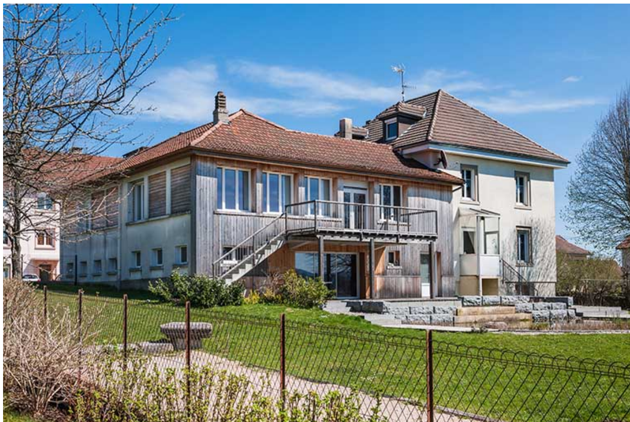
Usine : façades postérieure et latérale droite.
