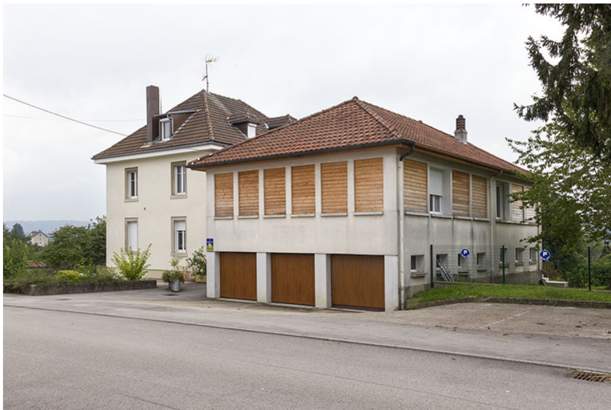
Usine : façades antérieure et latérale droite.
