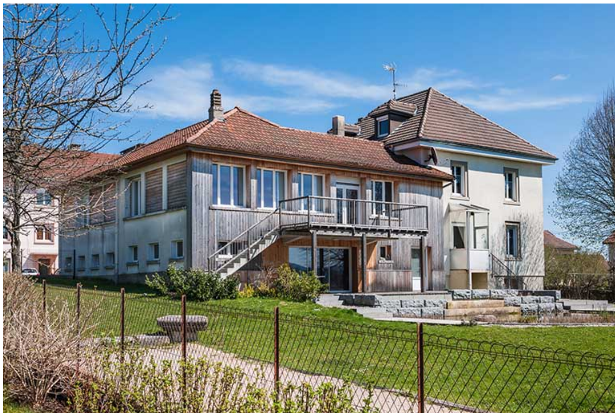
Usine : façades postérieure et latérale droite.
