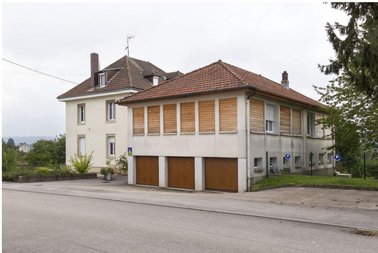
Usine : façades antérieure et latérale droite.
