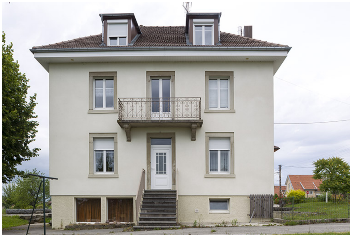
Logement patronal : façade latérale droite.
