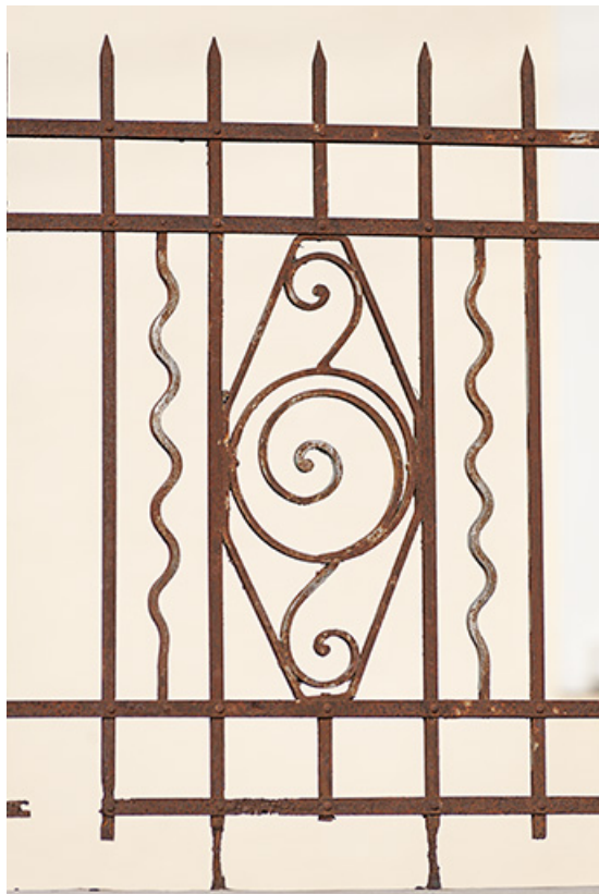
Motif de la grille de clôture.
