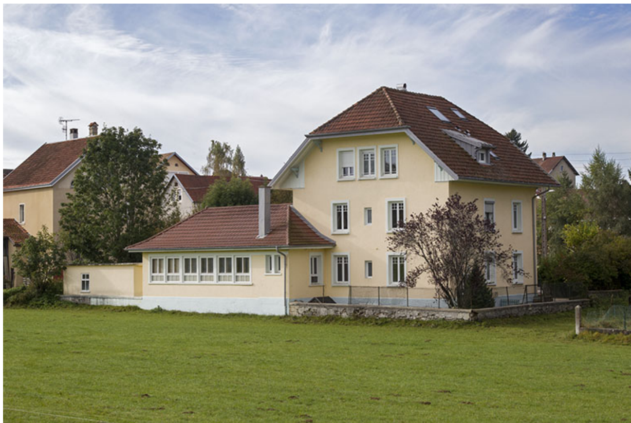
Vue d'ensemble, depuis le nord (façades postérieure et latérale gauche). 25, Charquemont, 1 Grande Rue
