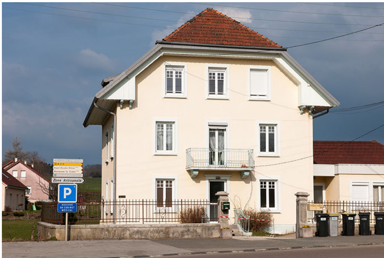
Façade antérieure du logement patronal.
