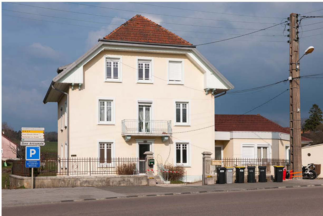
Vue d'ensemble, depuis l'ouest (façade antérieure).
