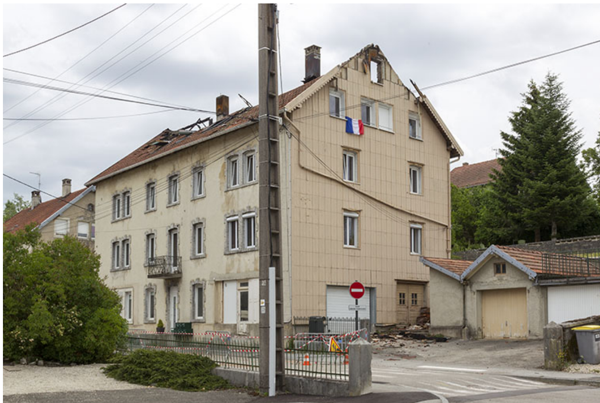
Vue d'ensemble, depuis l'ouest (façades antérieure et latérale droite). 25, Charquemont, 5 Rue Neuve
