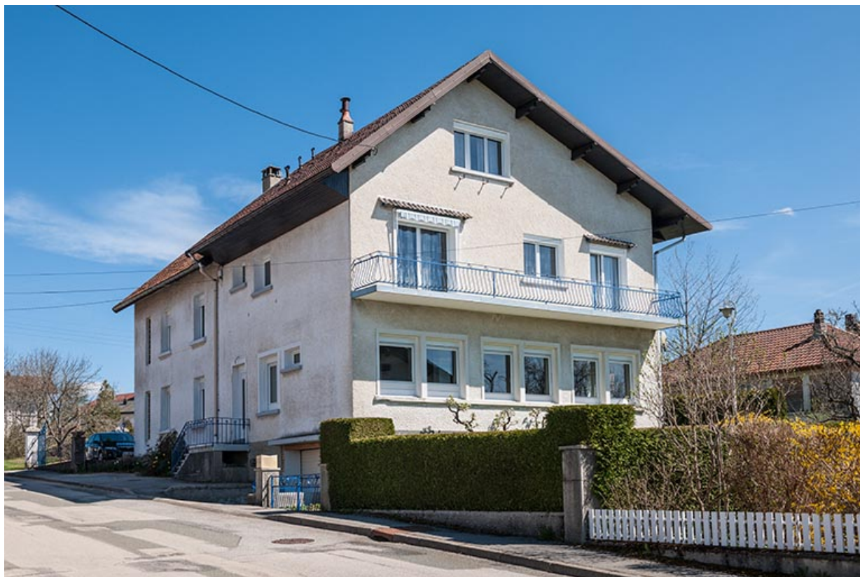
Façade antérieure, de trois quarts droite. Bâtiment d'origine à gauche, extension à droite (montrant les fenêtres horlogères de l'atelier).
