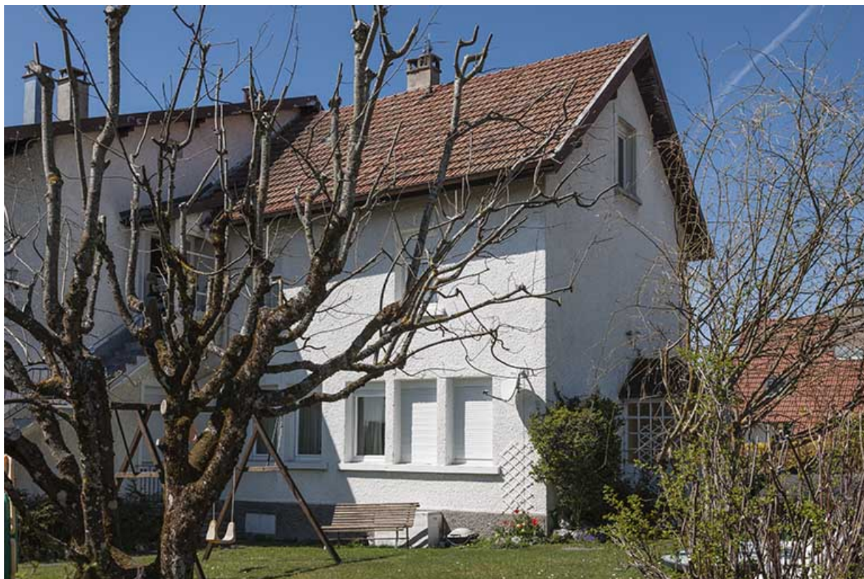
Façade postérieure du bâtiment d'origine (ouverte de fenêtres multiples), de trois quarts droite. 25, Charquemont, 21 rue Victor Hugo
