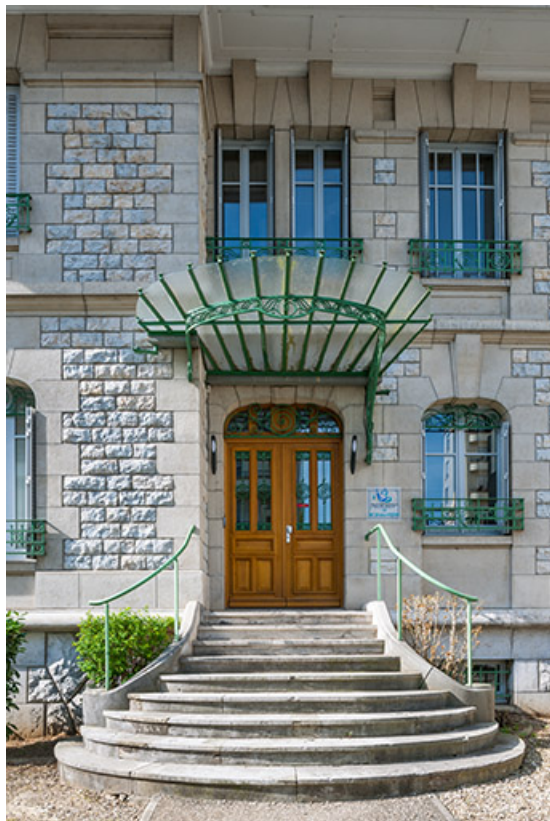
Façade antérieure : perron, entrée et marquise.
