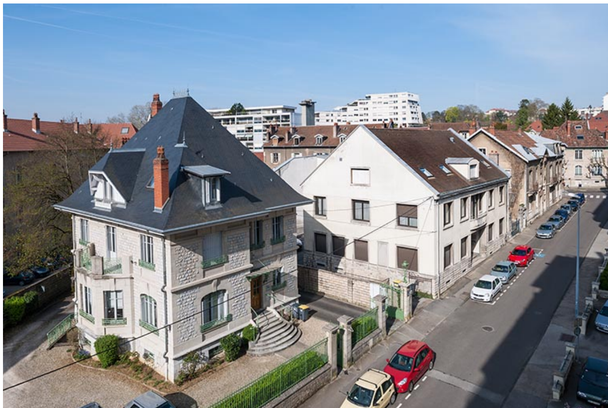
Vue d'ensemble plongeante, depuis l'est. 25, Besançon, 1 ter et 3 rue Victor Delavelle
