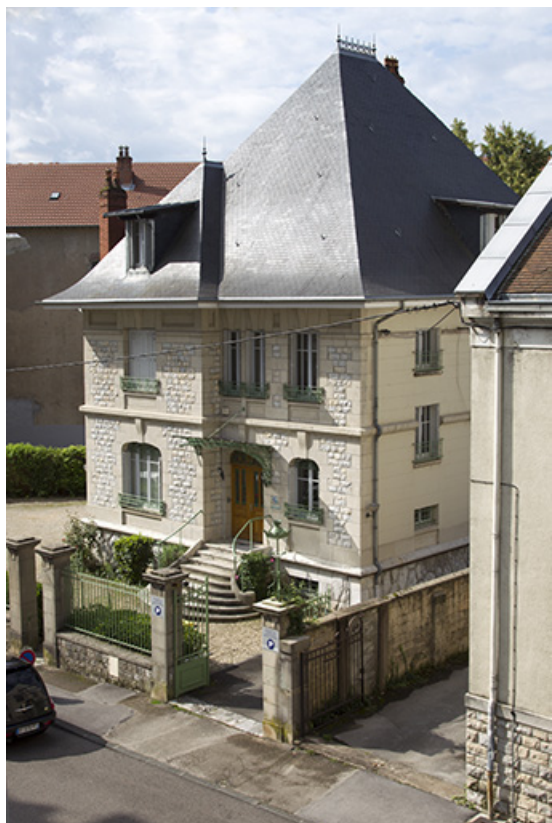
Vue plongeante sur la façade antérieure.
