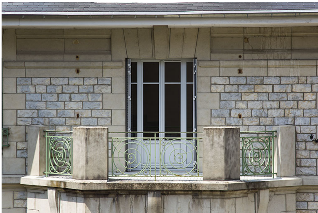
Façade latérale gauche : terrasse surmontant le bow-window.
