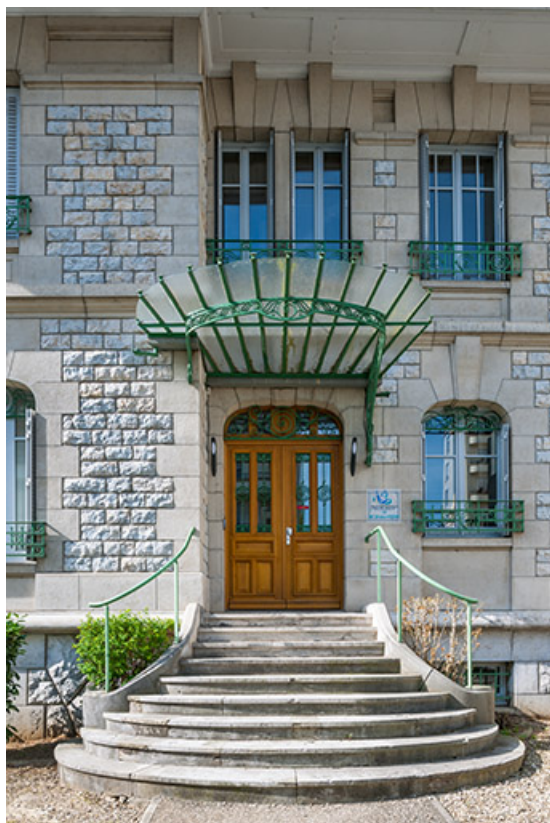
Façade antérieure : perron, entrée et marquise.
