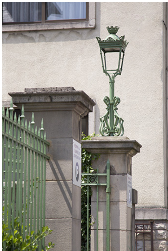
Portail : piliers, grille et luminaire.
