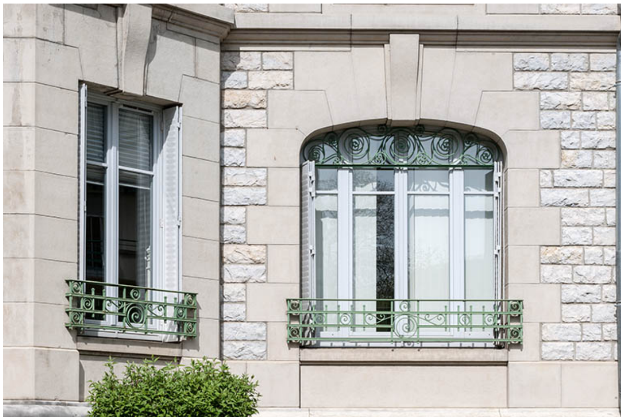
Façade latérale gauche : appareillage du mur, deux fenêtres et ferronnerie. 25, Besançon, 1 bis rue Victor Delavelle
