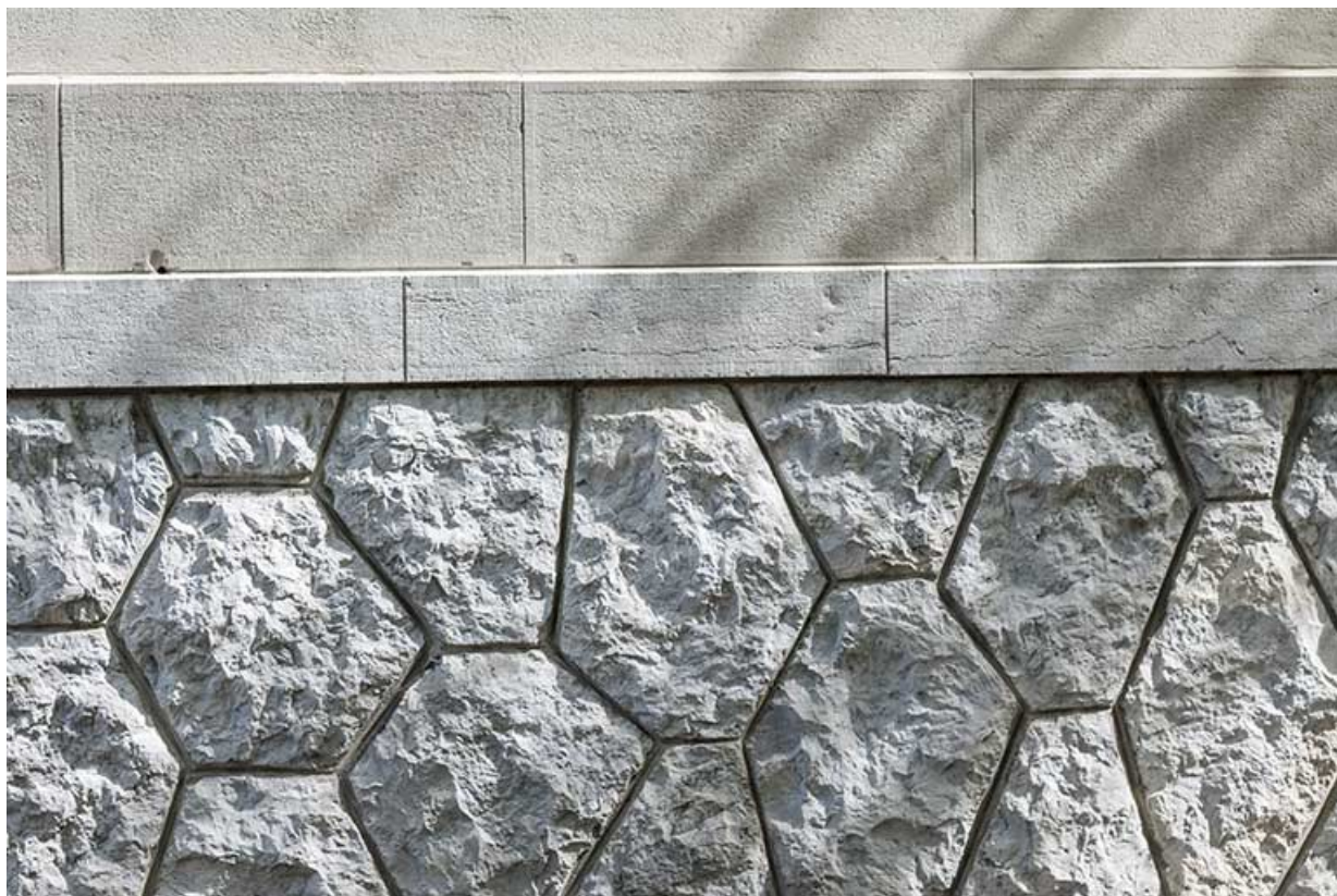
Façade postérieure : détail de l'appareil du soubassement.
