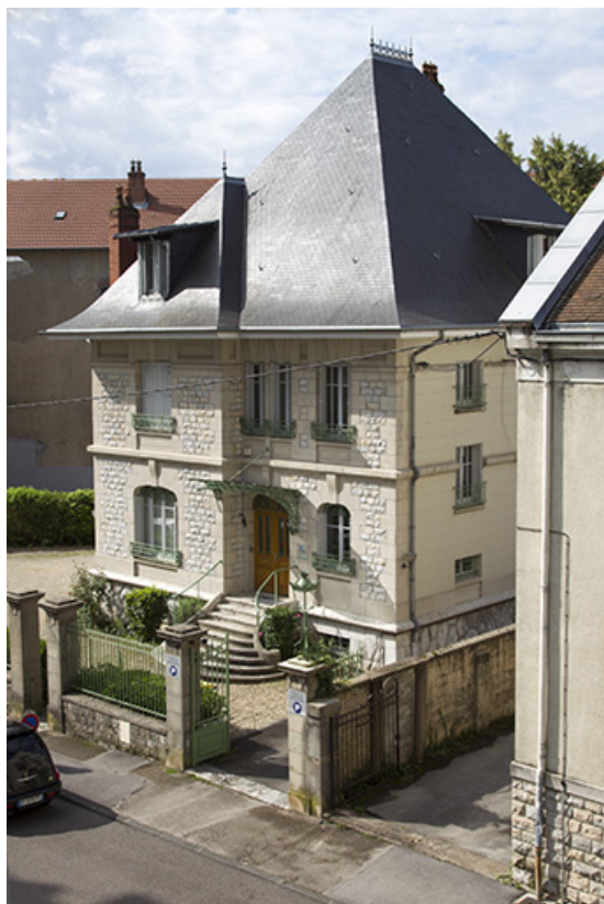
Vue plongeante sur la façade antérieure.
