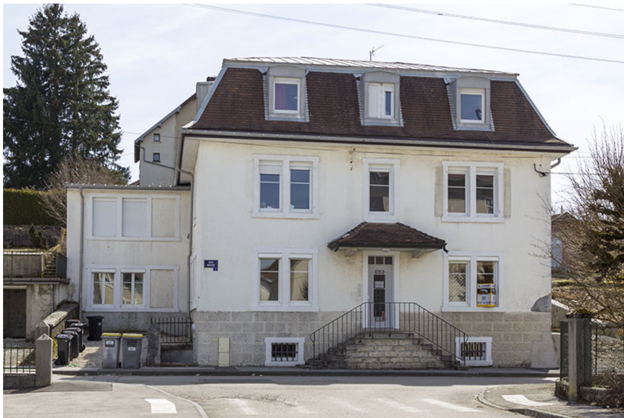
Façade antérieure. 25, Charquemont
