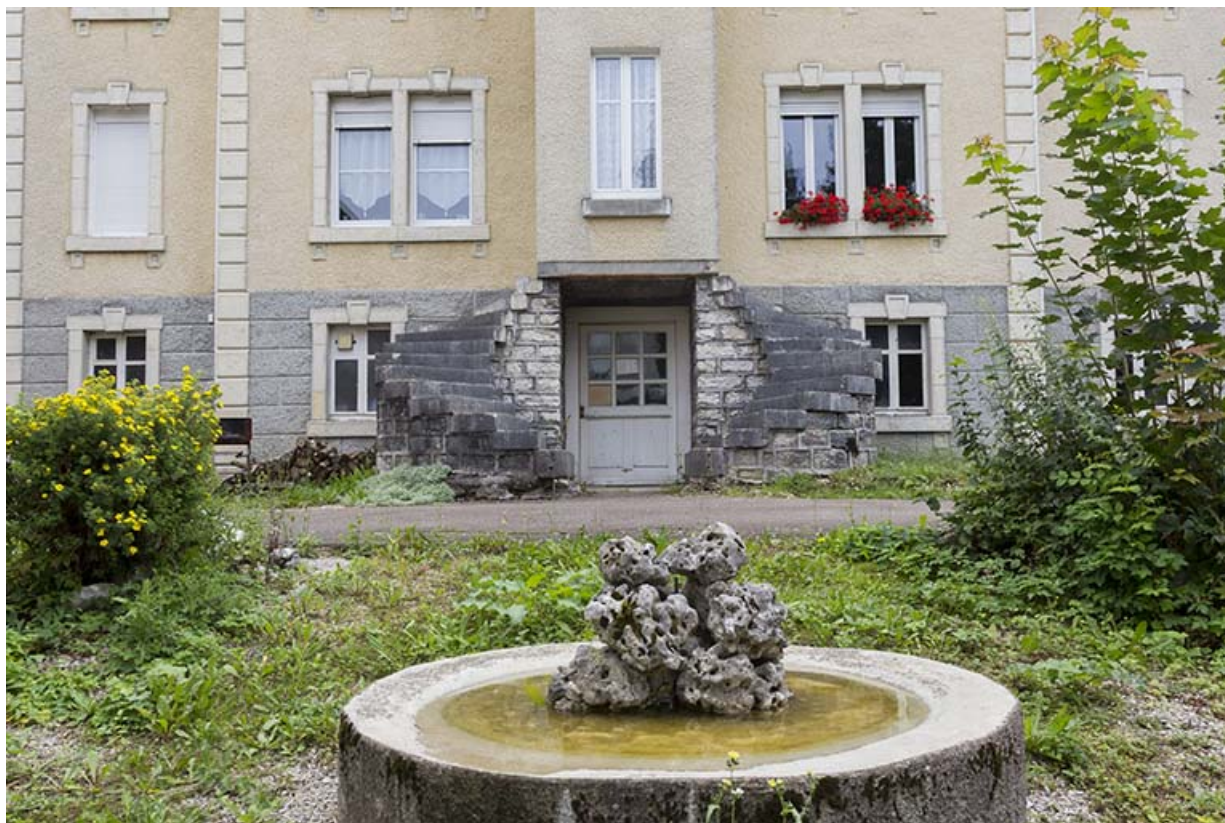
Maison : escalier et fenêtres horlogères sur la façade postérieure.
