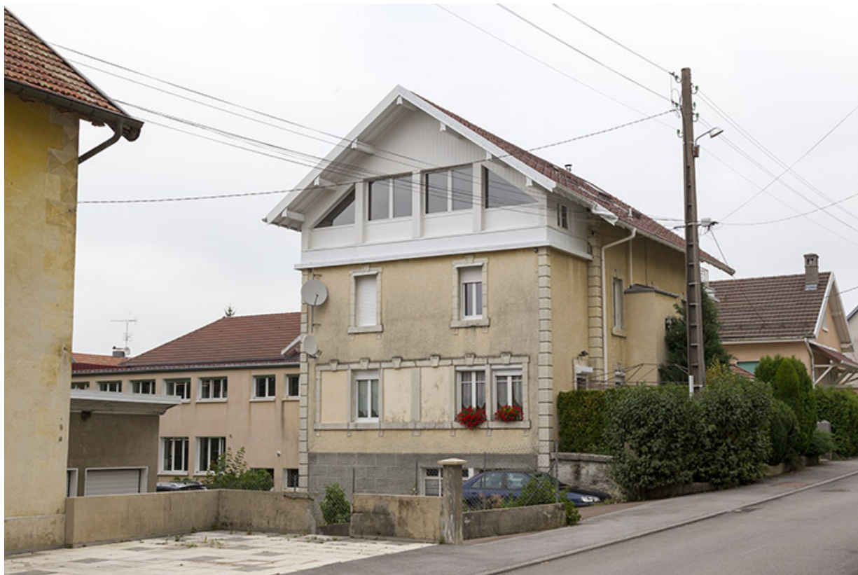
Maison : façades antérieure et latérale gauche.
