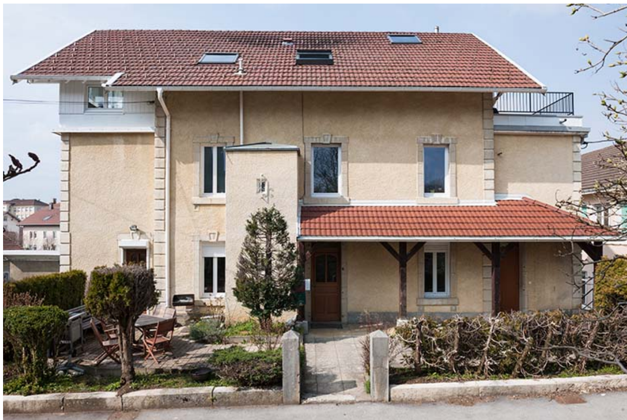
Maison : façade antérieure.
