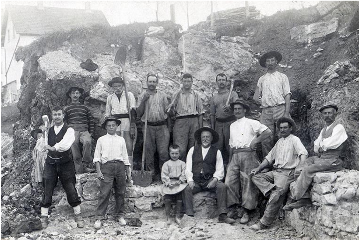
[Paul Loichot (au centre) au milieu des ouvriers construisant sa maison du 7 rue de la Gare (le jeune Jean-Louis Struchen est assis à ses côtés)], décennies 1900-1910
