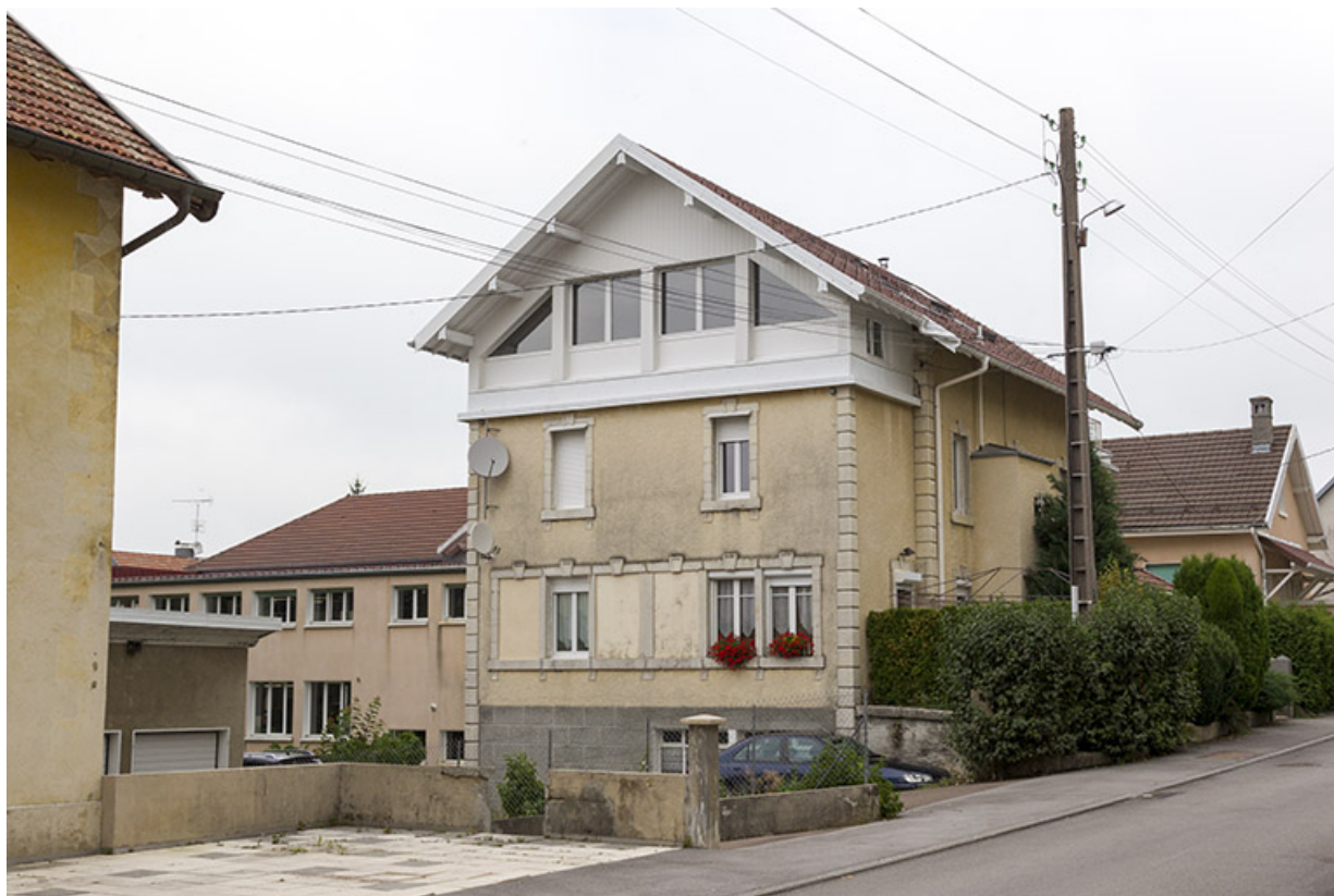
Maison : façades antérieure et latérale gauche.
