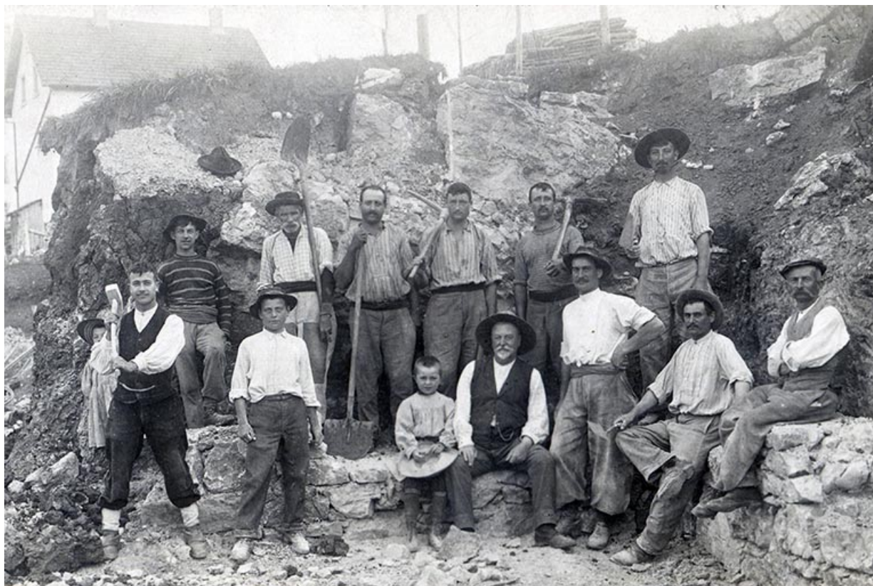
[Paul Loichot (au centre) au milieu des ouvriers construisant sa maison du 7 rue de la Gare (le jeune Jean-Louis Struchen est assis à ses côtés)], décennies 1900-1910
