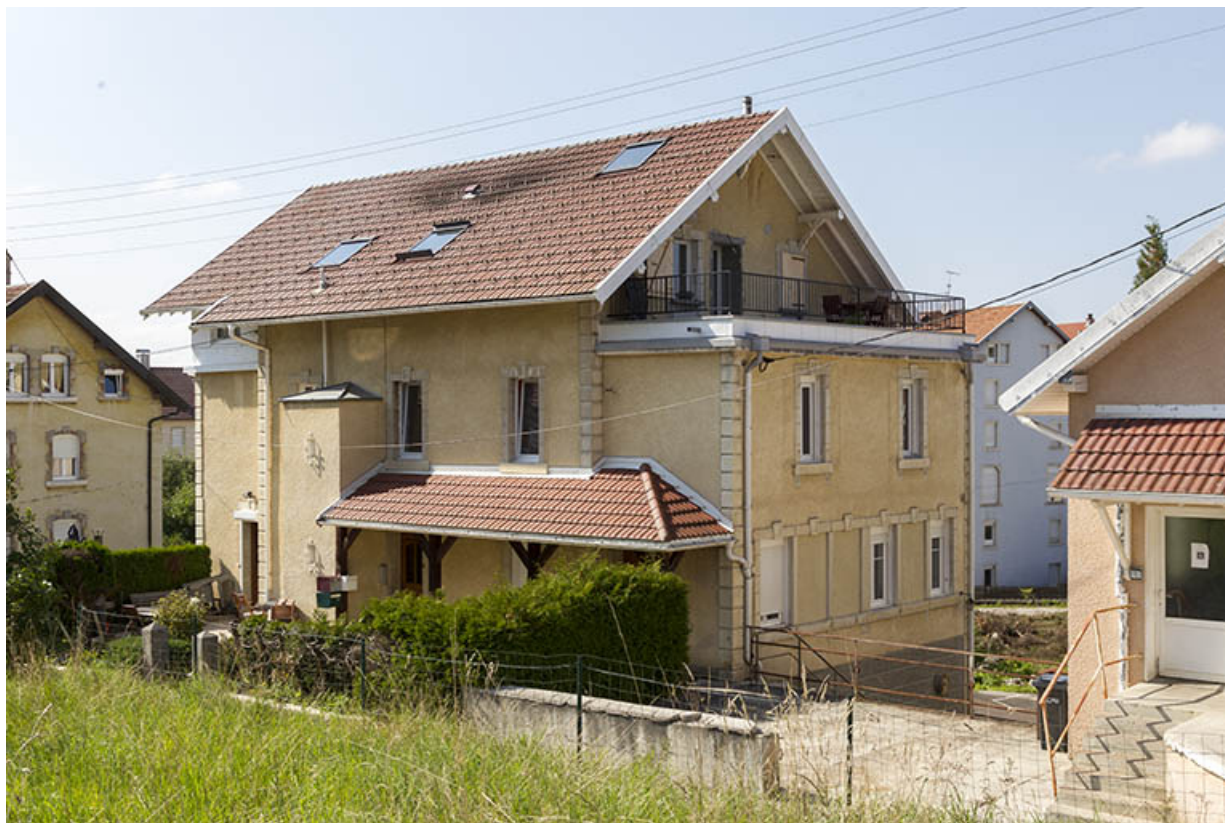
Maison : façades antérieure et latérale droite.
