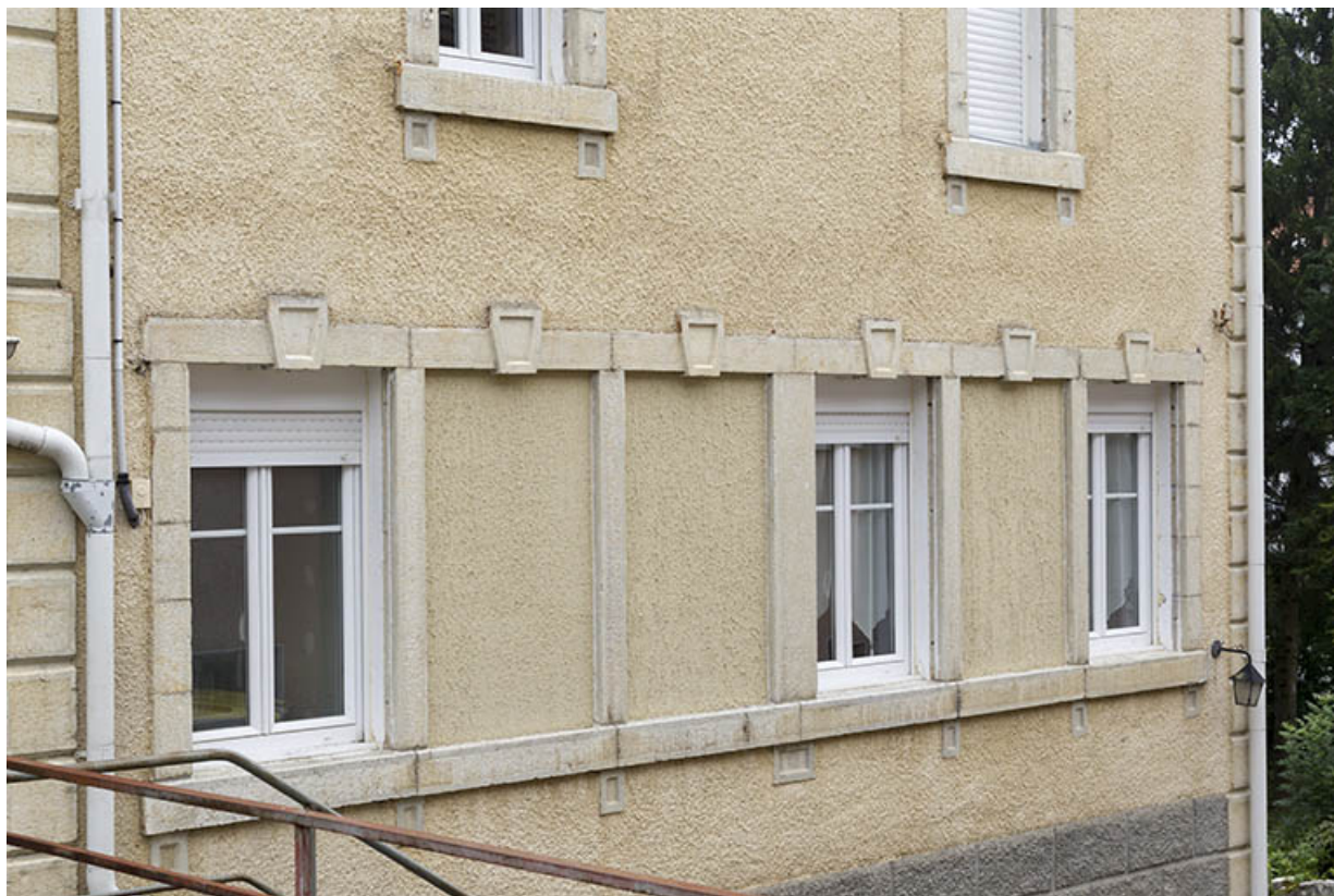
Maison : fenêtres multiples de la façade latérale droite.
