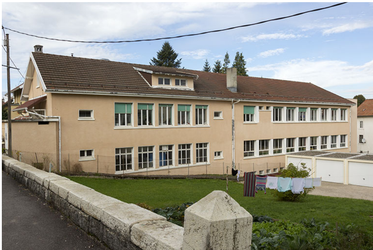
Une usine de 1937 : usine de décolletage Struchen (4 Rue Neuve). 25, Charquemont
