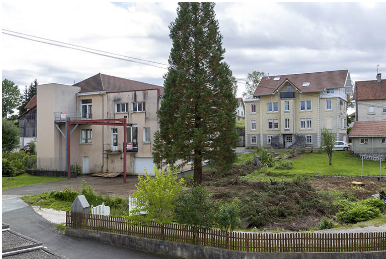
Vue d'ensemble, depuis le nord (façades postérieures). 25, Charquemont, 4 et 6 Rue Neuve
