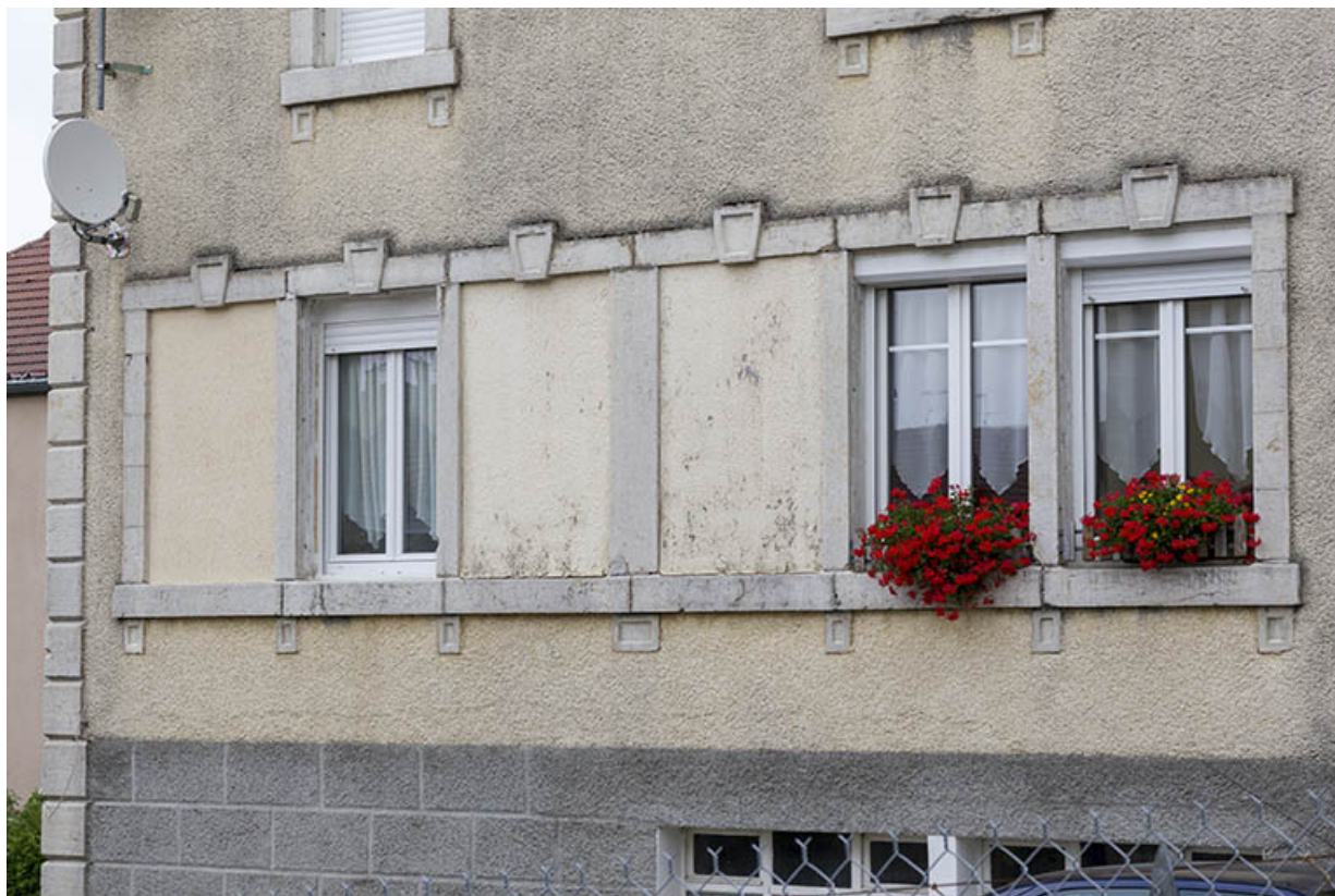
Maison : fenêtres multiples de la façade latérale gauche.
