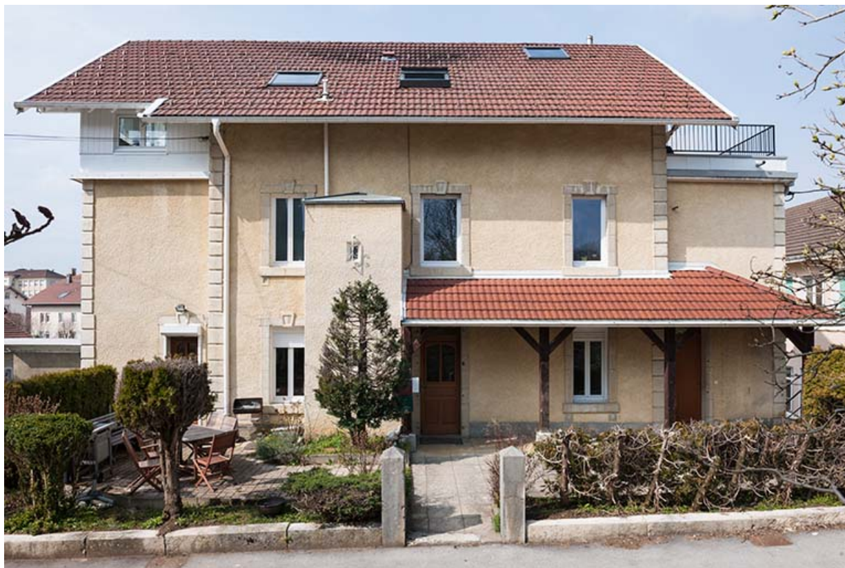
Maison : façade antérieure.
