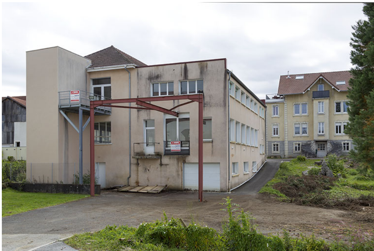
Usine : façade postérieure, de trois quarts droite.
